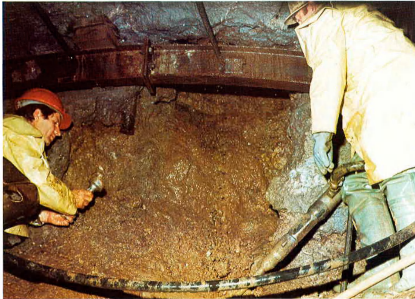
Abb. 1: Schlammbruch bei den Vortriebsarbeiten vor Anwendung der Baugrundvereisung
