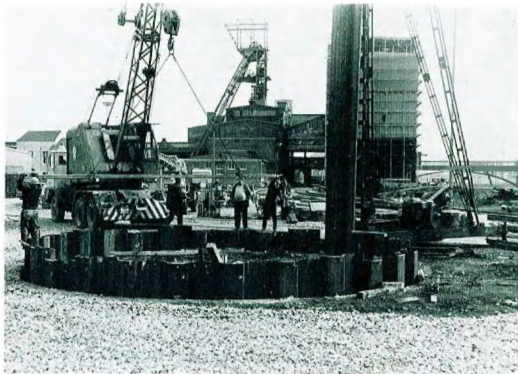
Abb. 2: Im Vordergrund: Spundkreisansatz für Schacht »Franken«. Im Hintergrund: Förderschacht »Höllbronn«
