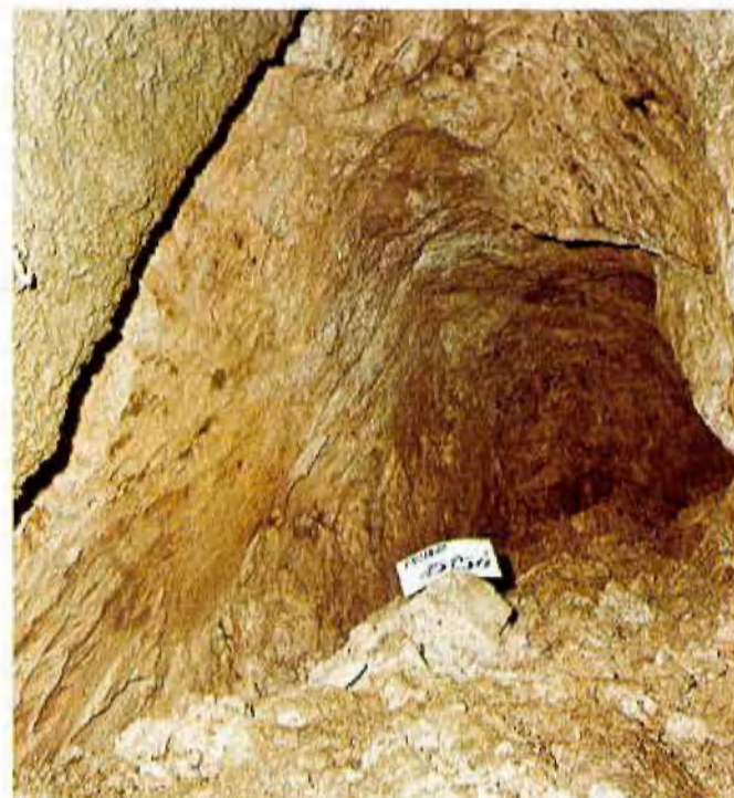
Abb. 7: Blick auf die freigelegte, seitliche gefrorene Tunnelwand
