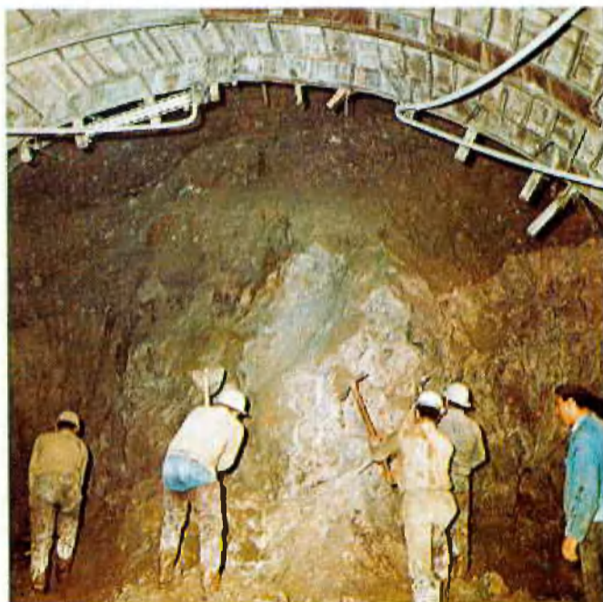
Abb. 6: Kalottenvortrieb im Schutz der Baugrundvereisung. Durch die verhinderte Wasserzufuhr von außen und die Entwässerung des Kerns brauchte kein Verbau der Ortsbrust vorgenommen zu werden. Deutlich ist die Grenze zwischen alluvialen Sanden und Zuckerdolomit zu sehen.
