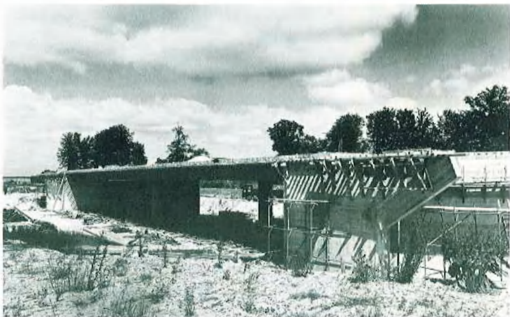
Abb. 4: Brückenbaustelle Ki17 im Zuge der B 75 bei Delmenhorst, Baujahr 1973/74
