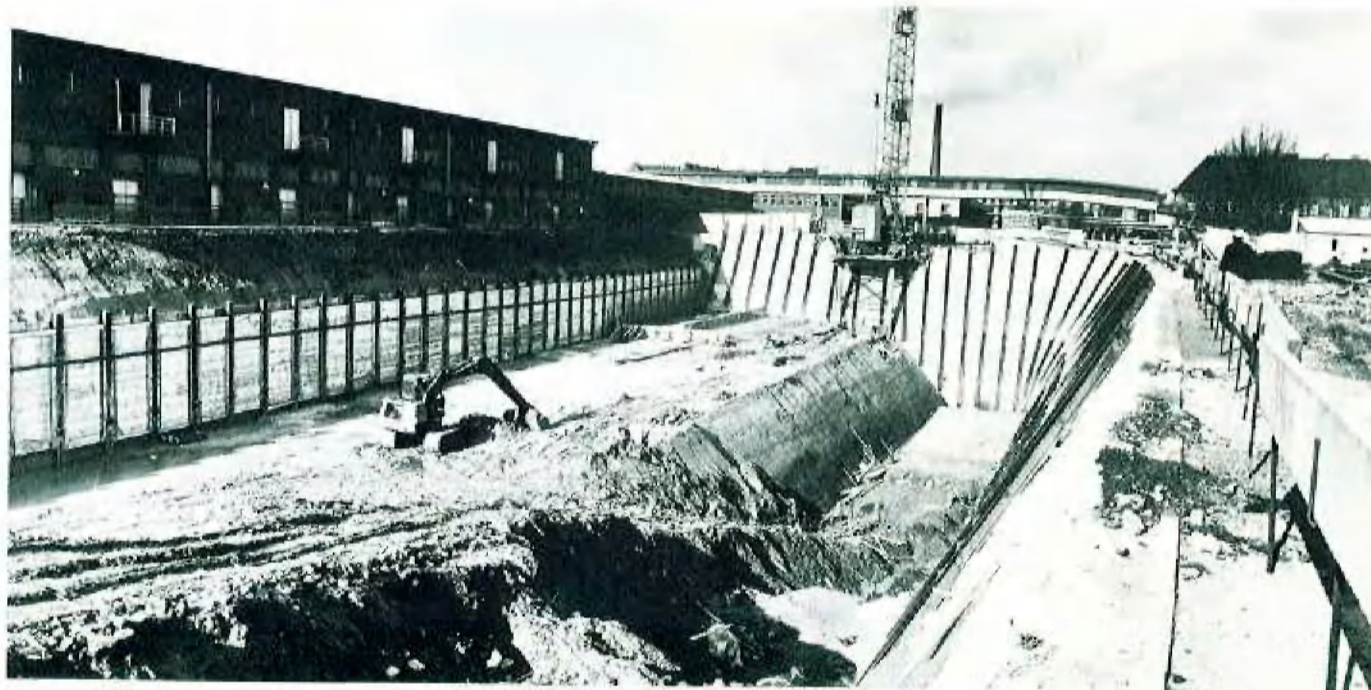
▲ Abb. 4: Baugrube im Nordabschnitt
