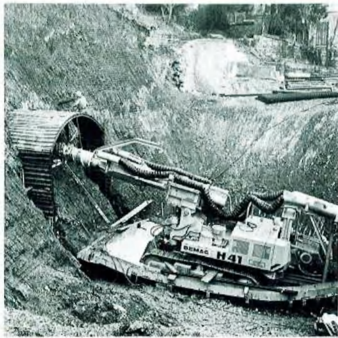
Abb. 1: Anschnitt des Mittelpfeilerstollens mit DEMAG-Schrämbagger
