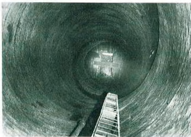
Abb. 3: Außenwendelrutsche in Bunkerwand
