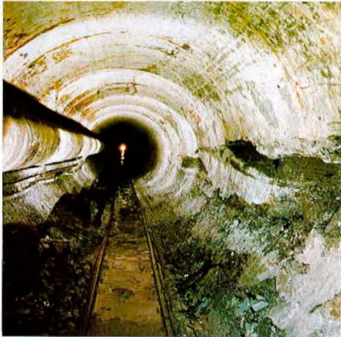
Abb. 5: Stollenröhre im Stubensandstein mit eingelagerten Schlufftonstein-Bänken
