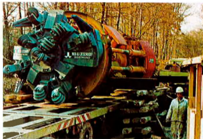
Abb. 3 und 4: Antransport der TVM zur Baustelle
