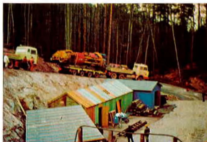
Abb. 3 und 4: Antransport der TVM zur Baustelle
