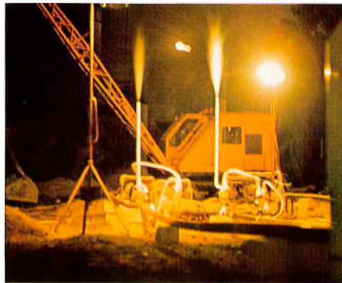
Abb. 3: Nach Aushub des Schachtes wurde der Frost auch in der Nacht erhalten
