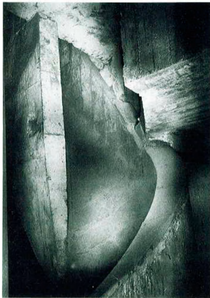
Abb. 14: Beton-Einlaufkonstruktion für Innenwendelrutschen
