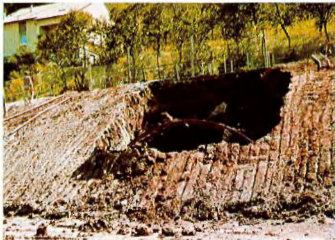
Abb. 2: Durchbruch des Mittelpfeilerstollens nach ca. 280 m Auffahrung
