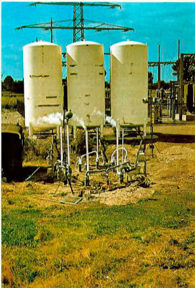
Abb. 2: Durchführung der Vereisung. Beim Austritt in die Atmosphäre wird das kalte Stickstoffgas als weiße Fahne sichtbar.
