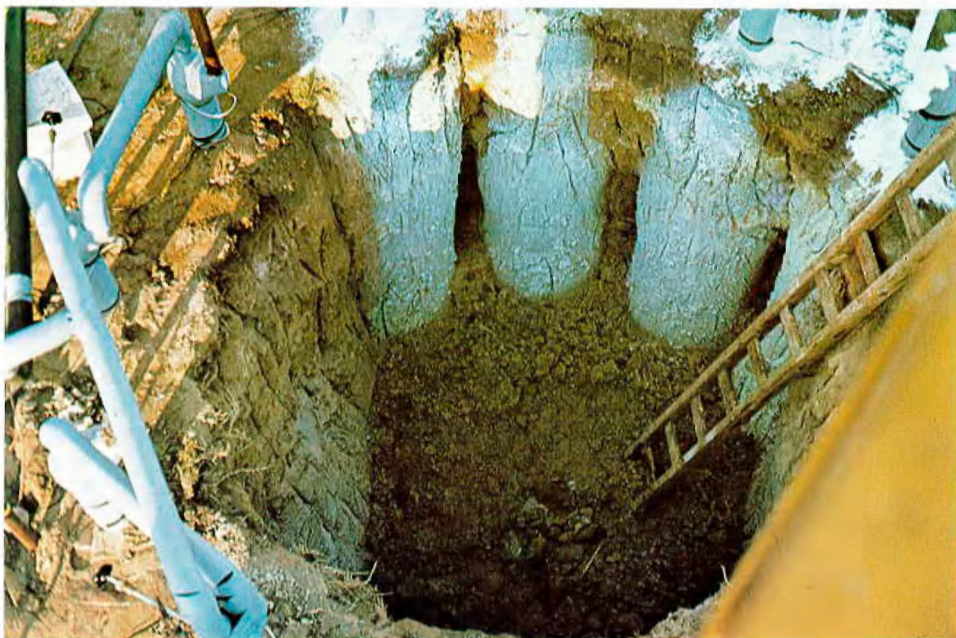
Abb. 4: Freigelegter Frostkörper. Deutlich zu erkennen ist die unterschiedlichste Ausbreitung des Frostkörpers. Links und rechts eine bis oben hin zugefrorene Frostwand. In der Mitte hat die Frostausbreitung noch nicht zu einem Zusammenschluß des um die einzelnen Gefrierrohre gebildeten Frostkörpers geführt.
