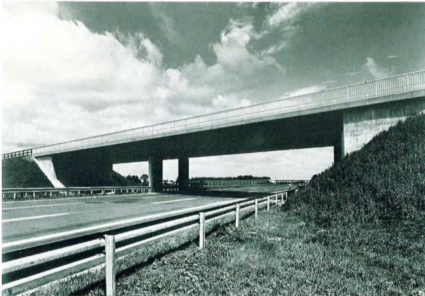
Abb. 1: Brücke ZW 6 im Zuge der B 75 bei Bad Zwischenahn Baujahr 1973/74
