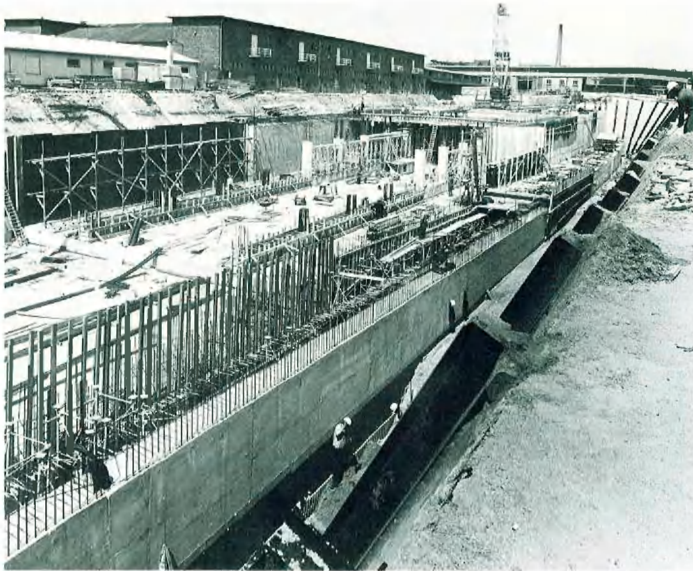
Abb. 6: Betonarbeiten im Nordabschnitt
