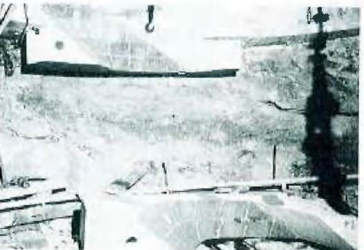
Abb. 16: Stein Nr. 40 untergehängt, Stein Nr. 41 vor der Mon- tage
