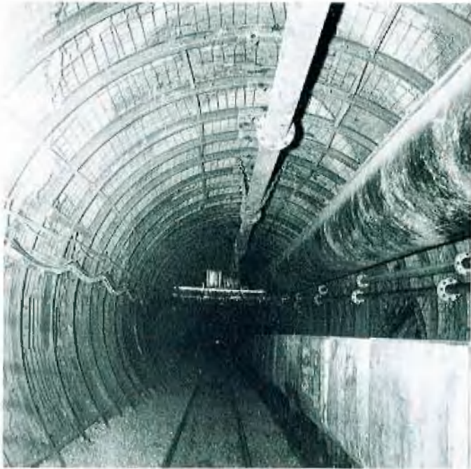
Abb. 6: Vollmechanisch aufgefahrne Gesteinsstrecke
