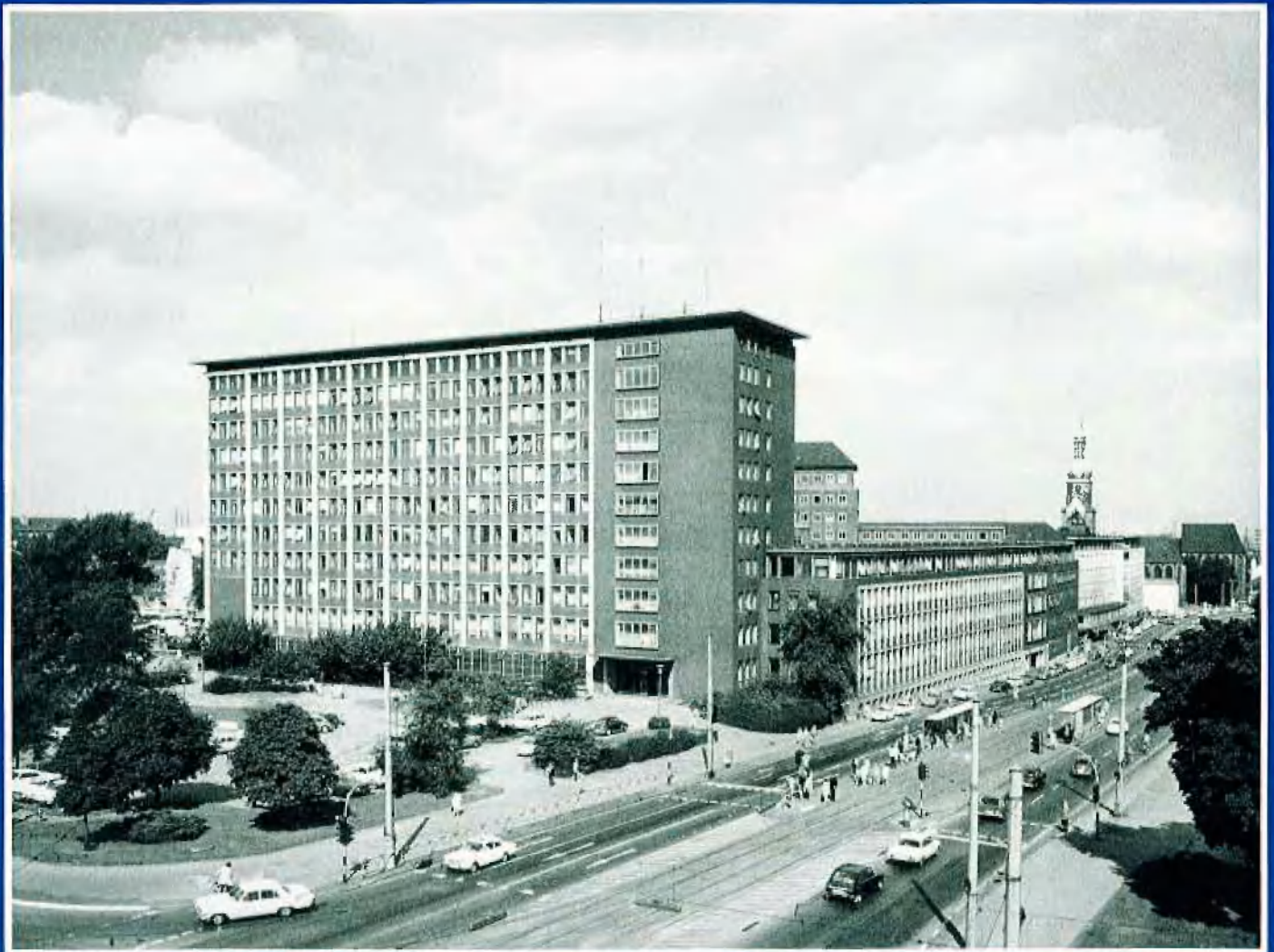
Die Dortmunder City war bei Kriegsende zu 93 % zerstört. Mit der großzügigen Neuplanung kamen auch breite Verkehrsachsen. Hier eine der Hauptkreuzungen (Neutor) vor dem Stadthaus.
