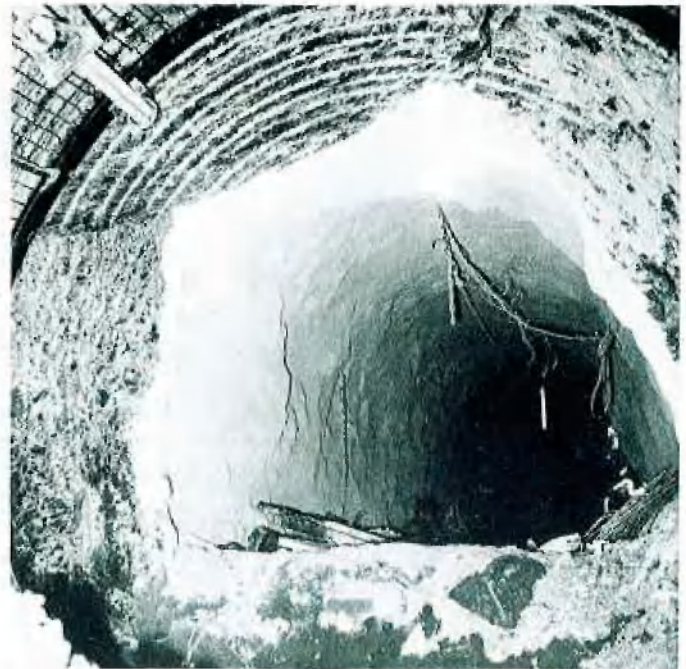
Abb. 7: Durchschlag im Bereich des Blindschachtes N 731
