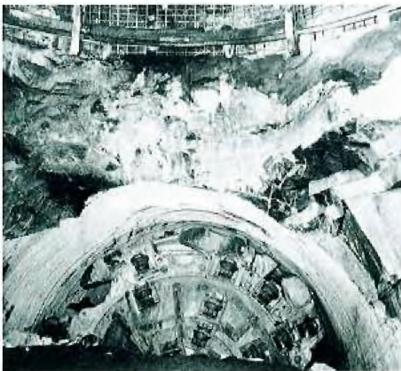
Abb. 5: Durchschlag Schacht 5 mit der 7. Sohle
