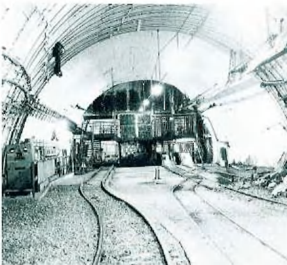
Abb. 4: Östl. Füllort, Schacht 4.-7. Sohle
