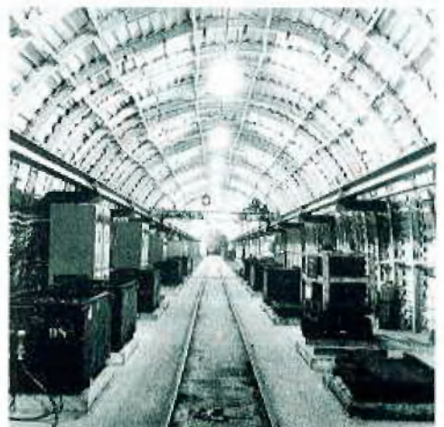
Abb. 14: Laderaum am Schacht, 7. Sohle
