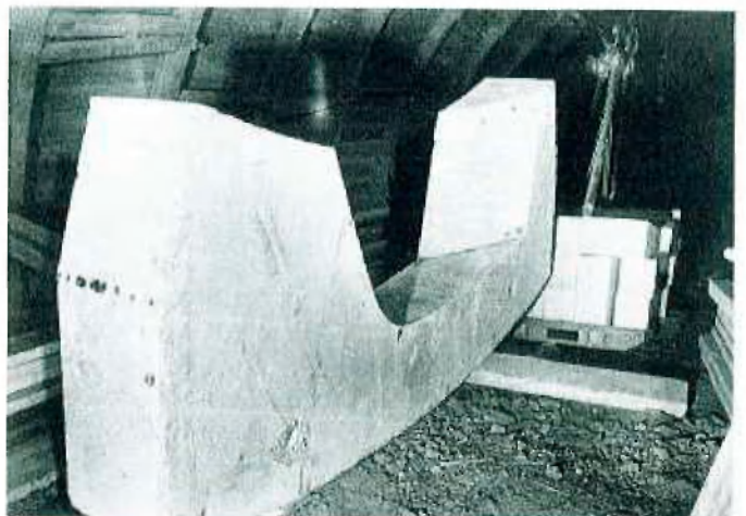
Abb. 8: Wendelstein (Stahlbetonfertigteile)
