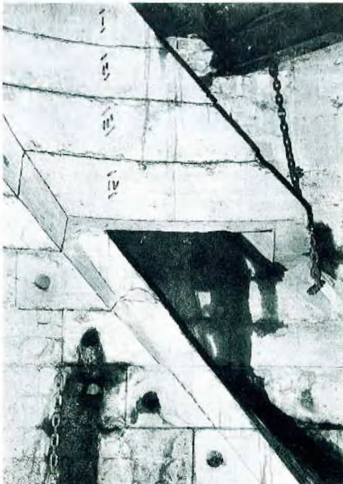
Abb. 10: Einlauf Bunker I
