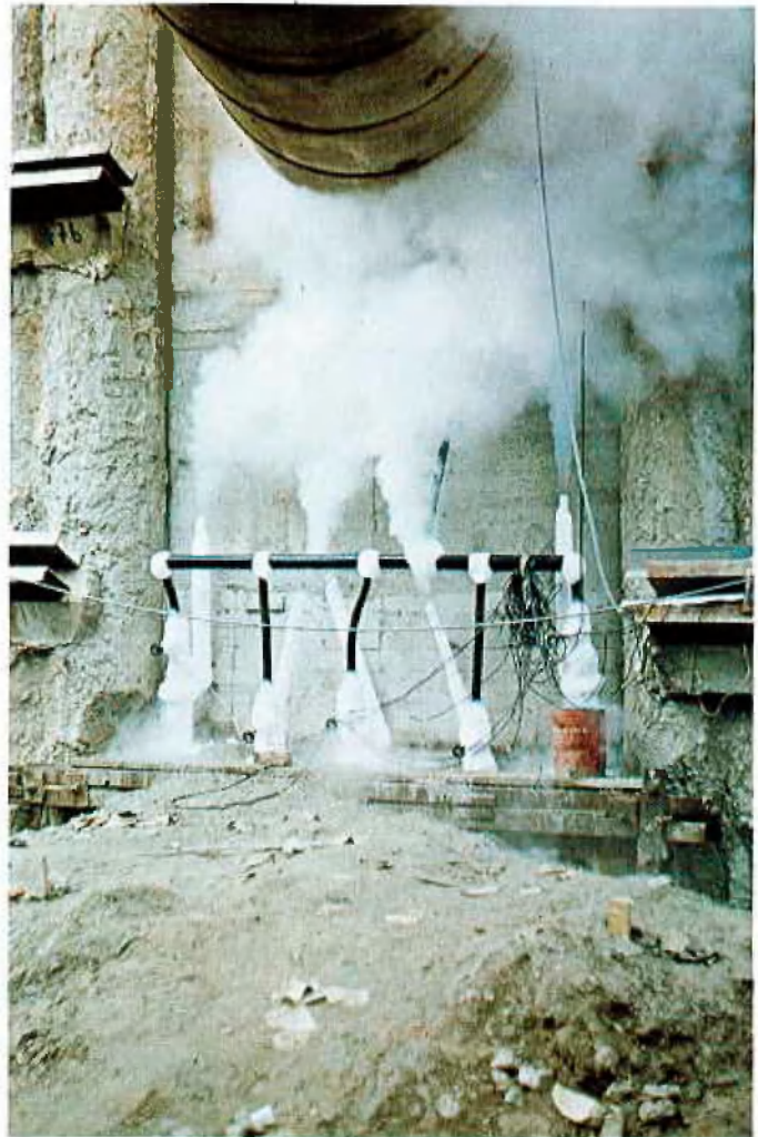
Abb. 2: Herstellen des Frostkörpers. Verteilerleitung für die Flüssig-Stickstoff-Zufuhr in die Gefrierrohre
