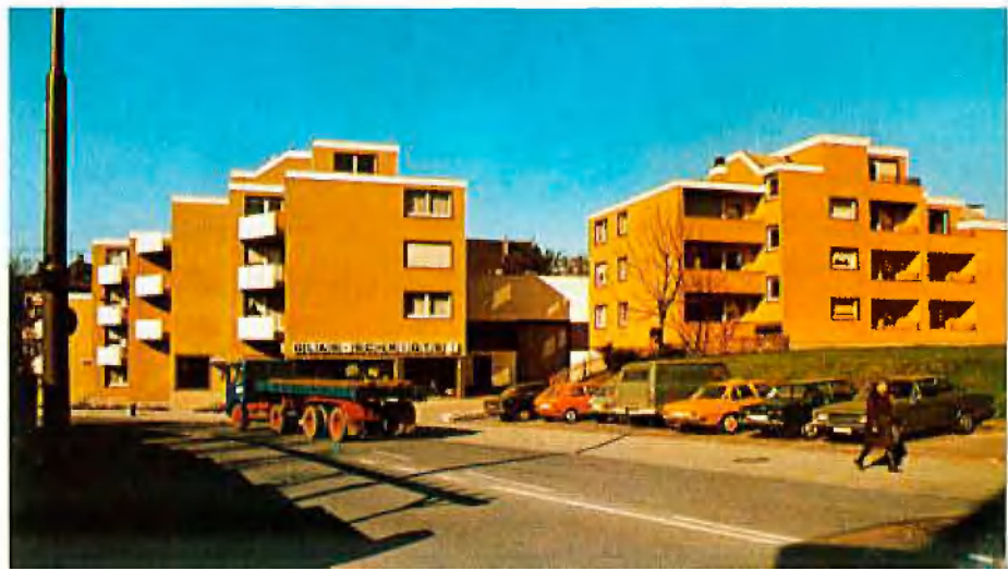
Wohnanlage Hattingen, Wülfingstraße 24 WE mit Glaserei und 10 Garagen. Baujahr 1974/75 Südansicht
