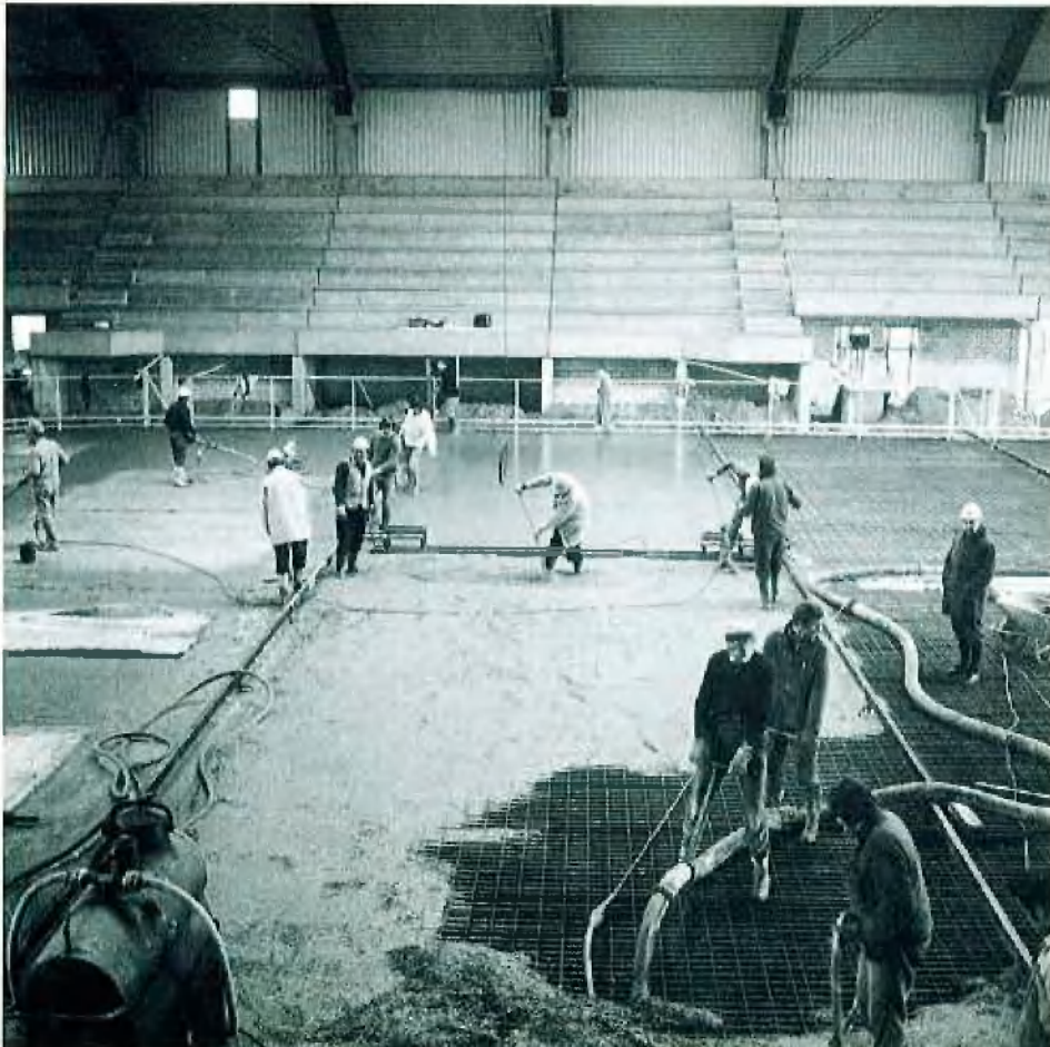
Einbringen, Abziehen und Vakuumieren des Betons, Einstreuen der Hartstoffe und Glätten der Oberfläche
