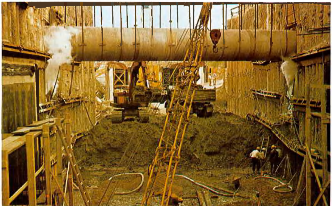
Abb. 2: Herstellen des Frostkörpers. Verteilerleitung für die Flüssig-Stickstoff-Zufuhr in die Gefrierrohre
