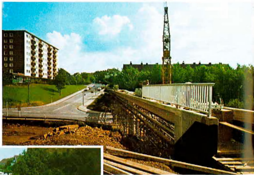
Brückenbauwerk nach Fertigstellung, Aufbringen des Leuchtgeländers
