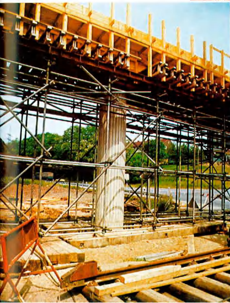
Mittelpfäiler \varnothing 900 aus Stahlbeton. Rundschalung aus Einzelbrettern gehobelt
