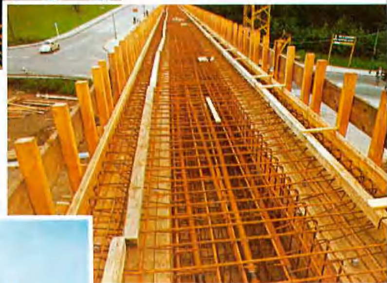
Obere Bewehrungseinlage fertig für den Betonvorgang
