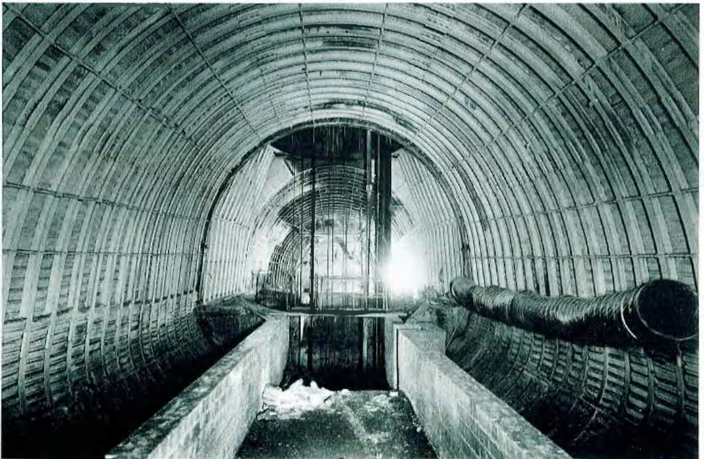
Abb. 1: Füllort 940-m-Sohle in geschlossener Bauweise
