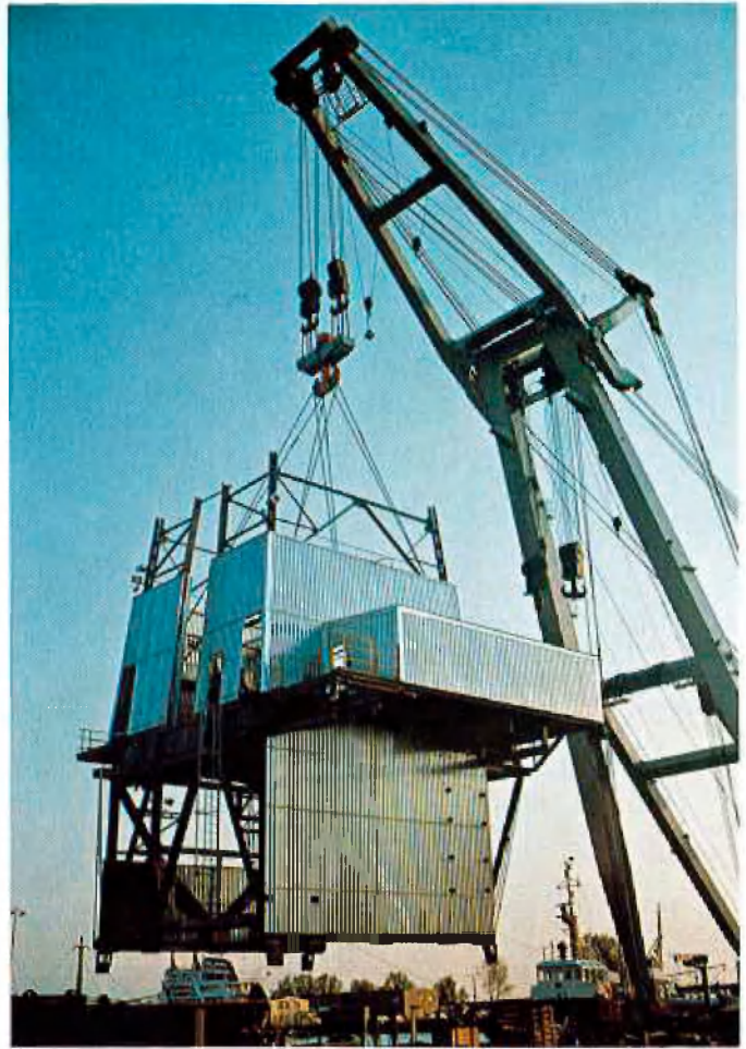
Verladen des Bohrturmunterbaus mit 1. Turmsection in Bremerhaven
