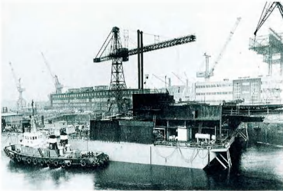
Blick auf Hauptdeck und Aufbauten mit Hubschrauber-Deck sowie noch offenem Zement- und Kesselraum
