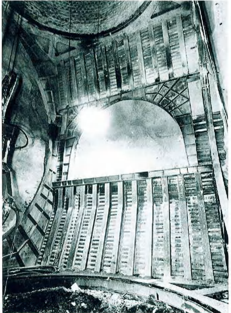
Abb. 2: Füllort 1060-m-Sohle Zu erkennen ist der Ansatz der Maschinenkammer für das evtl. spätere Tieferteufen
