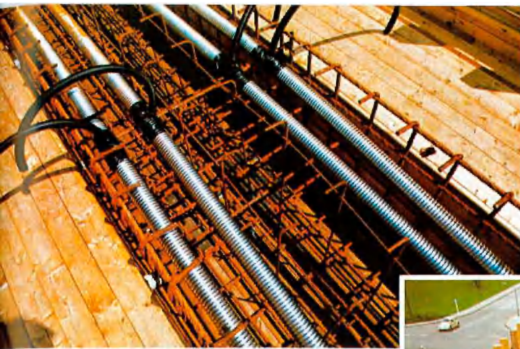
Entlüftungsstellen der Spannglieder bei dem Injizierungsprozess untere Bewehrungseinlage
