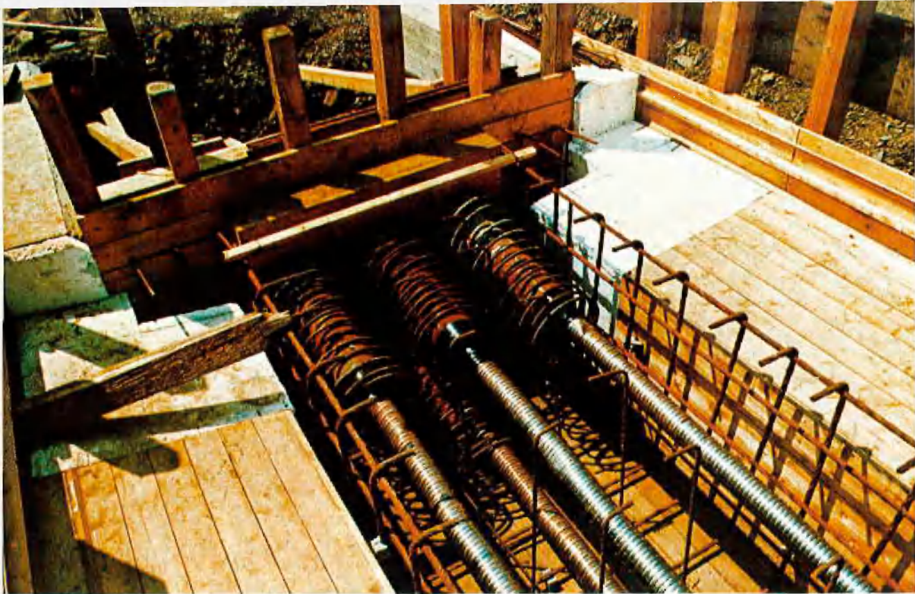
Widerlager Nord mit Spannbetonankern. Spanngliederlänge 69,19 m
