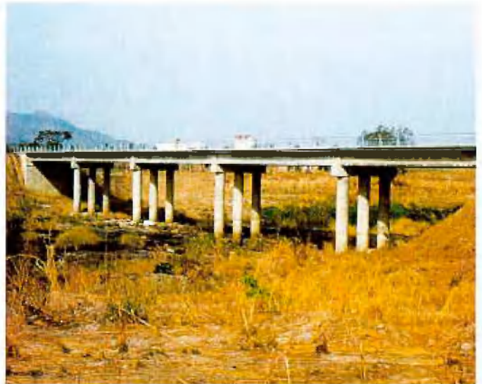
Erste große Stahlbetonbrücke in Togo
