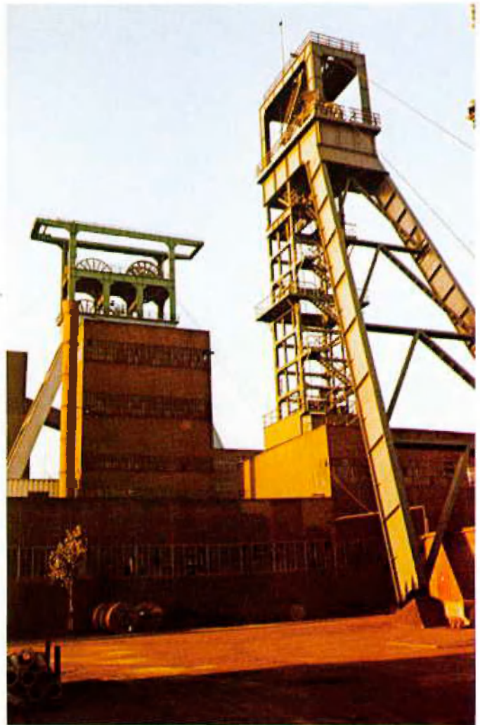
Abb. 1: Schachtanlage Pattberg; von Schacht 2
