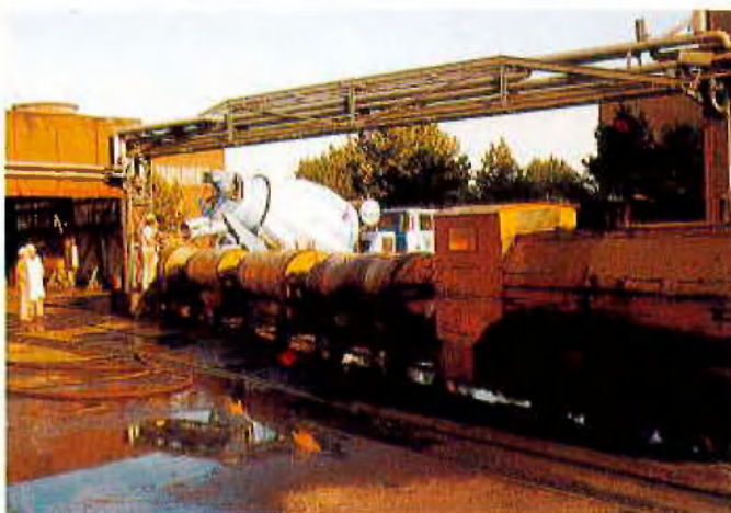
Abb. 5: Beschicken der Betonnachmischer
