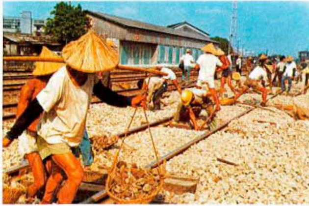
Abb. 5: Gleisunterhaltung mit der Rotte, Bettungserneuerung im nicht gesperrten Gleis
