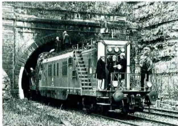
Abb. 1: Tunnelprüfwagen der DB am Tullauer Tunnel
