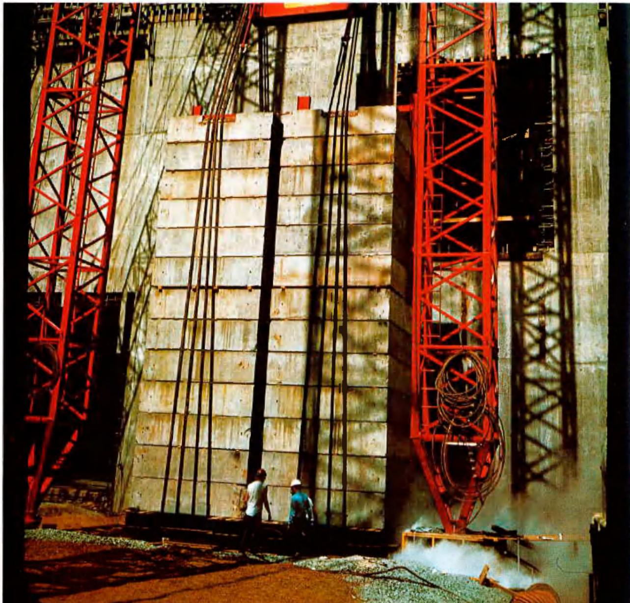
Abb. 6: Probelastungsversuch. Rechts ist einer der vereisten Caissons zu sehen
