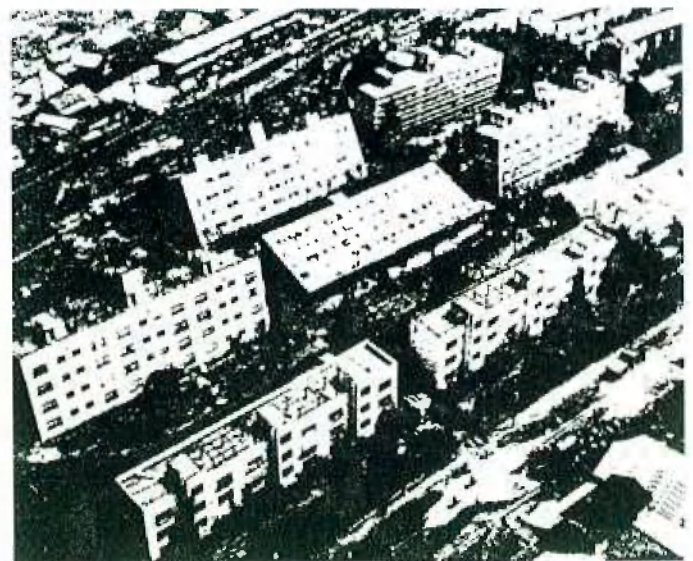
Abbildung 12: Auswirkungen eines Erdbebens auf Bauwerke mit Schwimmsand im Untergrund
