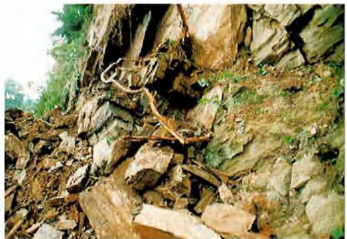
Abb. 4: Anstich einer Störzone in der Südwand mit Abrutschung („Velberter Schichten“)
