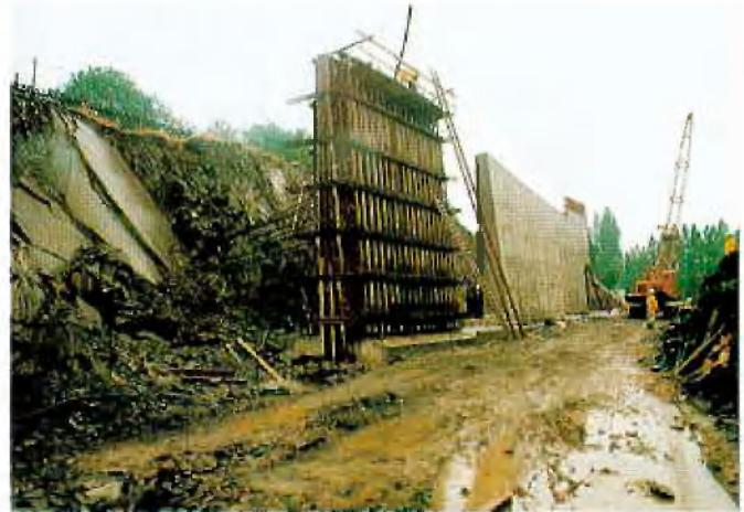
Abb. 3: Winkelstützwände im Übergangsbereich (rechts verwitterter Fels Kl. 6, links kompakter Fels Kl. 7)
