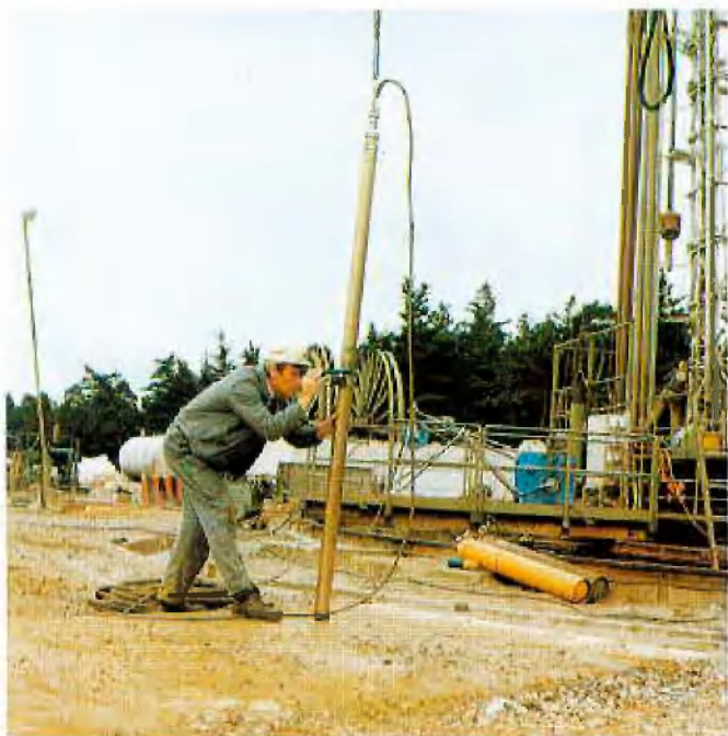
Abb. 4: Einmessen des Kreiselgerätes
