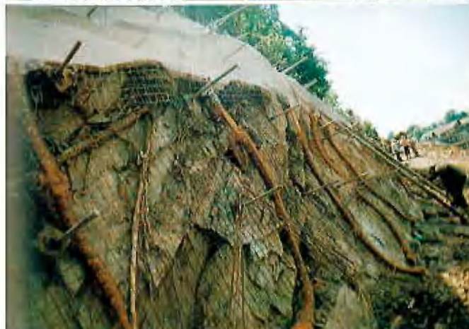
Abb. 7: Nordwand: Felssicherung mit Ankern und BSTG N 94 (vor dem Aufbringen des Spritzbetons)
