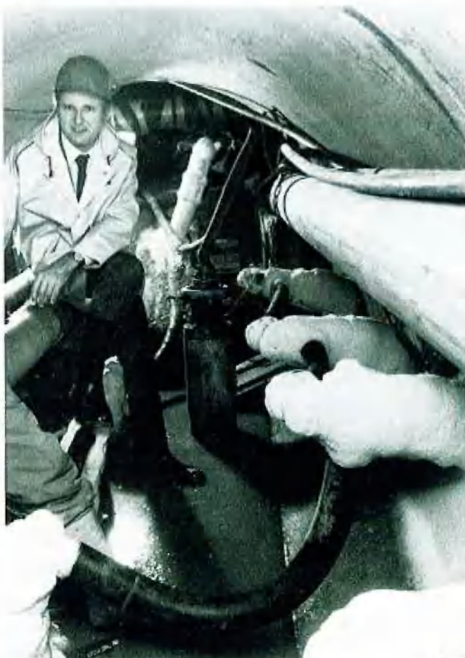
ZWEI METER im Durchmesser mißt die Betonröhre, durch die die Vereisungsleitungen laufen. Im Bild Baudezernent Peter Steckeweh.
