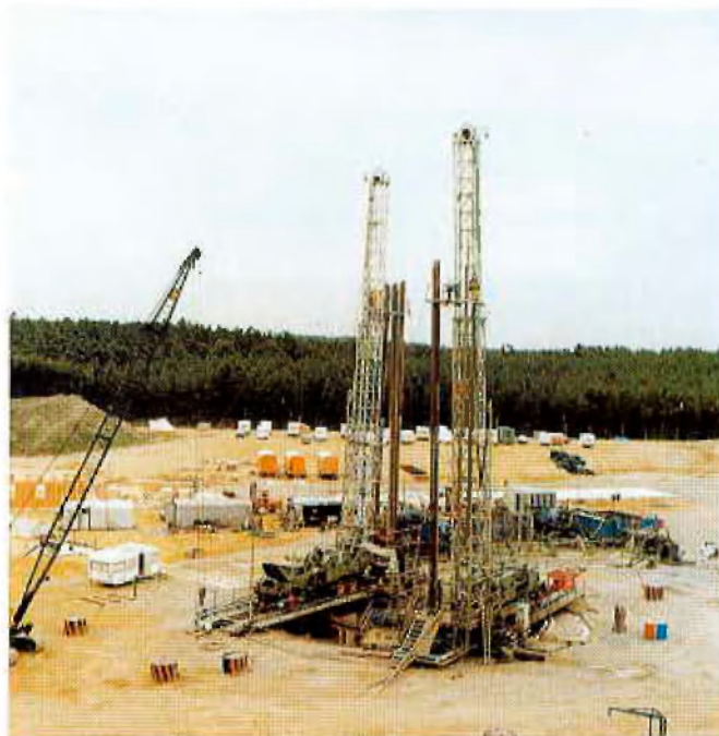
Abb. 1: Gesamtübersicht der Baustelle
