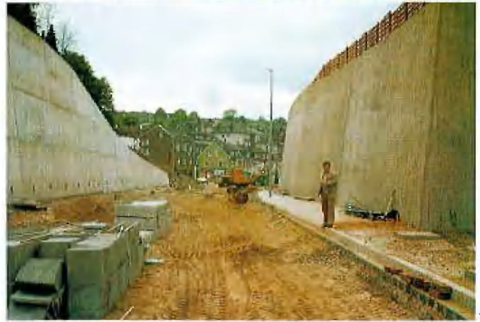
Abb. 7: Nordwand: Felssicherung mit Ankern und BSTG N 94 (vor dem Aufbringen des Spritzbetons)
