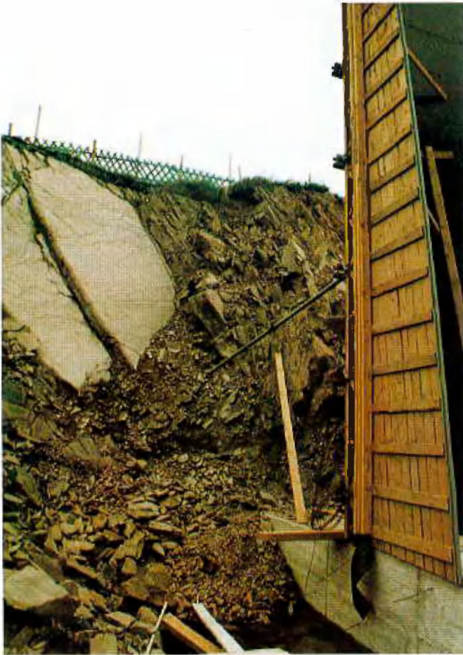
Abb. 5: Nordwand: stark klüftiger Fels mit ausgeprägten Rutschflächen (rechts Stirnschalung der Winkelstützwand)
