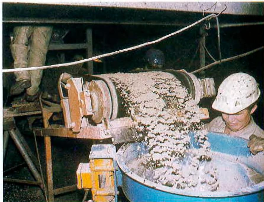
Abb. 5: Beschickung der Spritzmaschine
