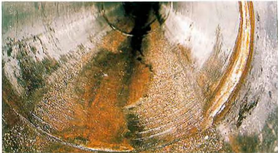
Abb. 1: Korrodierte Kanalsole
