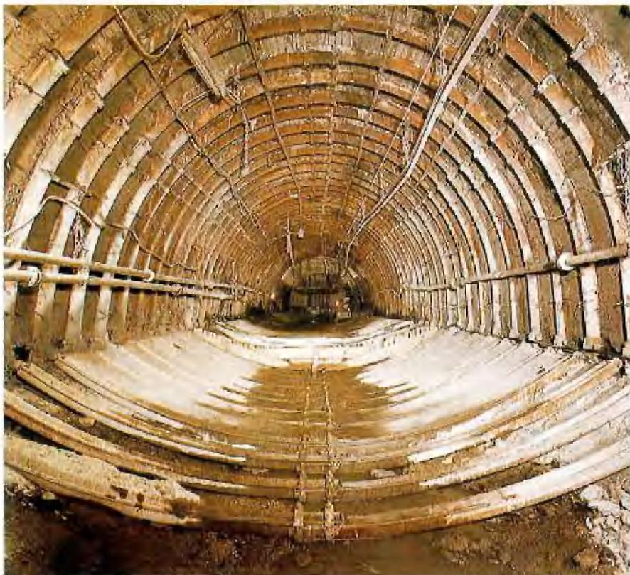
biegefesten Stößen und aufgeschweißten U-Eisen gesetzt worden. Desweiteren sind im Trägersteg Bohrungen vorgesehen worden, durch die die Baue mit 2,50 m langen Klebean kern noch weitgehend stabilisiert werden konnten. Trotz des gebrächen Gebirges stellten sich aufgrund dieser Zusatzmaßnahmen beim Unterfahren der genannten Bauabschnitte keine Absenkungen des Ausbaus ein.
