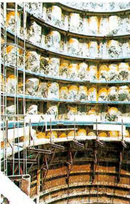
Abb. 7: Verschrauben eines Ausbauringes
