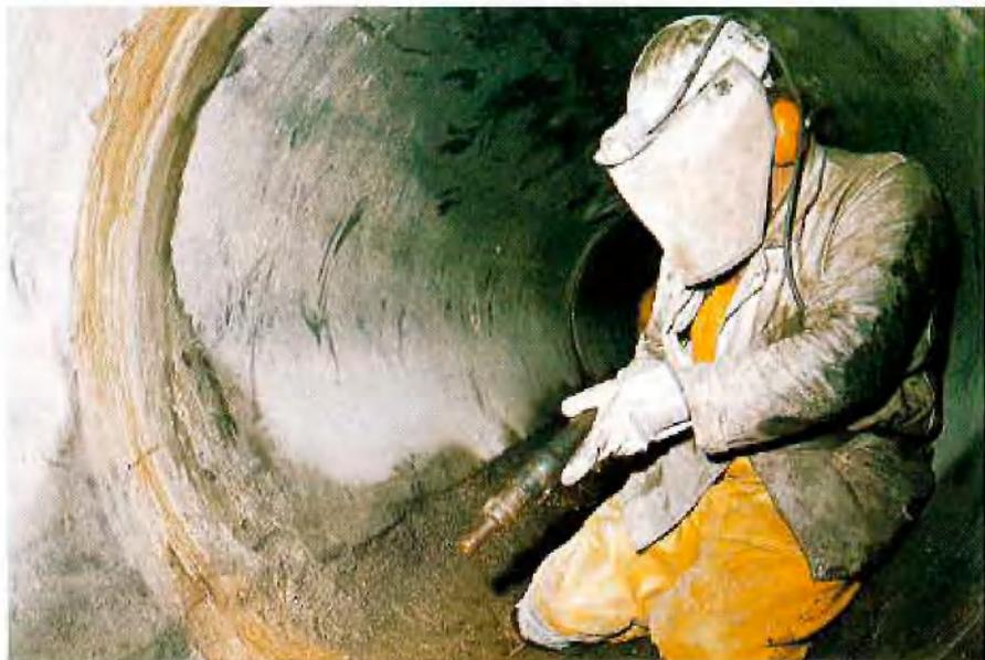
Abb. 3: Aufbringen des Ausgleichsmörtels
