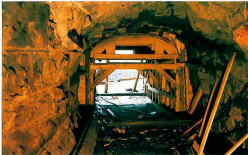
Holzschalung für die Stahlbetonauskleidung
