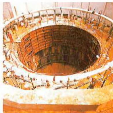
Nach dem Bau des Gefrierkellers wurde mit der Montage des Rohrleitungssystems für den Kälte-trägerkreislauf der Vorschacht im Schutz einer zuvor eingebrachten Bohrpfehlwand abgeteuft und mit Stahlbetonringen ausgebaut.
