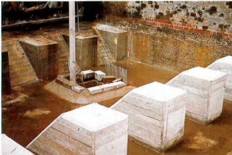
Abb. 5: Drempeaufhöhung des Unterhauptes mit Hilfspumpensumpf
