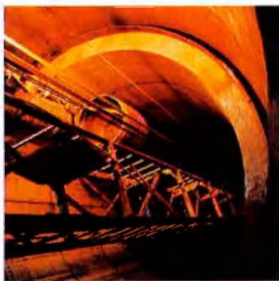
Nach dem Umbau der Teufeinrichtungen wurde im standfesten Gebirge mit Bohr- und Sprengarbeit abgeteuft. Von April bis Oktober 1979 wurden im Deckgebirge 650 m fertiger Schacht hergestellt.
