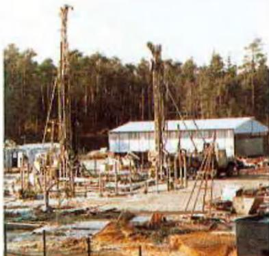
Die Herstellung der Gefrierbohrlöcher bis zu einer Teufe von 153,5 m erfolgte mit 2 Rotary-Bohrgeräten. Parallel dazu liefen die Bauarbeiten für die Fundamente der Abteufarbeiten und die Montage der Einrichtungen. Die Bohrarbeiten waren Anfang März 1978 beendet.
