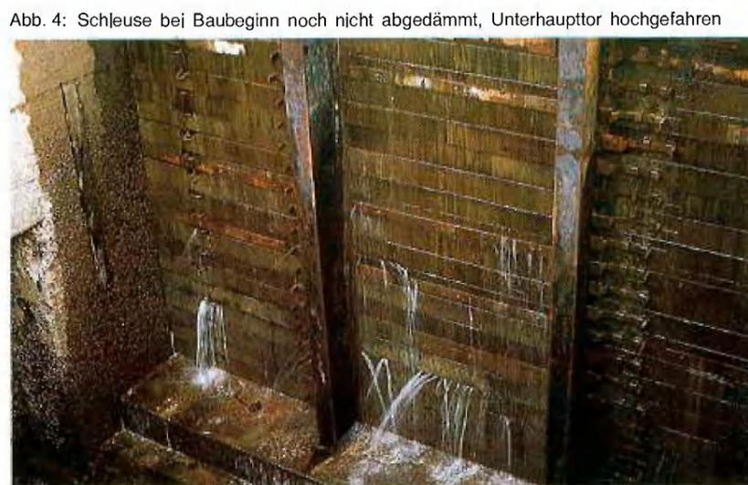
Abb. 4: Schleuse bei Baubeginn noch nicht abgedämmt, Unterhaupttor hochgefahren
