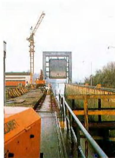
Abb. 3: Schalung und Arbeitsbühne des 1. Blockes, hochgefahrenes Unterhaupttor
