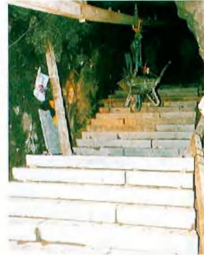
Nach dem Durchschlag des Stollens in die Felsenkirche wurde mit den Ausbauarbeiten begonnen. Die anstehende Felslaibung wurde sorgfältig von losen Teilen gereinigt; ein besonderer Ausbau mit einer Stahlbetonschale war nur im Eingangsbereich auf den ersten 6 Metern notwendig. Ansonsten steht der Stollen „natur“.
