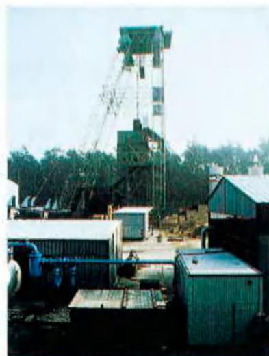
Während der Herstellung der Frostwand um den späteren Schacht herum wurde die Abteuf-einrichtung mit Turm, Fördermaschine, Winden und allen übrigen notwendigen Einrichtungen montiert.
