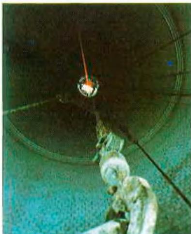
Ende November 1978 war bereits die Teufe 170 m erreicht und die Ausbauarbeiten des Gefrierteils konnten beginnen. Für das Ausbaufundament wurde die Bewehrung eingebaut.
