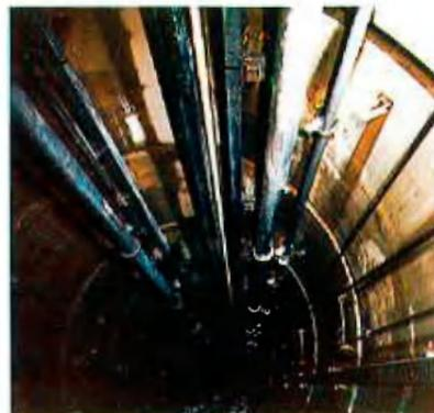
Der mit Spurlatten und Rohrleitungen ausgerüstete fertige Schacht.
