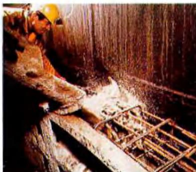
Das obere Ende des wasserdichten Ausbaus im Gefrierteil.
