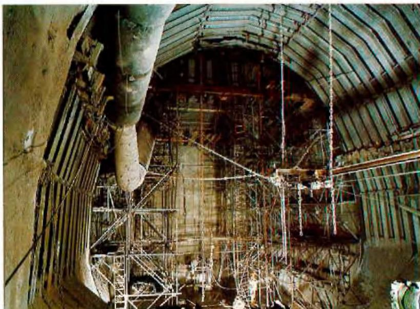
Abb. 2: Blick in den Großraum Schachtglocke und Füllort bei der Schachtunterföhren Grimberg 2 auf der 960-m-Sohle
