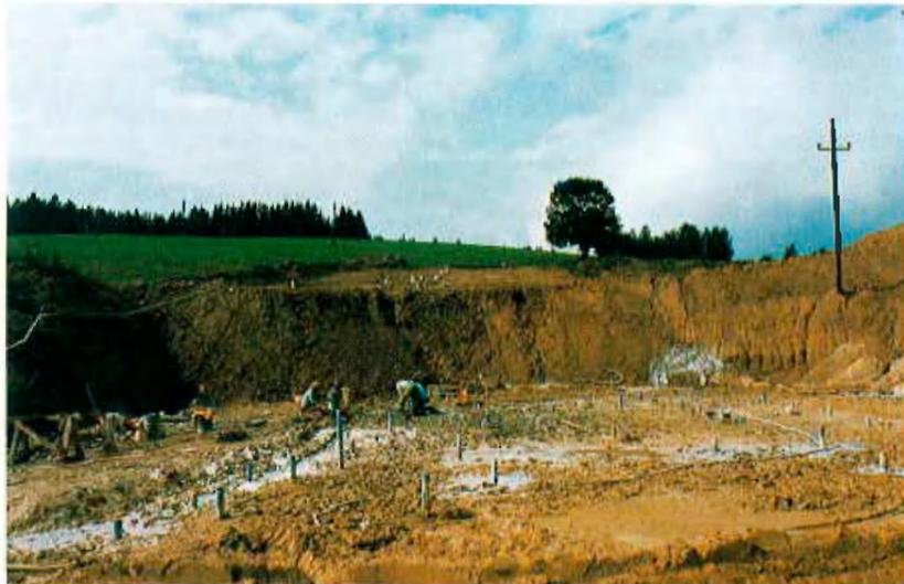
Injektionsfeld zur Verbesserung der geomechanischen Charakteristika durch das Soil-Cracking-Verfahren im Firstbereich des Ost-Vortriebes
