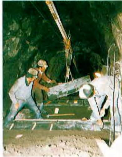
Einbau der Fertigteiltreppenstufen
