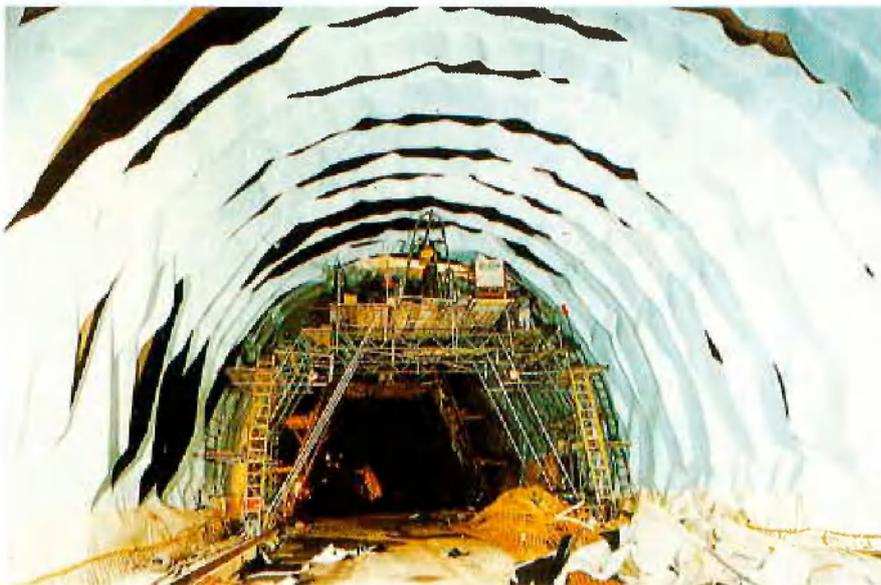
Die Abdichtungsbahnen werden mit Hilfe eines Schweißgerätes durch eine sog. Doppelnah verbunden. Durch die Doppelnah entsteht ein kleiner Prüfkanal von 10 mm Breite. Jede einzelne Doppelnah wird auf Dichtigkeit geprüft.
