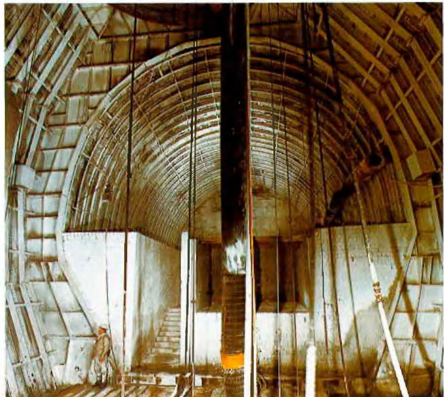
Das Füllort der 8. Sohle wurde nach Beendigung der Teufarbeiten bei – 1078,4 m angesetzt. Als Schachtglocke wurde eine polygonartige Stahlkonstruktion eingebracht. Ihr Gewicht beträgt 80 t, bei einer Höhe von 13,00 m und einer Breite von
