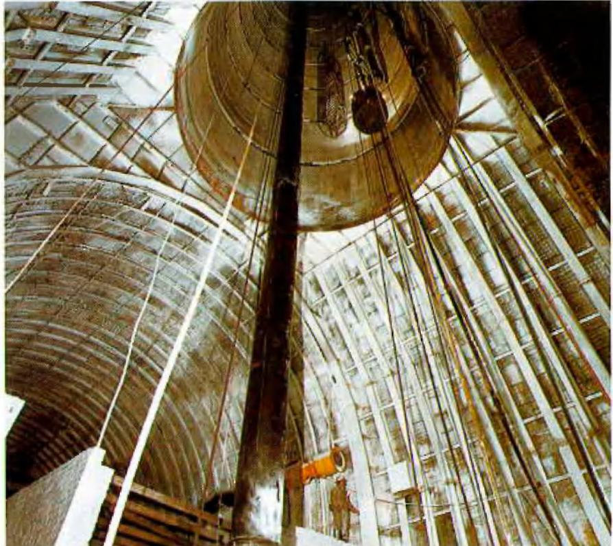
Fertiggestellter Schacht 4 mit nach unten anschließender Polygon-Schachtglocke
