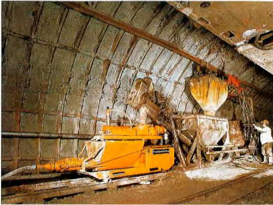
Abb. 7: Die Mörtelpumpe mit vorgeschaltetem Vorratsbehälter
