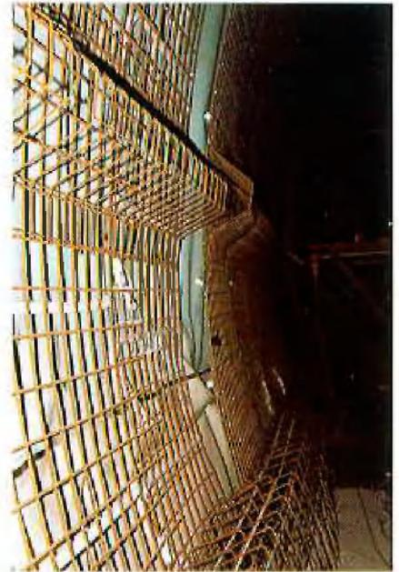
Abb. 7: Bewehrung mit dahinterliegender Abdichtung
