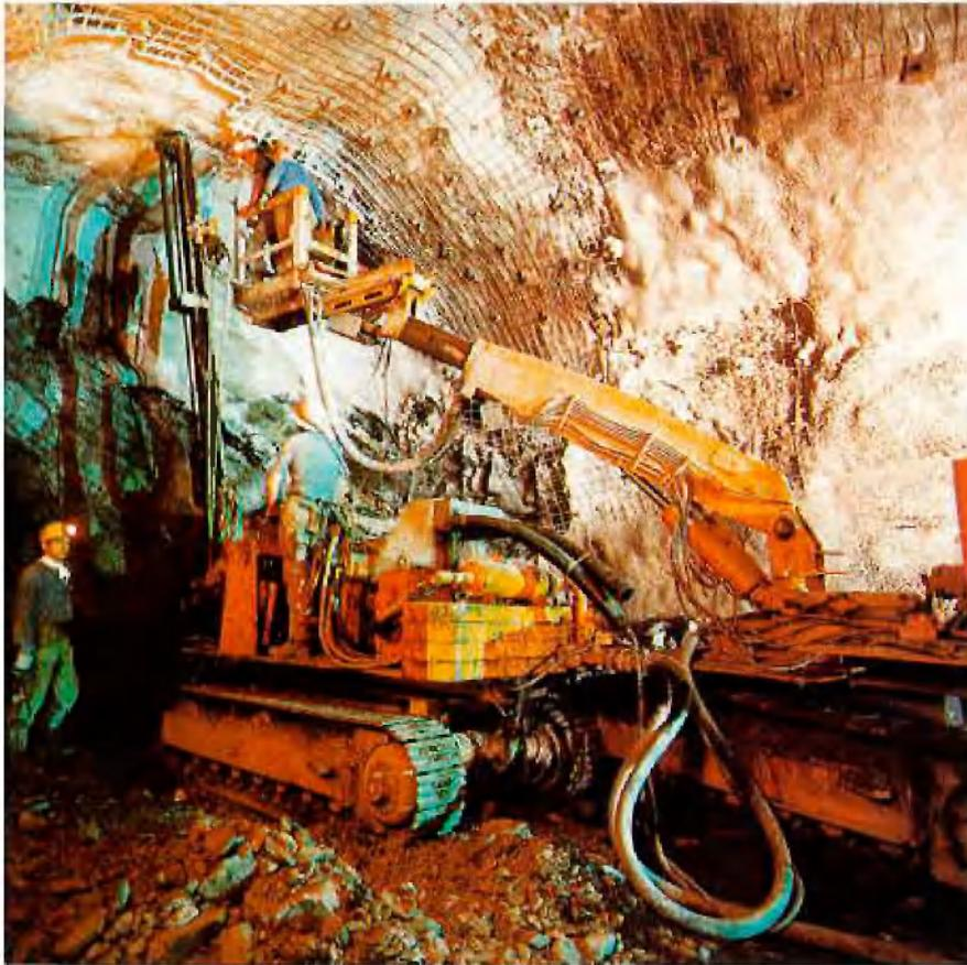
Bohren der Ankerbohrlöcher für die Klebeanker
