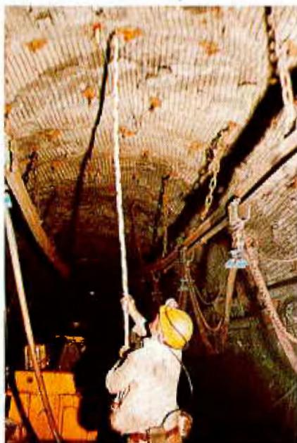
Abb. 8: Überprüfen des Kontrollankers
