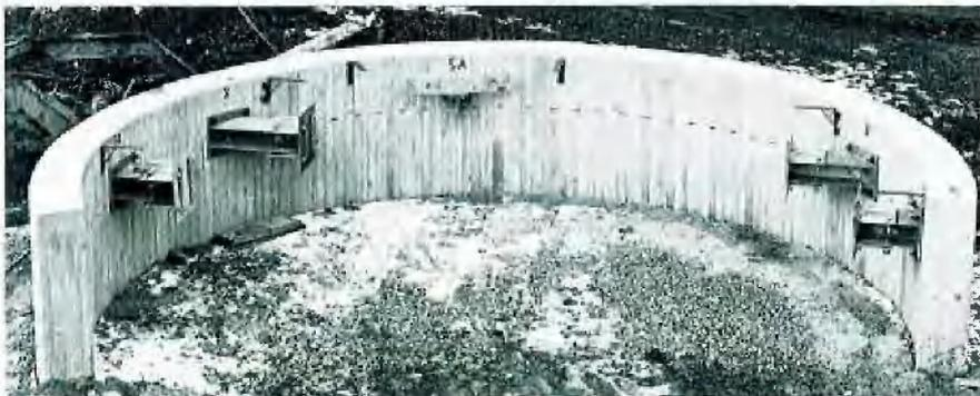
Nach dem Aufbau des Schachtstuhles 5. Sohle folgten die Montagen der Absetzklinkenbühne, der klappbaren Arbeitsbühne für das Durchziehen der Förderseile, der Drallklemmenbühne, der Kopfschutzbühne und des Umlenkrollengeviertes für die Kopfschutzbühne.
