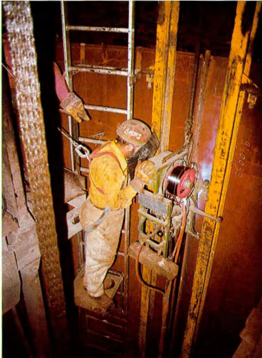
der je vier Stahlbleche pro aufzuzusetzendem Schuß mit 4 m Höhe erfolgen sollte. Unterhalb der Schwebebühne war eine zweietagige Betonierbühne vorgesehen, welche separat um 30 m verfahren werden konnte. Von hier aus sollte die 2 x 4 m hohe Schalung umgesetzt sowie die Bewehrung und der Beton (B 35 / B 45) eingebaut werden. Für die Schwebebühne waren zwei 30 t Bühnenwinden vorgesehen. Als Fördereinrichtung kam eine Bobinenfördermaschine mit 2 x 130 kW Antriebsleistung zum Einsatz.
