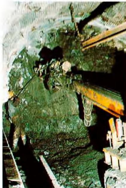
Abb. 5: Bohren der Sprengbohrlöcher
