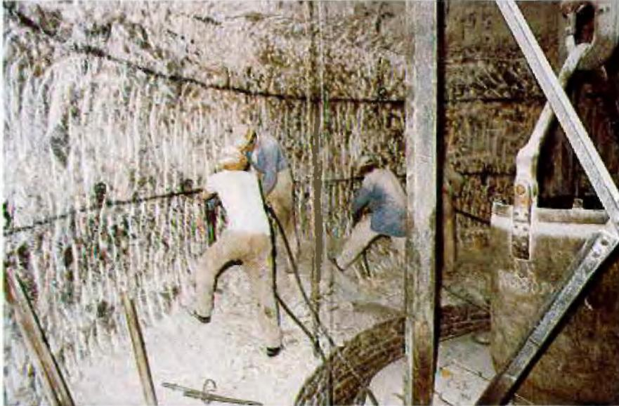
Abb. 2: Fundamentausbruch im Salzgestein in 280 m Tiefe
