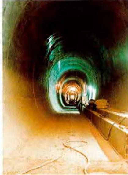
Abb. 10: Fertiggestellte eingleisige elliptische Tunnelröhre
