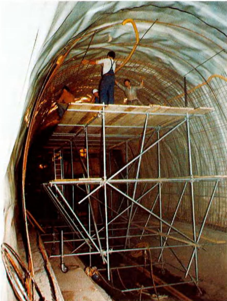
hohe Anforderungen an die Spritzbetonoberfläche gestellt. Die Unebenheiten dürfen den Wert 1 : 10 nicht unterschreiten, d. h., die Leibungen müssen großflächig mit flachen Übergängen hergestellt werden. Um bei einem reinen Sprengvortrieb die geforderte Spritzbetonoberfläche wirtschaftlich herstellen zu können, erfordert dies besondere Sorgfalt, sowohl bei der Bohr- als auch bei der Sprengtechnik.
