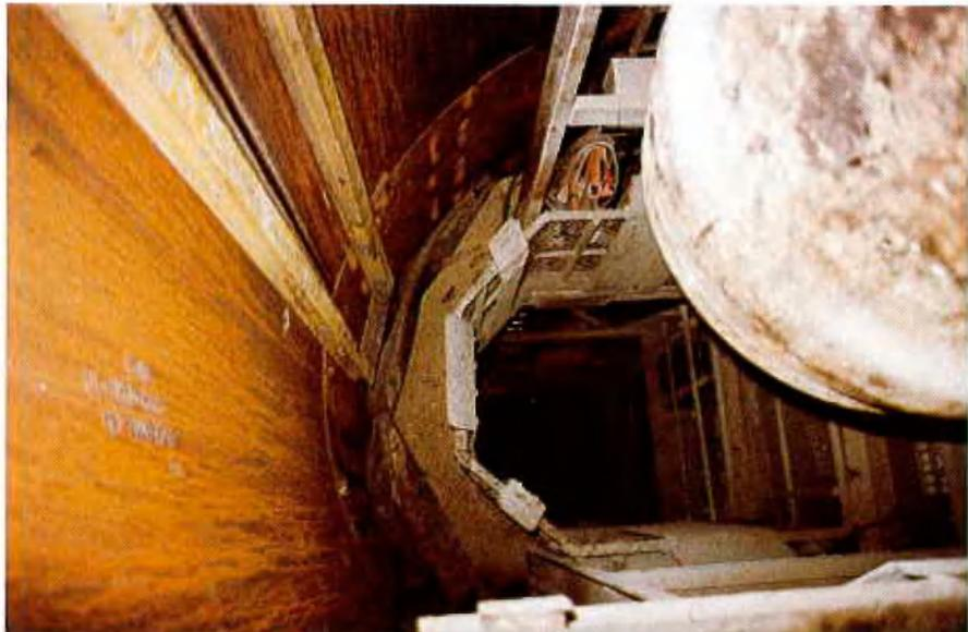
Abb. 4: Schwebende Arbeitsbühne und fertig eingebauter Stahlblechzylinder
