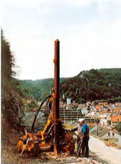
Abb. 1: Raupenbohrgerät Atlas Copco Roc 601 beim Bohren der Injektionslöcher
