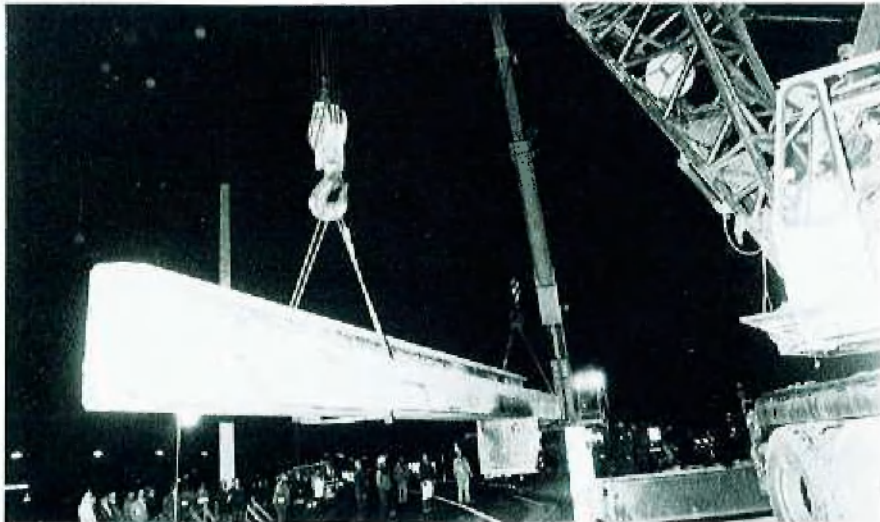
Stadtbahn Hacheneay, Verladung des 1. Brückenteils mit zwei 140-t-Kränen
