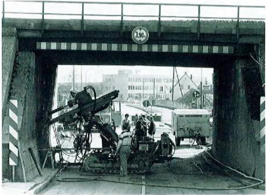
Abb. 2: Ankerbohrgerät
