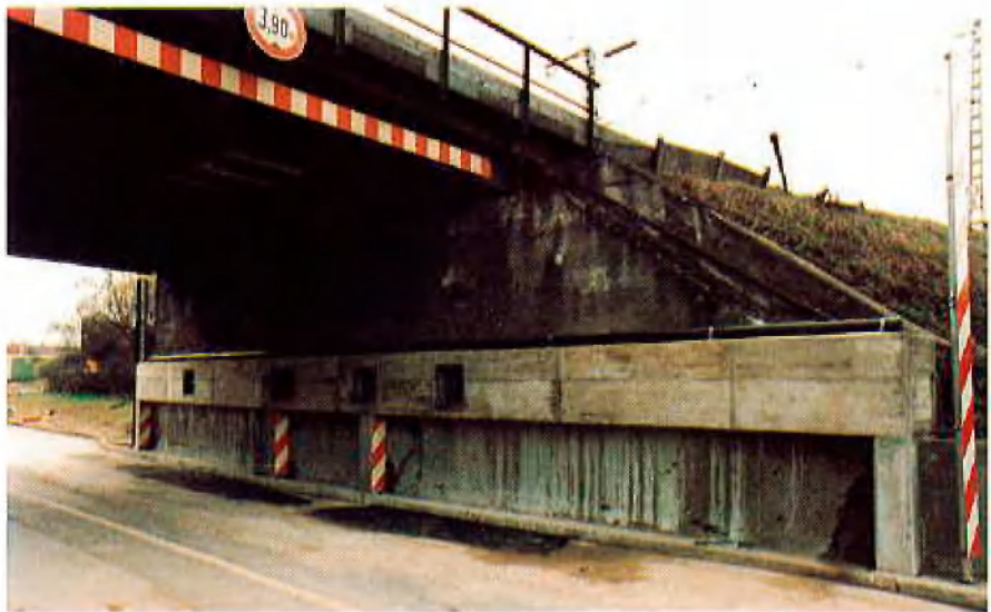
Abb. 5: Stahlbetonbalken mit Ankerkopfaussparungen
