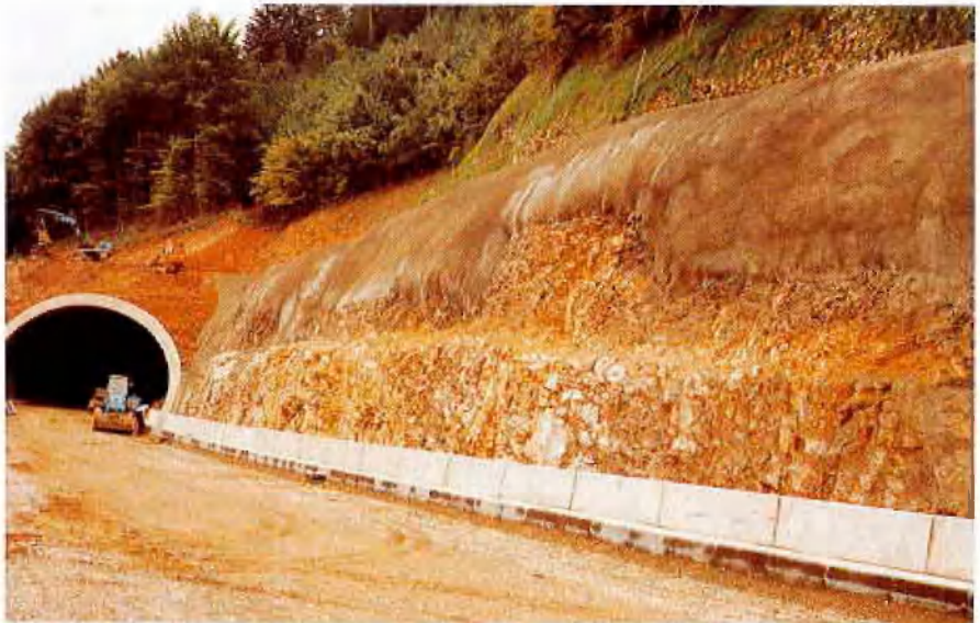
Abb. 2: Fertiger Spritzbeton am Bauabschnitt I
