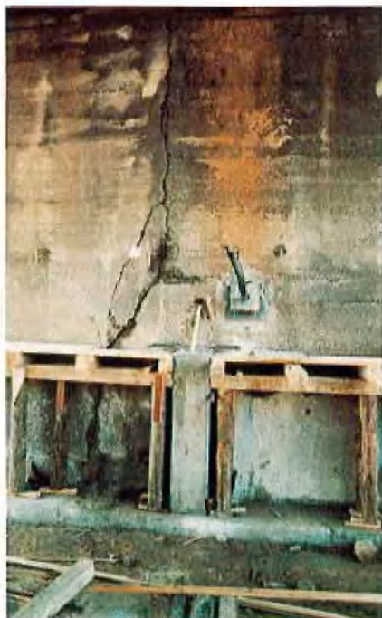
Abb. 1: Zerstörtes Brückenwiderlager mit Vertikalrisse und Litzenerankern
