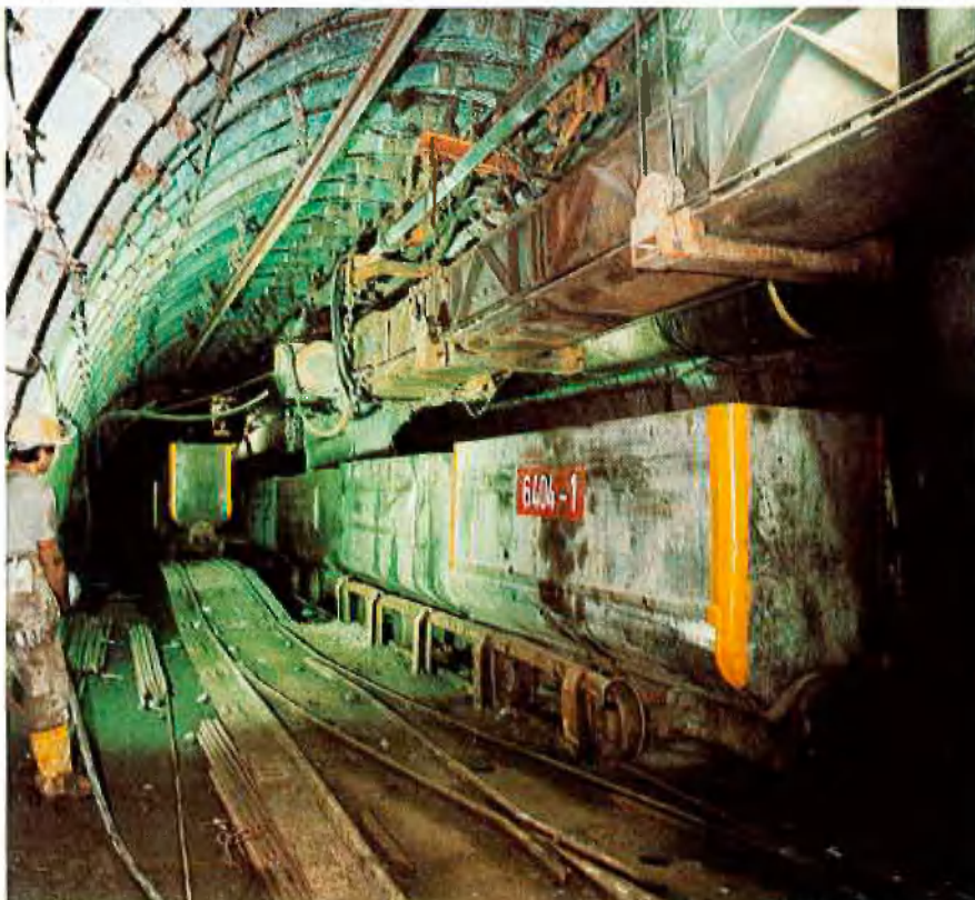
Abb. 2: Umgleisplatte mit Ablaufberg, Vorzieher und Förderaufhängung
