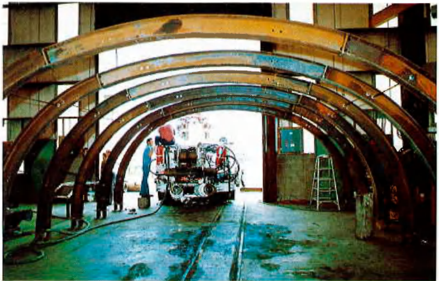
Probelauf der Teilschnittmaschine
