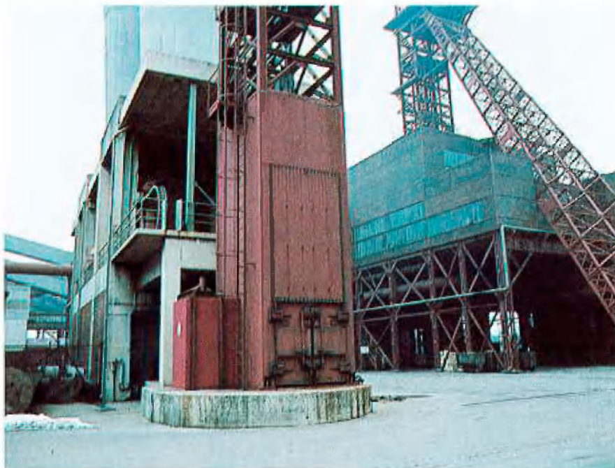
Abb. 1: Das alte eingeschleuste Gerüst
