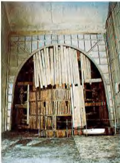
Abb. 3: Schachtdurchdringung mit DH-Ausbausystem
