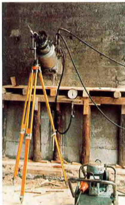
Abb. 3, 4: Eignungsprüfung und Vorspannen der Daueranker
