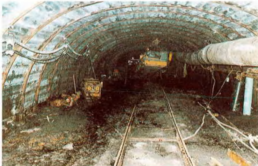
Blick in die ausgebaute Strecke
