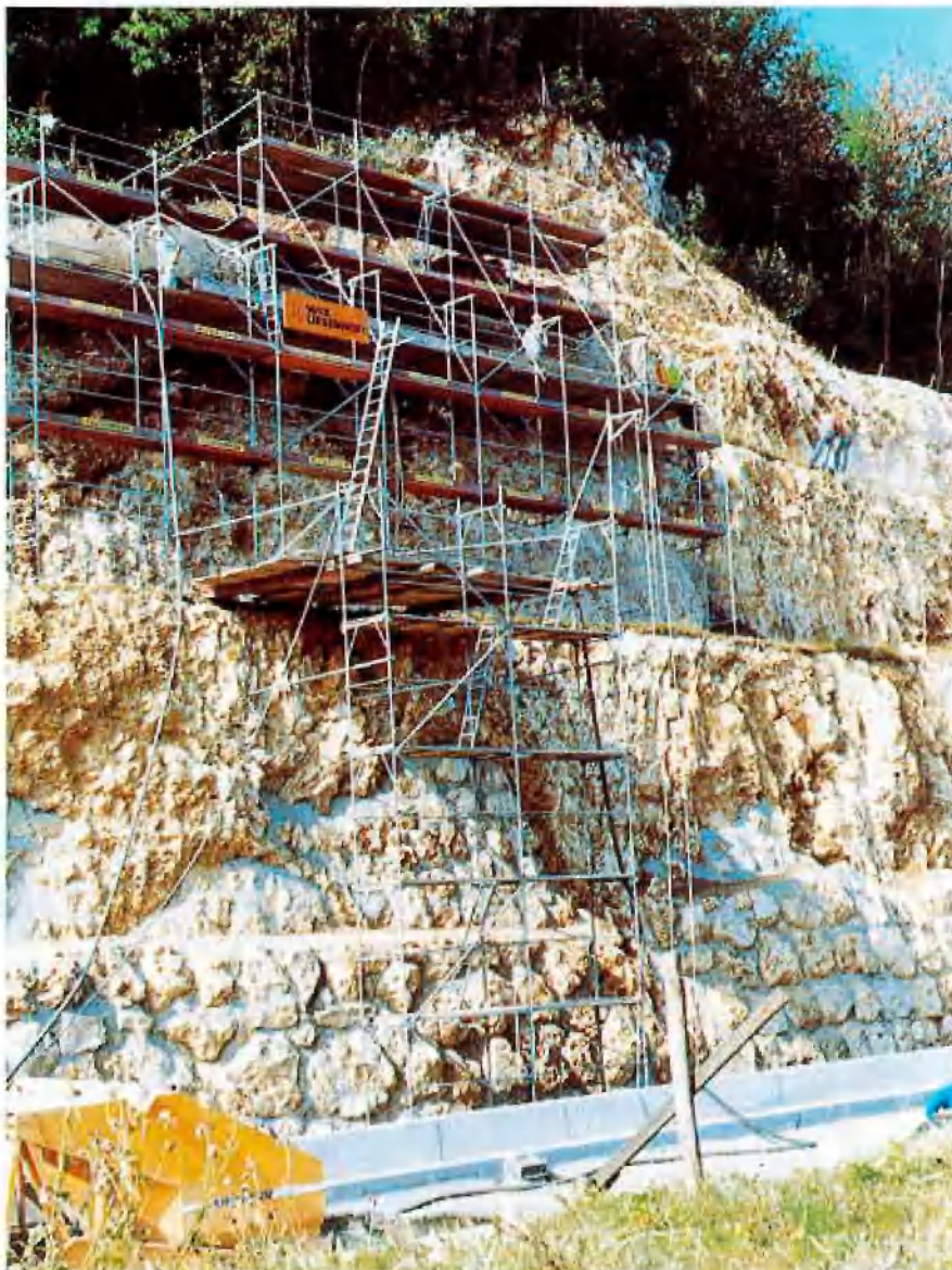
Abb. 8: Anker für das Steinschlagschutznetz
