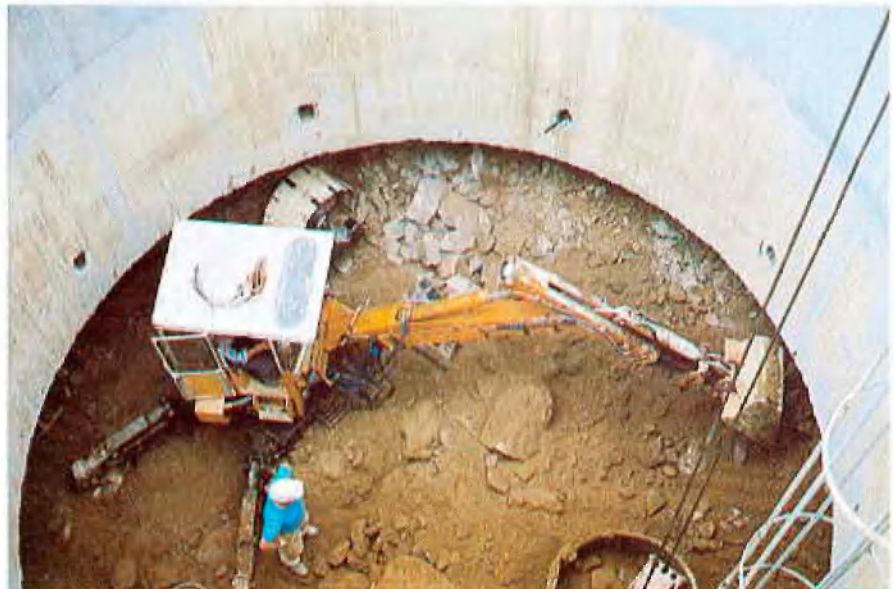
Abb. 7: Menzi Muck im Vorschacht
