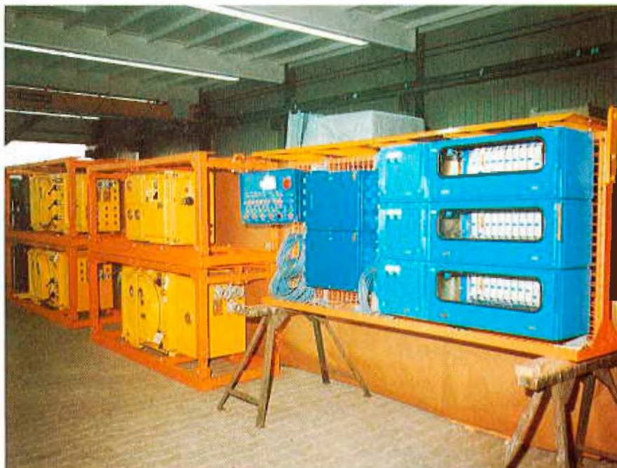
Gesamtanlage der elektrischen Ausrüstung
