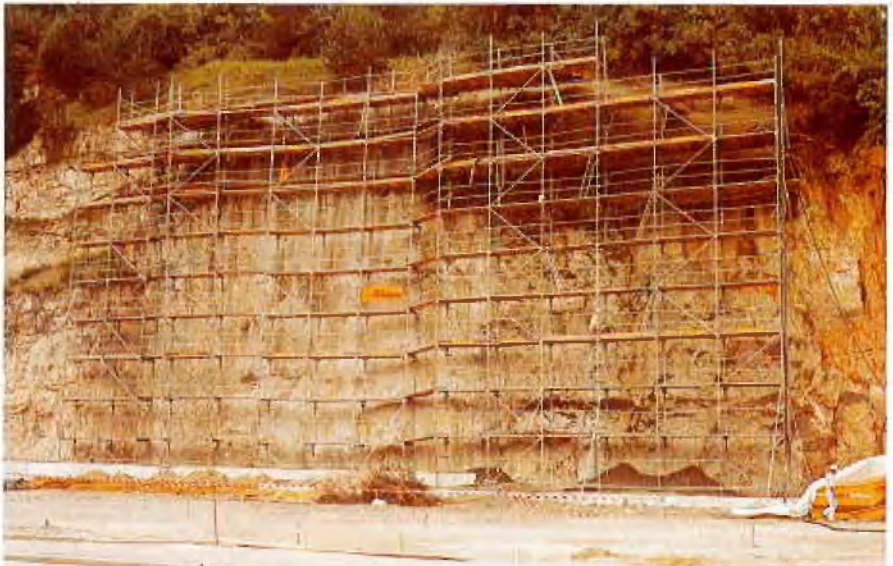
Abb. 7: Stahlrohrgerüst am Bauabschnitt III
