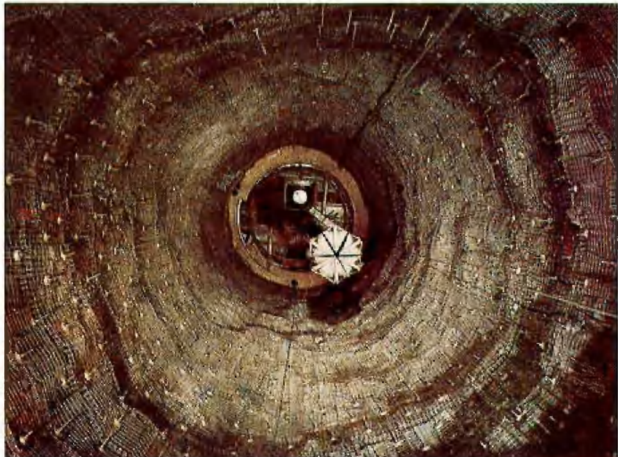
Abb. 8: Tragender vorläufiger Ausbau mit Ankern und Matten
