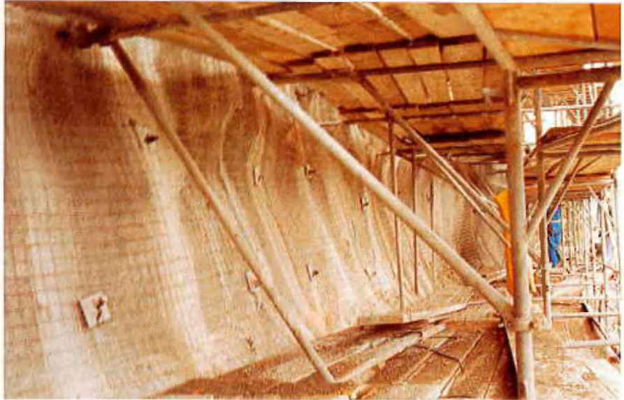
Abb. 3: Vorgespannte SN-Anker zur Vernagelung
