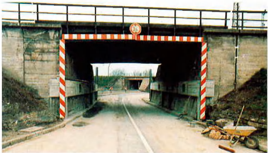
Abb. 6: EBR nach Durchführung der Arbeiten
