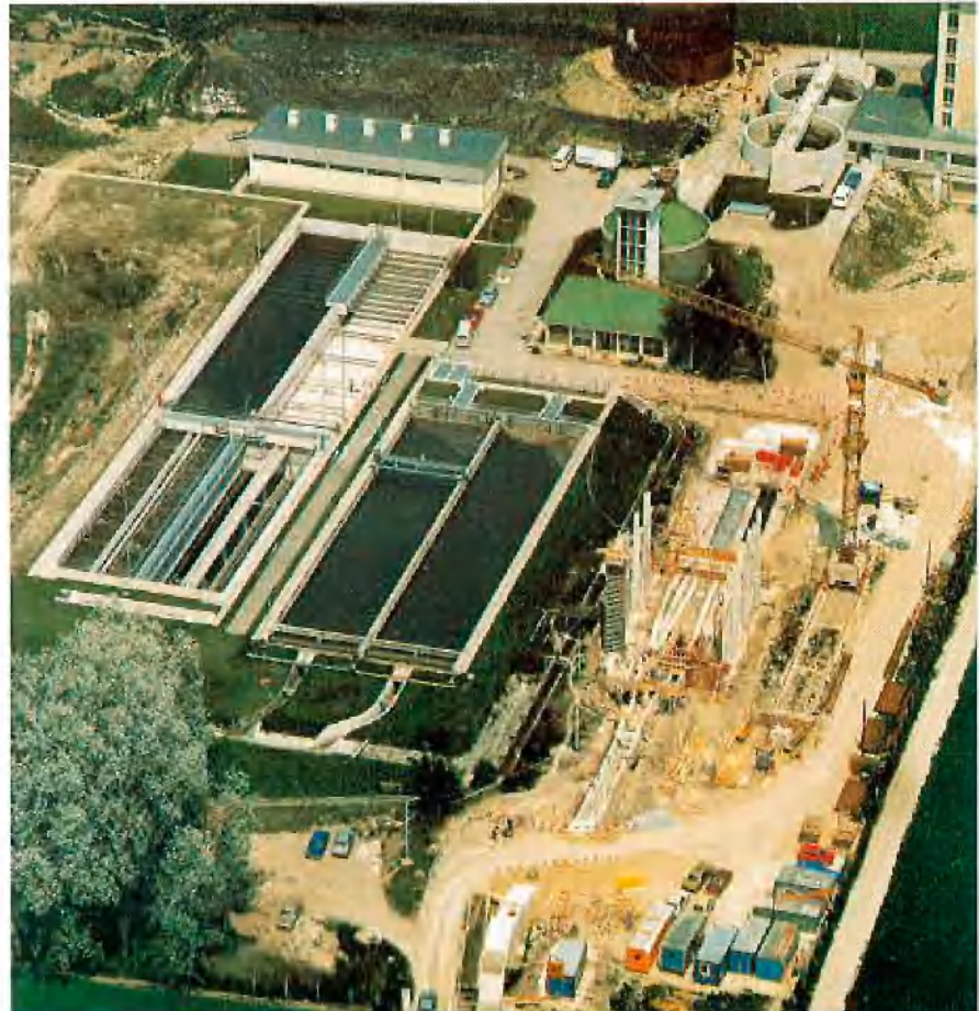
Kläranlage Wiener Neustadt
