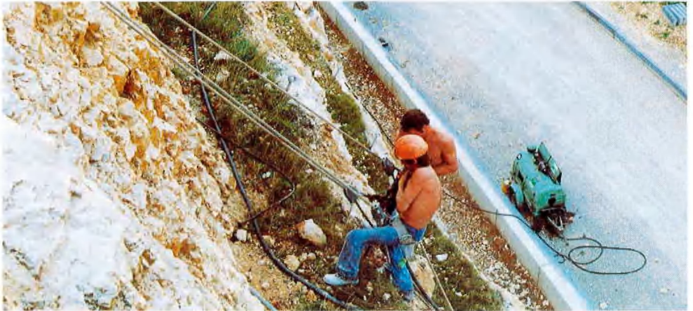
Abb. 5: Bohren der Anker für das Steinschlagschutznetz vom Seil aus
