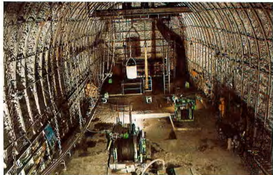
Abb. 5: Bunkerkopfstrecke mit Teufeinrichtung
