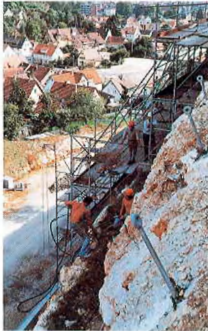
Abb. 6: Schutznetzarbeiten am Bauabschnitt II
