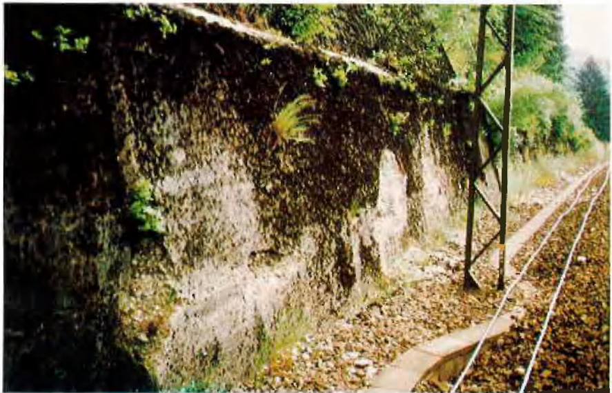
Abb. 4: Frostschäden an einer Betonfuttermauer
