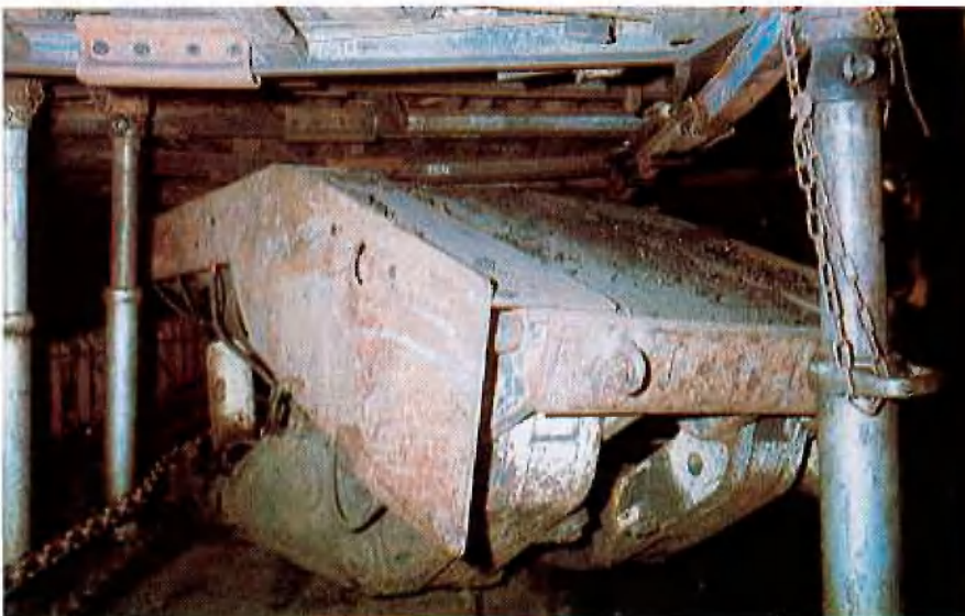
Abb. 12: Einschwenken des Schildes in den Einbauort. Sicherung des Schwenkraumes durch Unterzüge.
