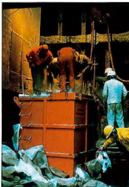
Anmischen der Dowell-Chemical-Sealmasse
