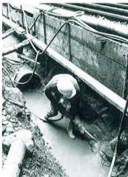
Abb. 4: Einbau des neuen Mittelkanals aus Steinzeugrohren
