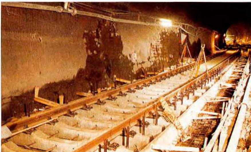
Abb. 6: Vermessungsarbeiten zur Höhen- und Lagebestimmung eines Betonierabschnittes
