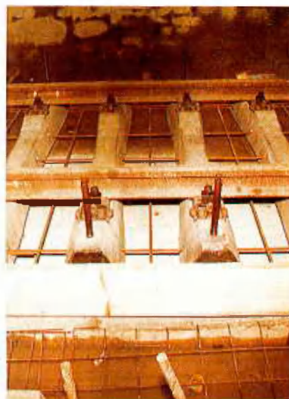
Abb. 5: Aufgespindelter Gleisrost mit Längs- und Querbewehrung
