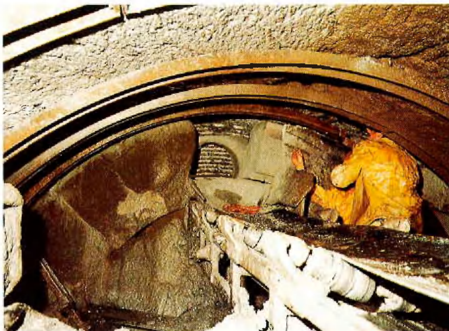
Triebwasserstollen Obere Sill: Gebirgssicherung mit Stahlbögen im Bereich des Bohrkopfes
