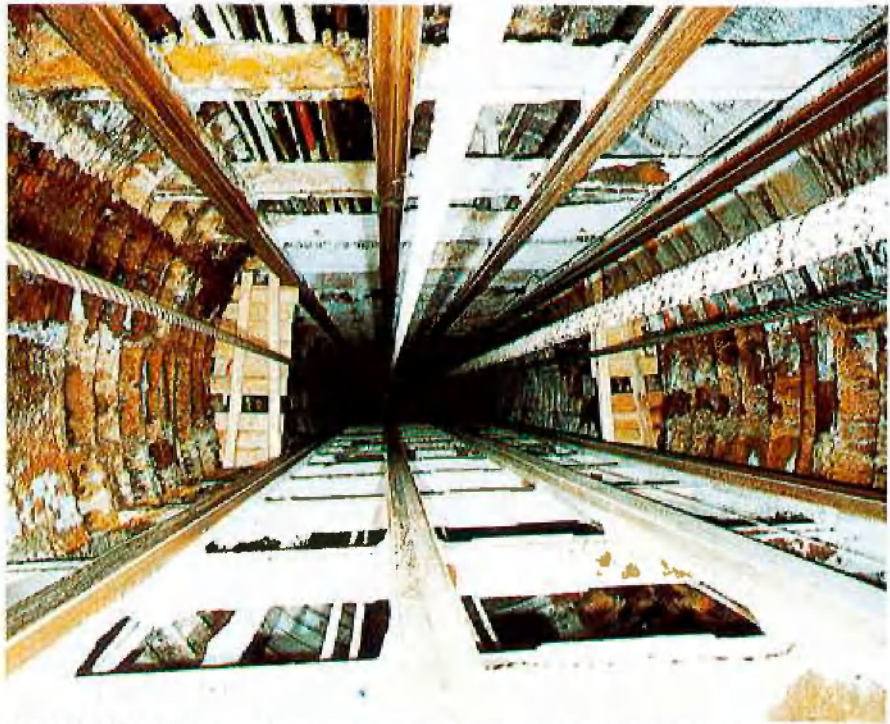
Feuchtigkeitszuflüsse und Salzverkrustungen im unteren Tübbingbereich des „Obereisens“ (ca. 100 m Teufe)
