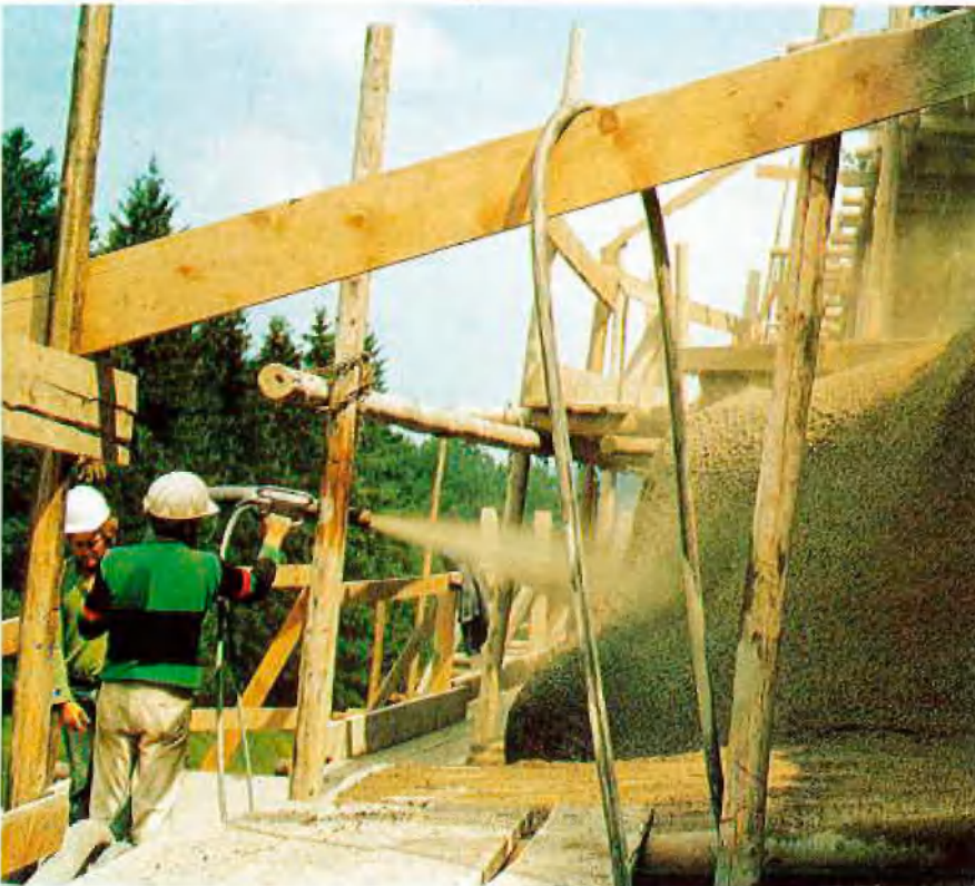
Abb. 7: Aufbringen der letzten Spritzbetonlage
