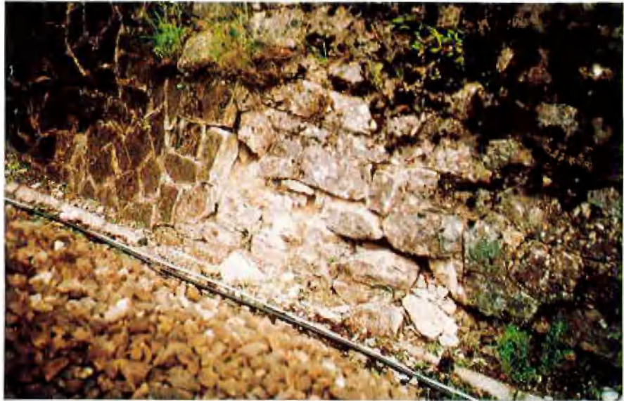
Abb. 3: Einsturzgefährdetes Mauerwerk z. T. aus Hartgestein links im Bild und z. T. aus weichem Kalkgestein rechts im Bild
