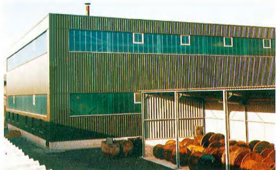
Neue Werkstatt- und Lagerhalle in Kurl
