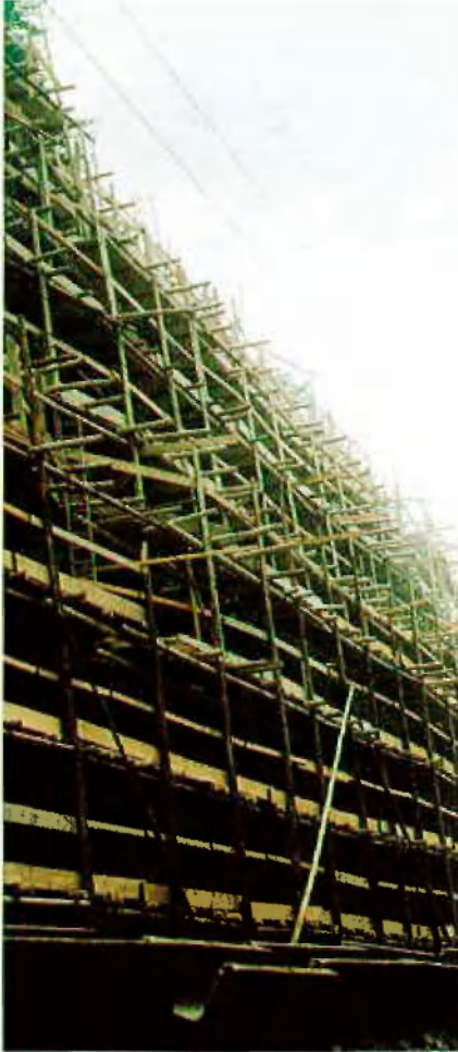
Abb. 6: Teilansicht eines Arbeits- und Schutzgerüstes
