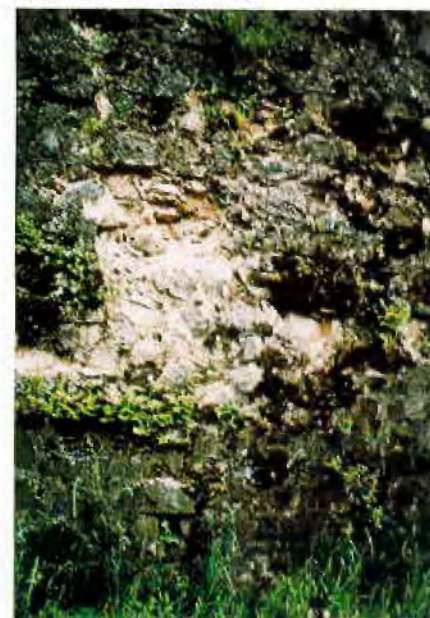
Abb. 2: Verwitterungserscheinungen beim Kalksteinmauerwerk
