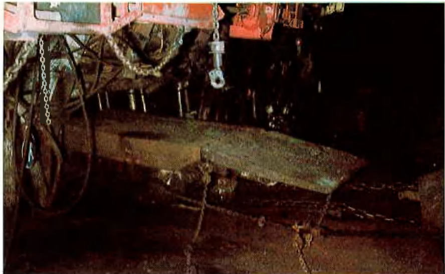
Abb. 8: Abziehen des Schildes vom Transportschlitten. Schwenken und Vorziehen zur Reparaturbühne.
