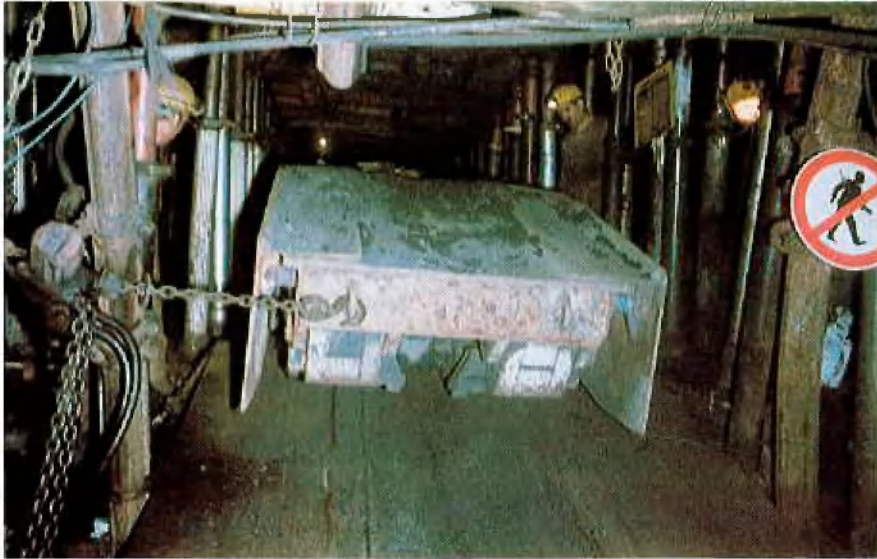
Abb. 10: Einschwenken und Aufziehen des Schildes auf den Transportschlitten im Herrichtungsstreb.
