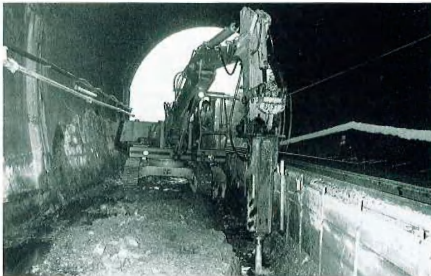
Abb. 3: Rückverhängter Gleisverbau und Ausbruchsarbeiten für Mittelkanal mit Hydraulikfelsmeißel
