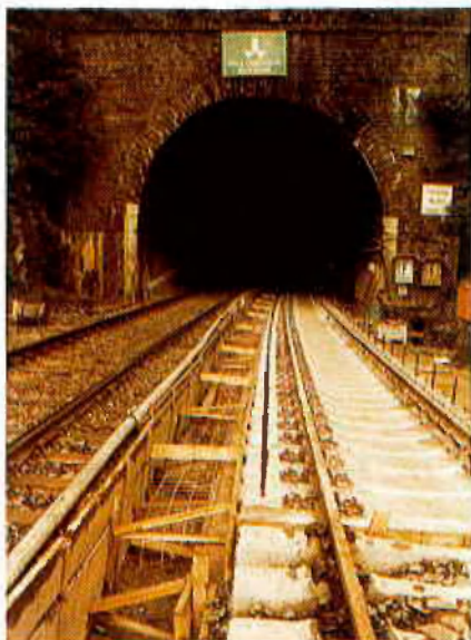
Abb. 7: Fertiggestellter 1. Bauabschnitt am Westportal des Tunnels Herchen
