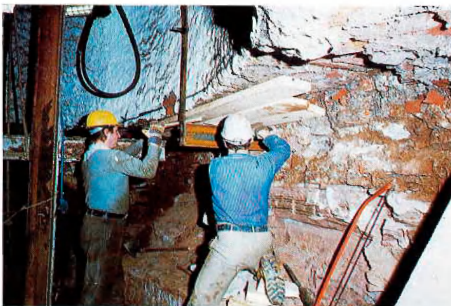
Abfangung des Mauerwerks
