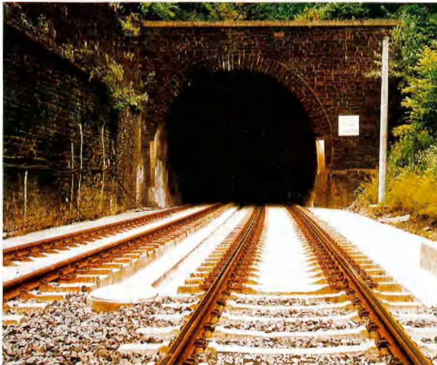
Abb. 11: Tunnelportal Herchen-Ost mit Übergang „Rheda“-Oberbau zu Schotteroberbau
