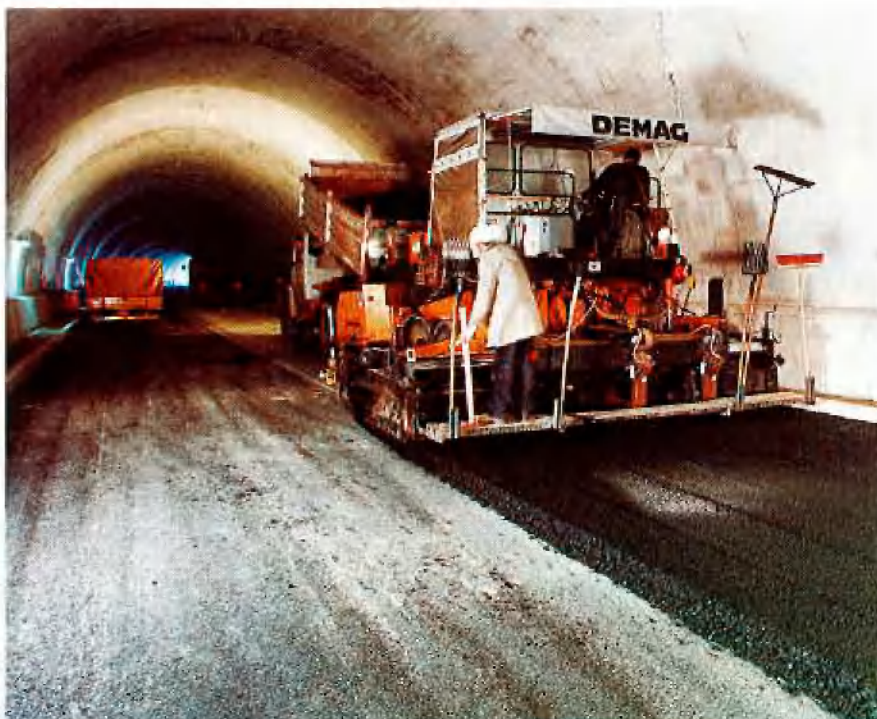
Straßendeckenfertiger im Tunnel Westtangente
