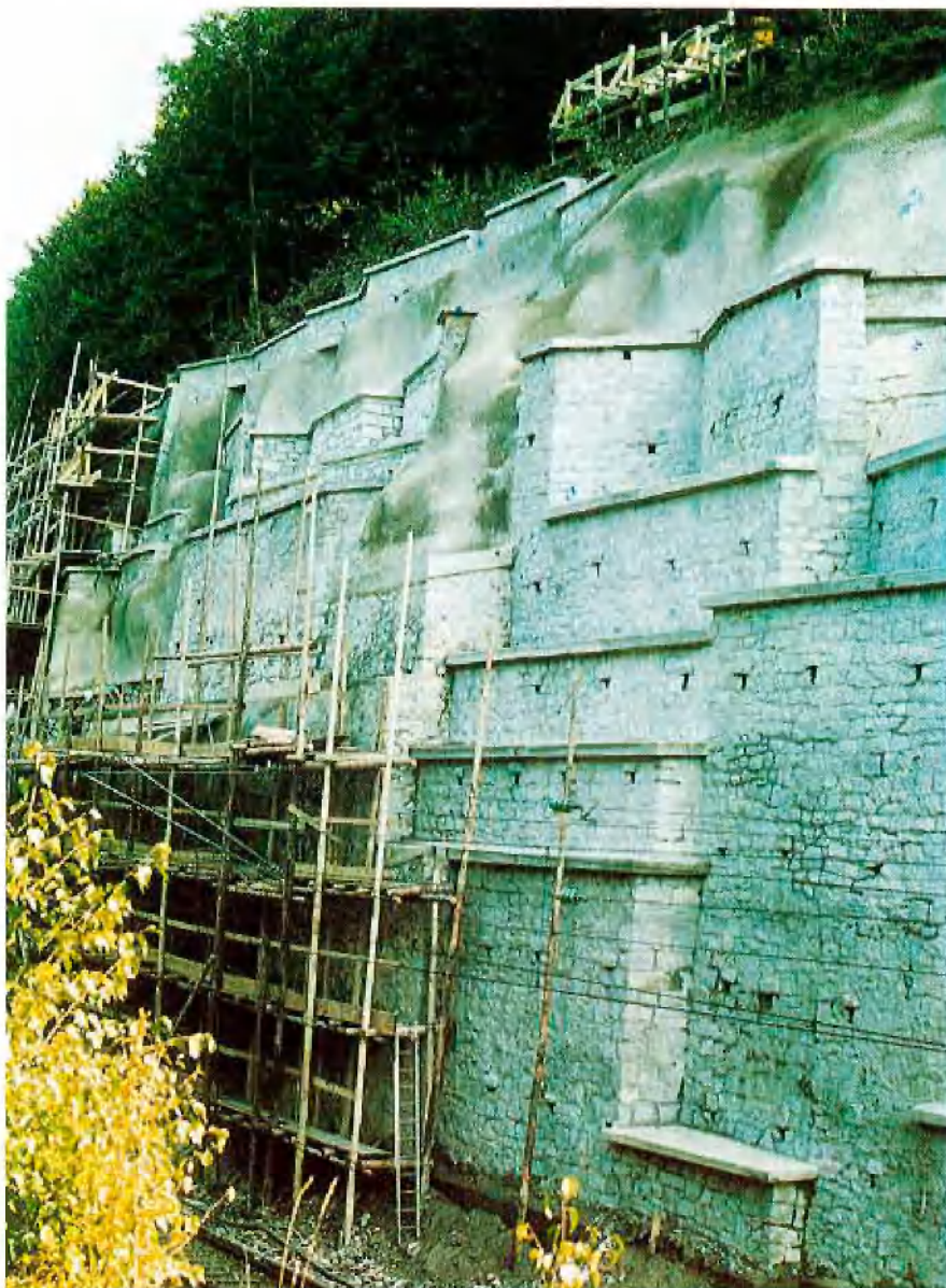
Abb. 8: Teilweise fertiggestellte Felswandverkleidung bei km 30.7 rechts der Bahn
