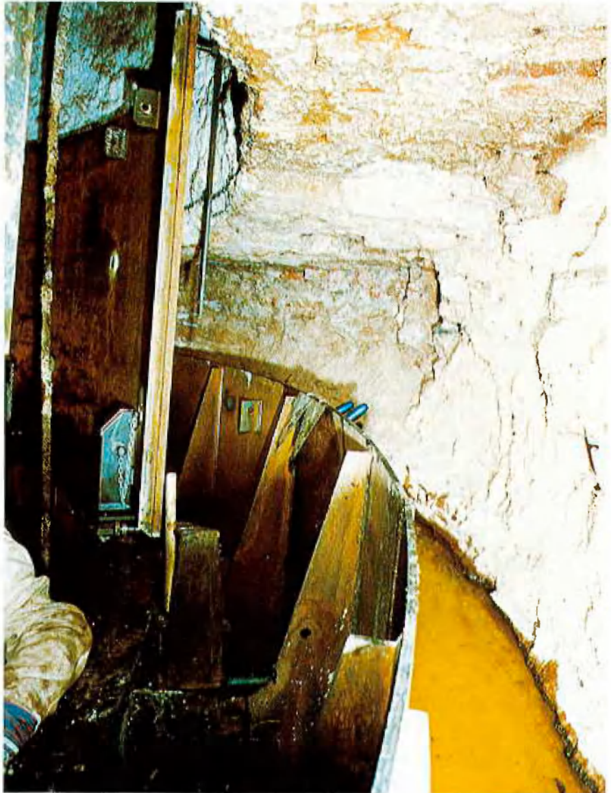
Fußschuß mit hinterfülltem Dowell-Chemical-Seal-Dichtring
