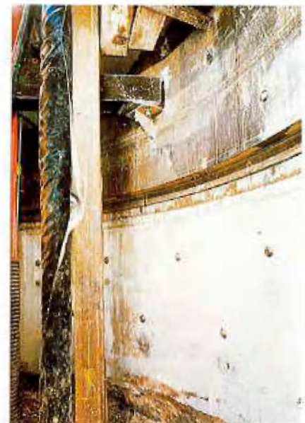
Fundament, Fußschuß und Schuß 1 fertig eingebaut mit Verpreßrohren
