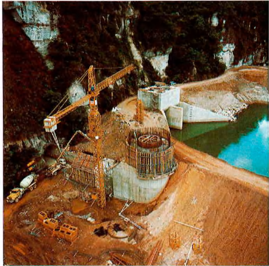
Abb. 4: Einlaufbauwerk, im Vordergrund Grundablaßstollen und Einlaufsturm
