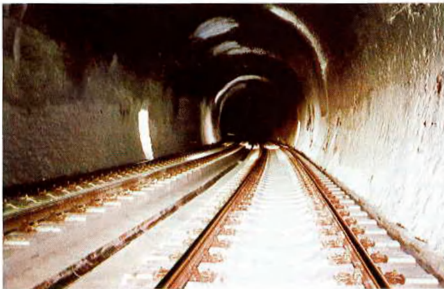
Abb. 8: Tunnel Herchen nach Beendigung der Bauarbeiten
