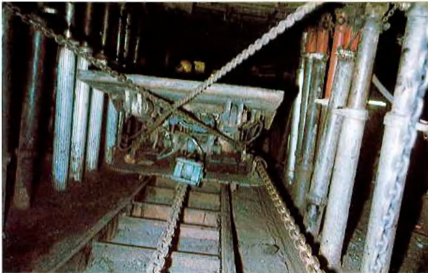
Abb. 11: Aufziehen des Schildes auf den Transportschlitten.
