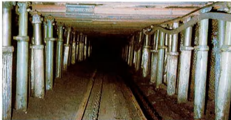
Abb. 2: Ausfahrgasse Raubstreb. Transporttrumm mit Rinnenstrang zur Führung des Transportschlittens, vom Fahrtrumm getrennt.
