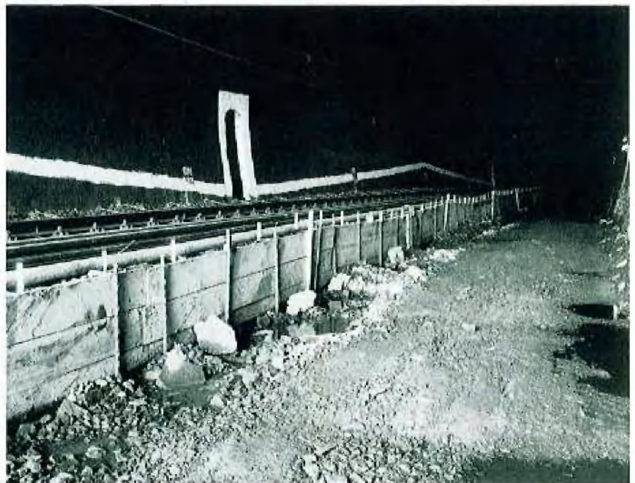
Abb. 2: Ausbruch der Tunnelsohle im 1. Bauabschnitt mit rückverhängtem Gleisverbau
