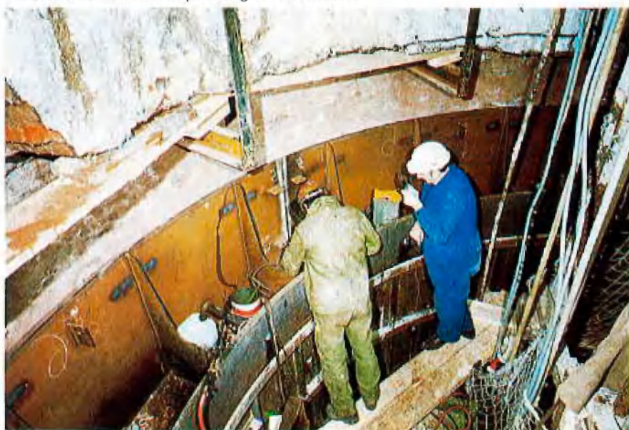
Verschweißen des kastenprofilartigen Fußschusses
