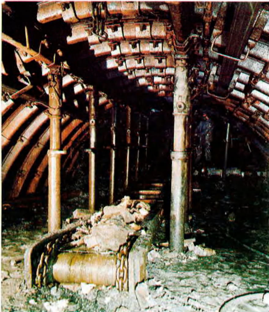
Sophia-Jacoba – Auffahren der oberen Scheibe der Richtstrecke
