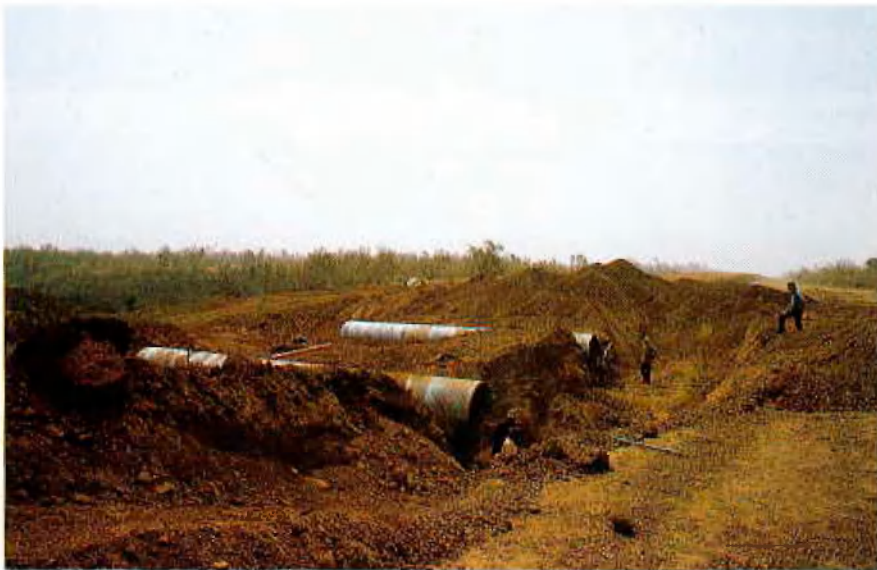
Bau einfacher Wasserdurchflüsse
