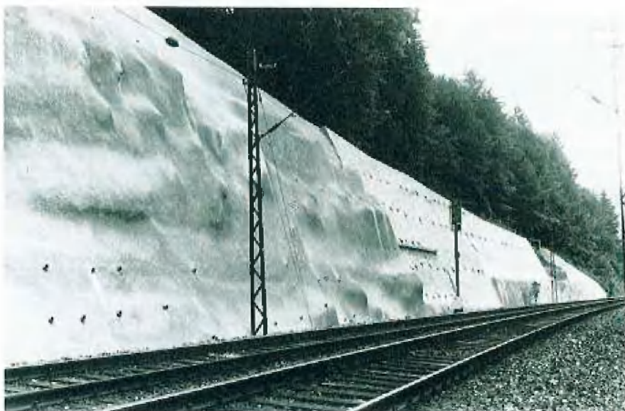
Abb. 9: Fertiggestellter Sanierungsabschnitt bei km 31.3 rechts der Bahn
