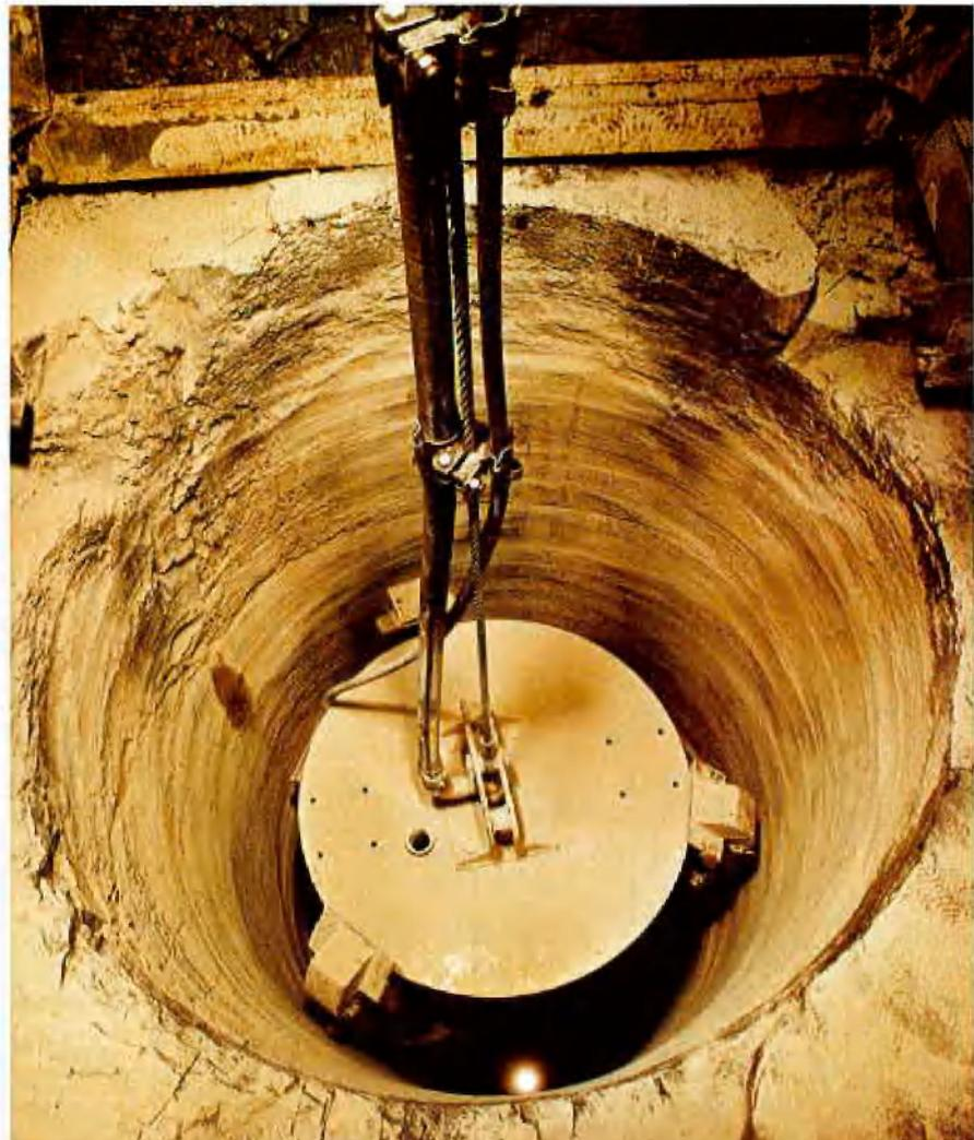
Abb. 1: Auskleidungsvorrichtung mit Winde, Tragkonstruktion und Bohrlochabdeckung in der Bohrlochnische.
