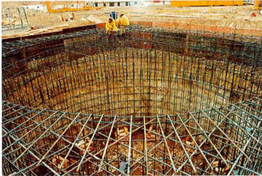
Abb. 6: Vorschacht des einziehenden Wetterschachtes
