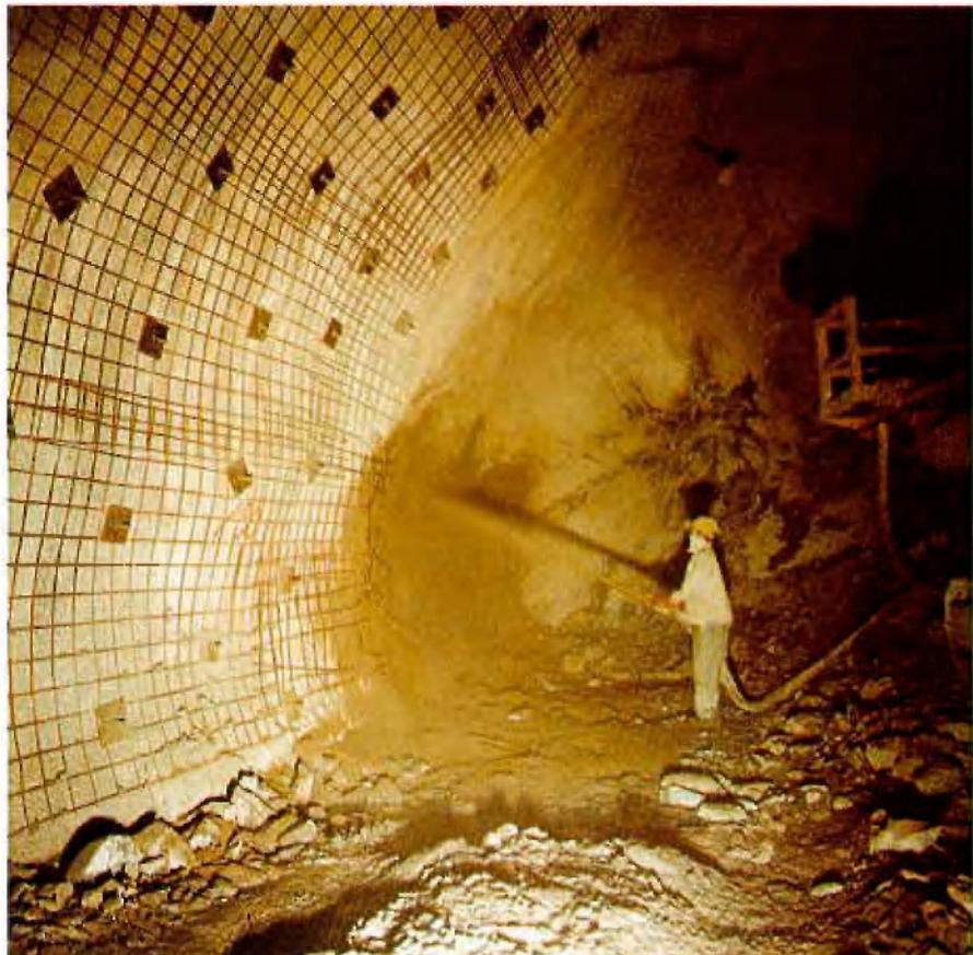
Querschnitt von 143 m<sup>2</sup> beidseitig auf rd. 57 m<sup>2</sup>, der dann über den gesamten Bahnhofsbereich beibehalten wird. Es schließen sich Grubenausbau mit unterschiedlichen Querschnitten, auch mit Unterstützungsausbau, an.
