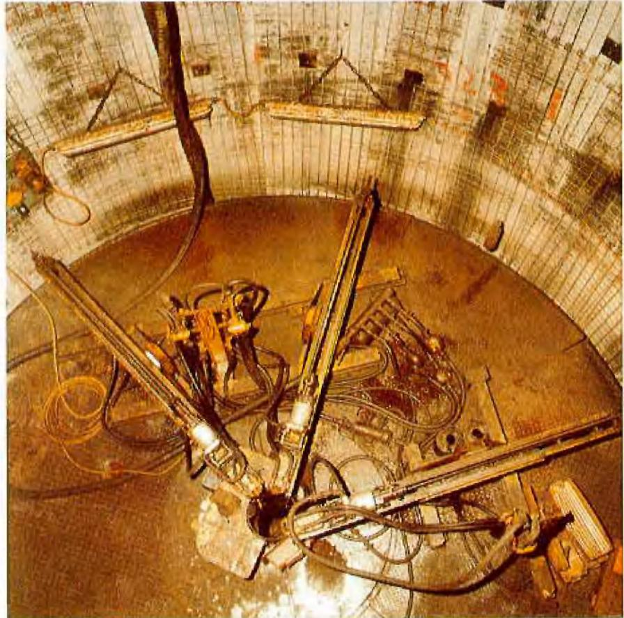
Bohrschacht mit Ankerabau
