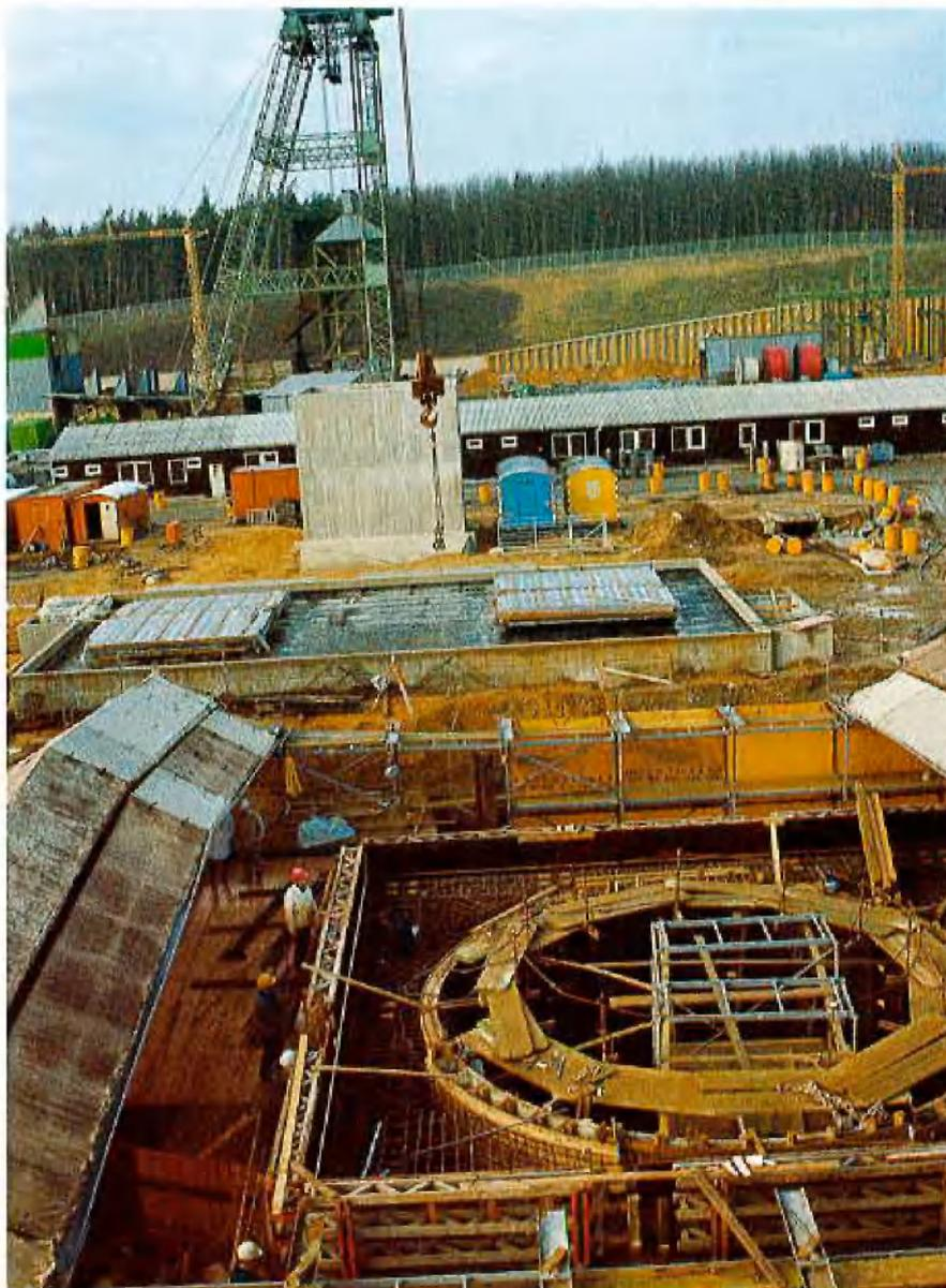
Schacht Haltern 2: Bau des Schachtkopfes im Schutz einer Winterbauhalle
