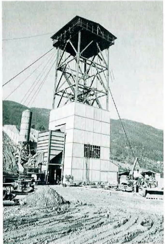
Abteufeinrichtung des Schachtes Gesuiti
