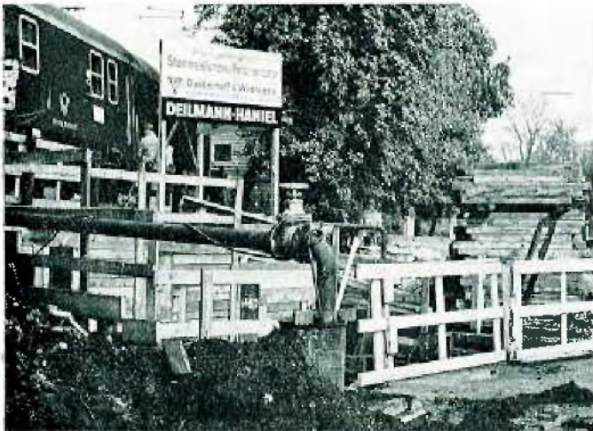
Abb. 2: Blick auf den Hilfsschacht B am Fuße des Bahndammes
