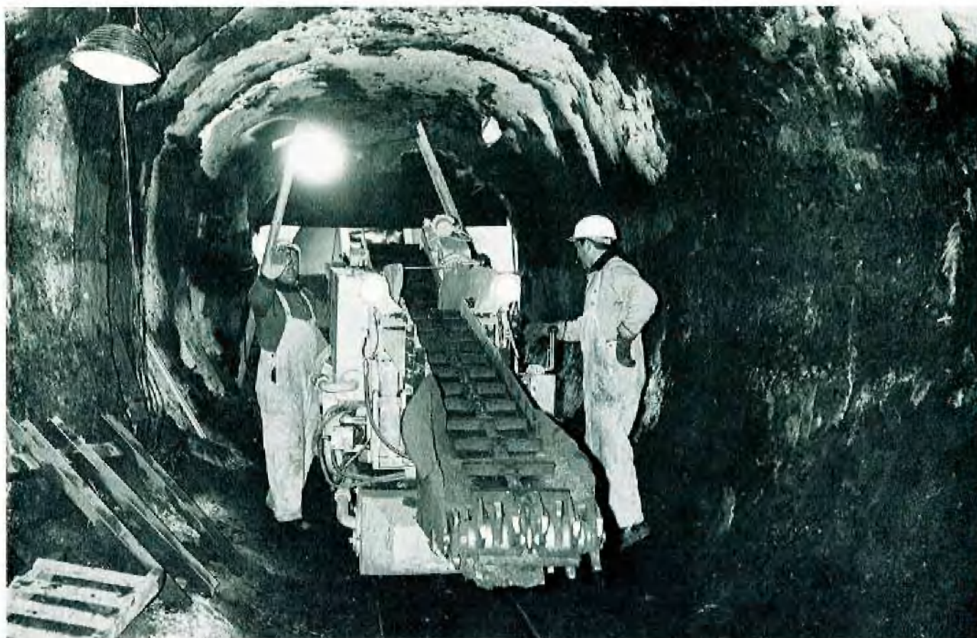
Abb. 4: Blick in den gefrorenen Stollen mit Fräslader »Westfalia-Fuchs«
