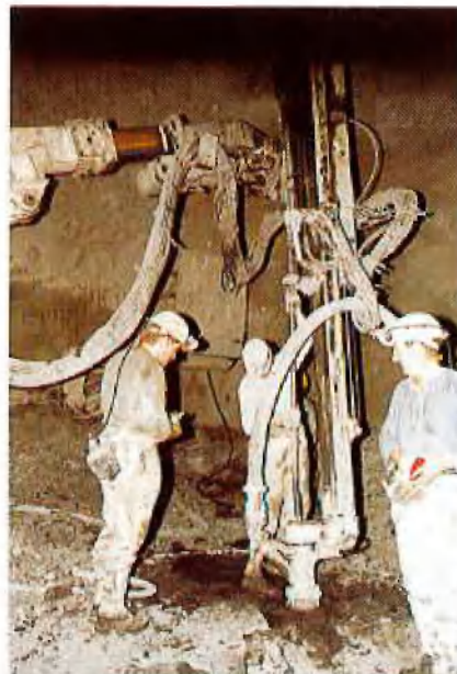
Abb. 11: Ankerlochbohren in der Sohle
