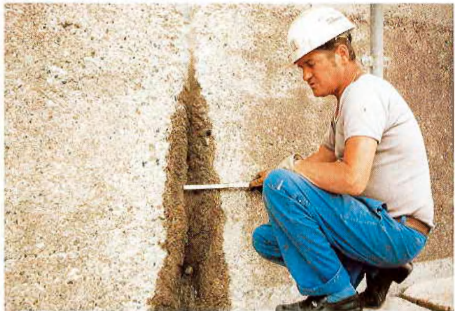
Abb. 3: Aufstemmen der Dehnungsfugen
