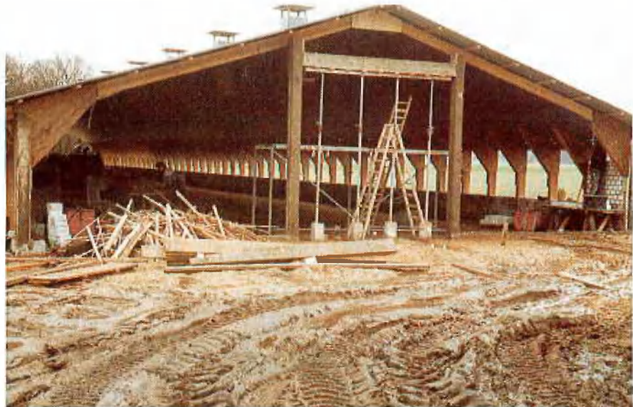
Hallenneubau Nordhorn – Brandlecht
