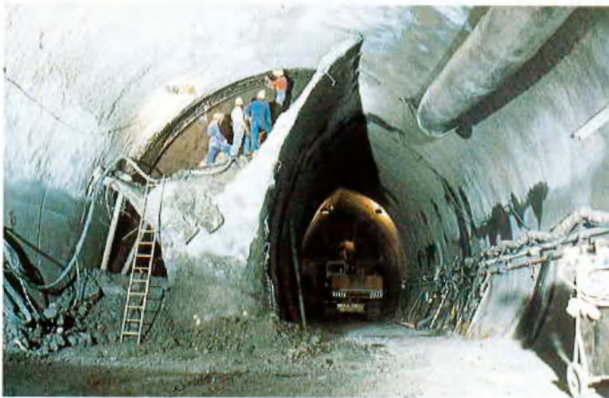
Abb. 2: Ausbruch der zweigleisigen Wenderöhre
