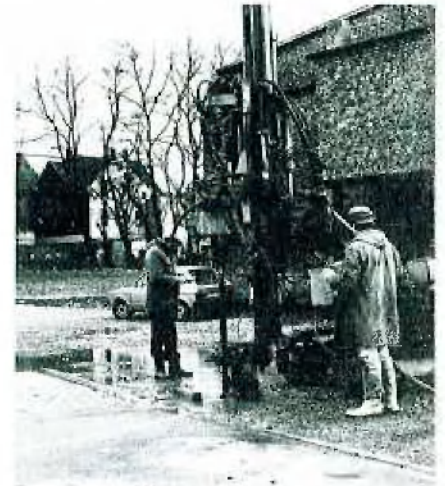
Bohrarbeiten mit Raupenbohrgerät in Witten-Annen
