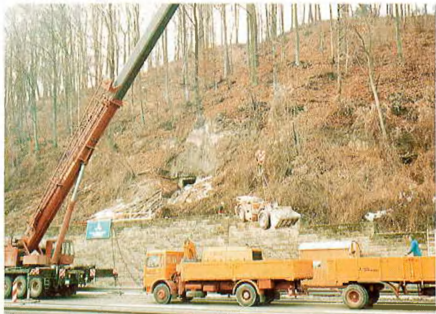
Luftschutzstollen Eisberg, Antransport des Fahrladers
