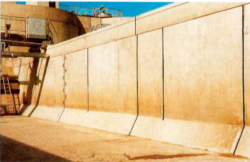
Abb. 8: Fertiggestelltes Klärbecken nach der Sanierung
