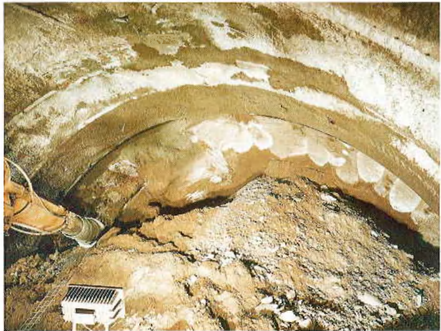
Abb. 6: Abfräsen der Jet-Pfähle mit einer TSM
