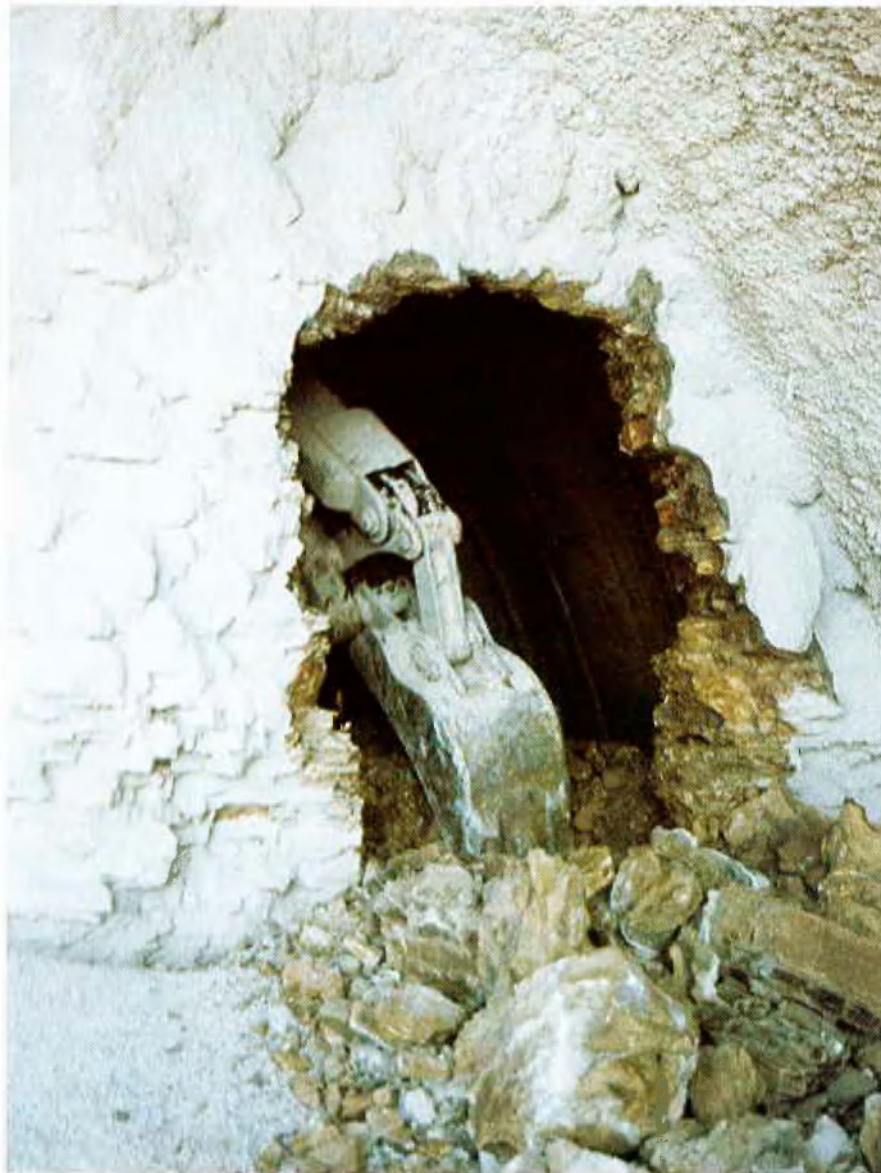
Durchschlag des Roßberg-Tunnels
