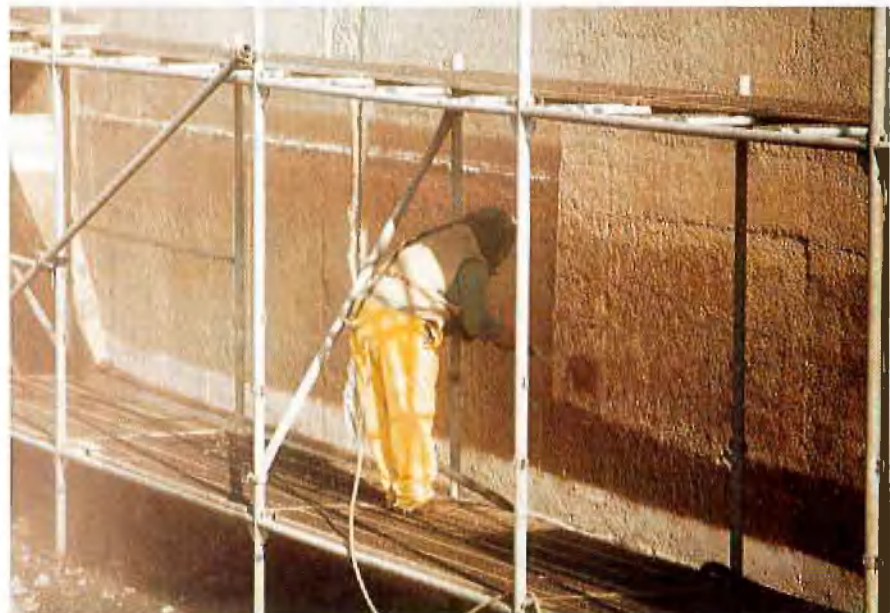
Abb. 4: Sandstrahlen der Oberfläche
