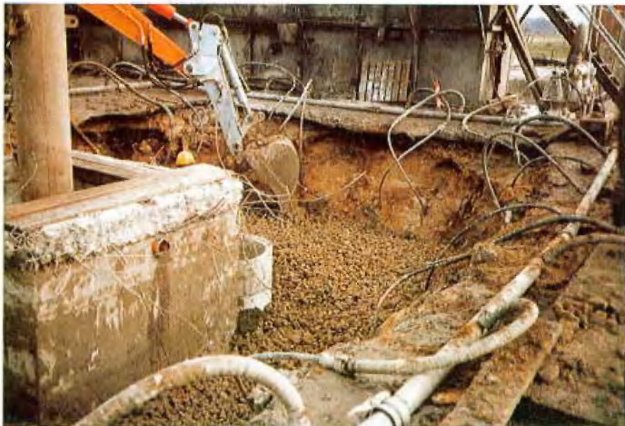
Gasausbruch an der Bohrung Georgsdorf 503
