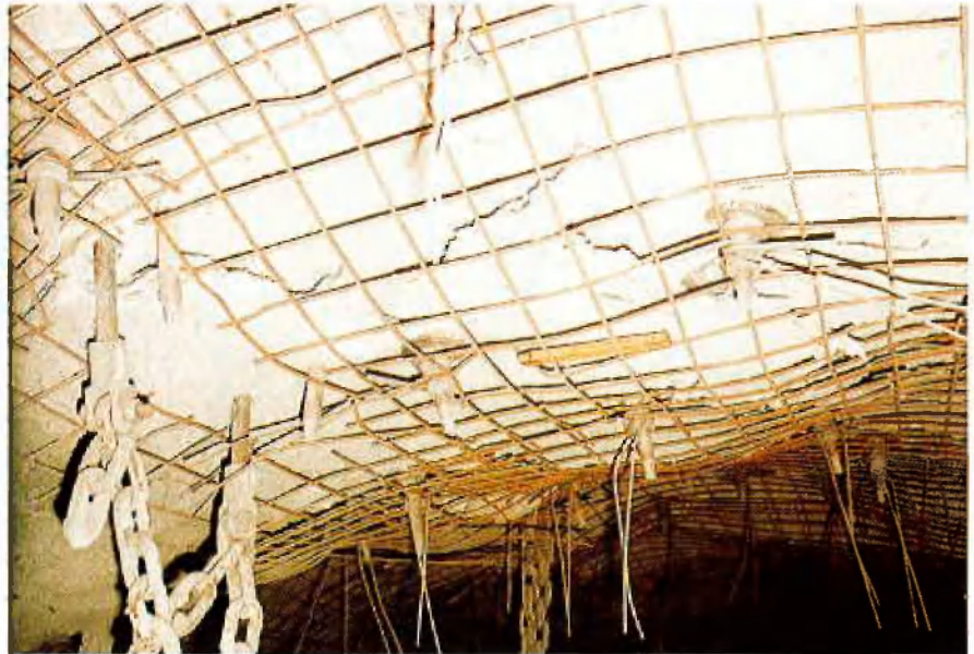
Abb. 12: Risse im Spritzbeton
