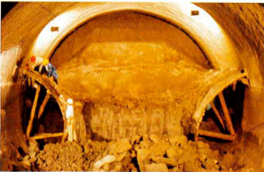
Abb. 3: Vollausbruch, mit 6 m vorausliegendem Kalottenvortrieb
