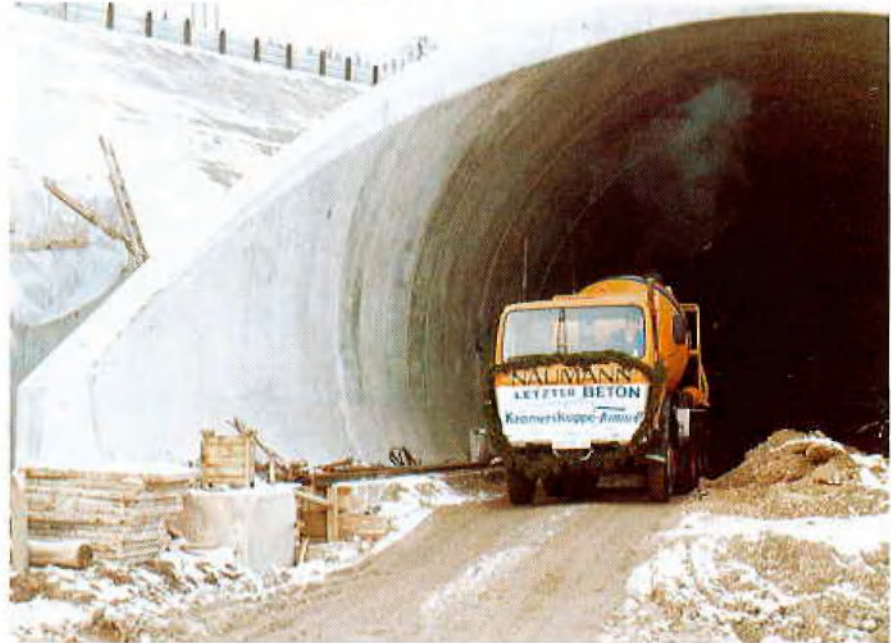
Krämerskuppeltunnel – der letzte Abschnitt wird betoniert
