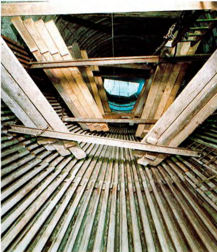
Abb. 3: Schleißschienen im Auslauf des Schrägbunkers
