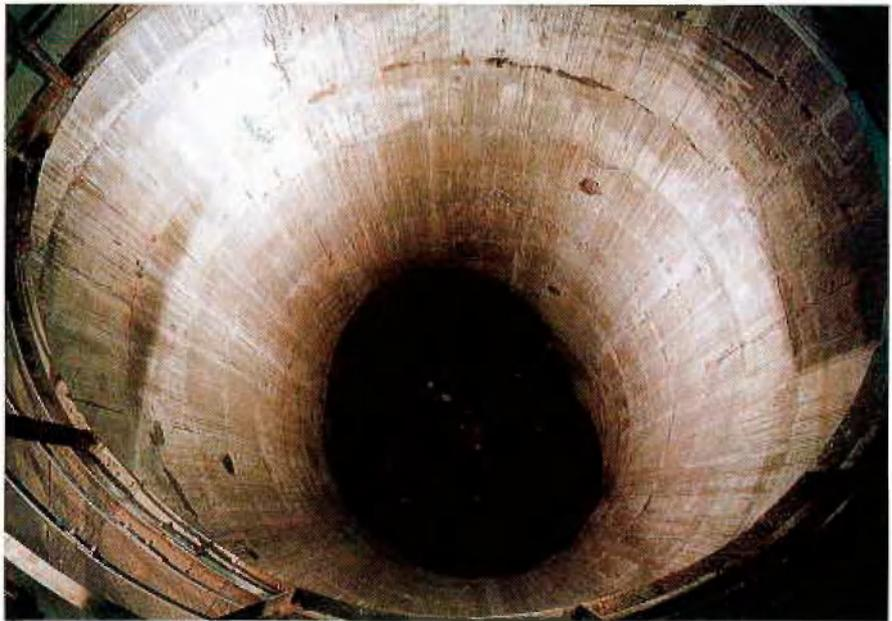
Abb. 11: Fertig betonierter Bergebunker
