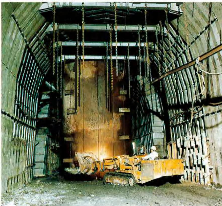
2. Auf diesen Kopfring wurde ein 16 m hoher Stahlzylinder aus 12-mm-Blech montiert (Abb. 2). Die Einzelsegmente des Zylinders sind aus Transportgründen 1,0 m x 1,7 m groß und von innen miteinander verschraubt. Für die Werkstattfertigung sind der Schachtdurchmesser und die Lage der Einstriche von der Markscheiderei vorher genau aufgenommen worden. Der Schachtzylinder hat zwei Aufgaben zu erfüllen:
