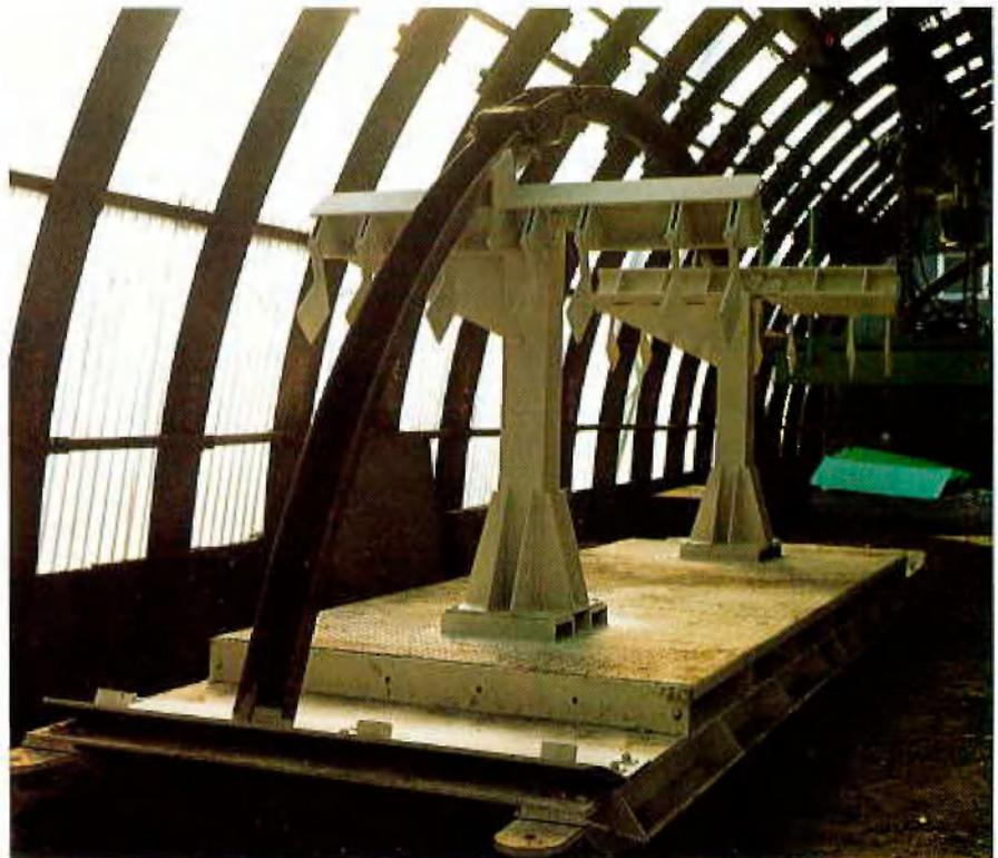
Nach dem Wegfüllen des Haufwerks werden zunächst 8 gebündelte Stempel mit der Transportkatze in den Ortsbereich gefahren. Auf jeder Streckenseite wird dann je ein Stempelpaar gestellt. Mit der Ausbauhilfe werden gleichzeitig zwei der vier vormontierten Ausbaukappen aufgenommen, rechtwinklig zur Streckenachse durch die Arbeitsbühne, die hierzu kurzzeitig abgesenkt wird, in den freigelegten Ortsbereich hinein-
