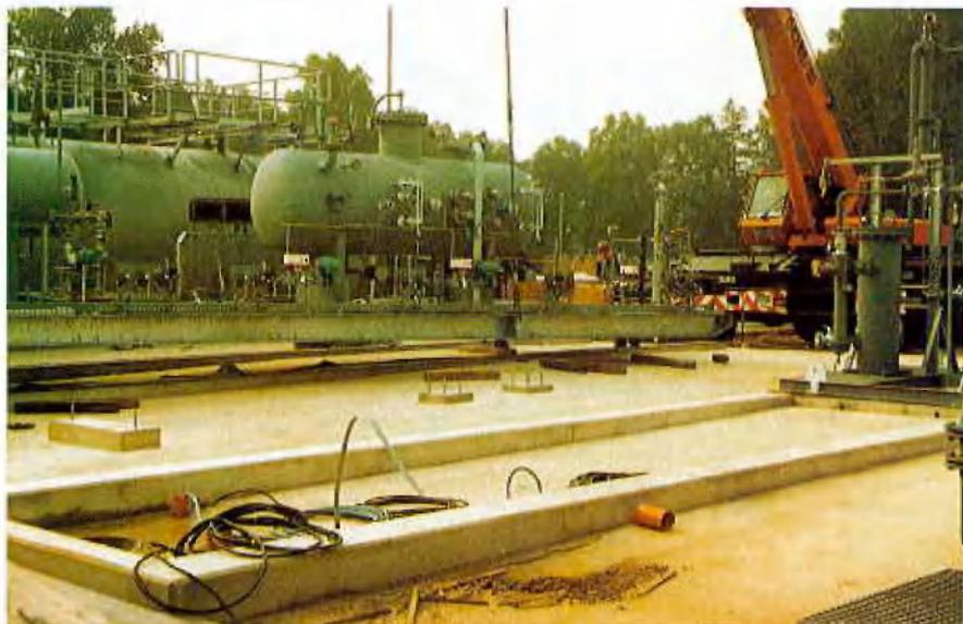
4200 m<sup>2</sup> Stahlbetonboden und 850 m Rammenschutzsockel ausgeführt. Weitere 1200 m<sup>2</sup> Boden und 750 m Sockel werden zur Zeit hergestellt.
