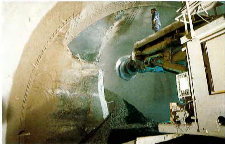
Abb. 5: Herausschneiden der Restkalotte bei gleichzeitigem Abbrechen der Spritzbetonschale der Ulmen im Firststollen
