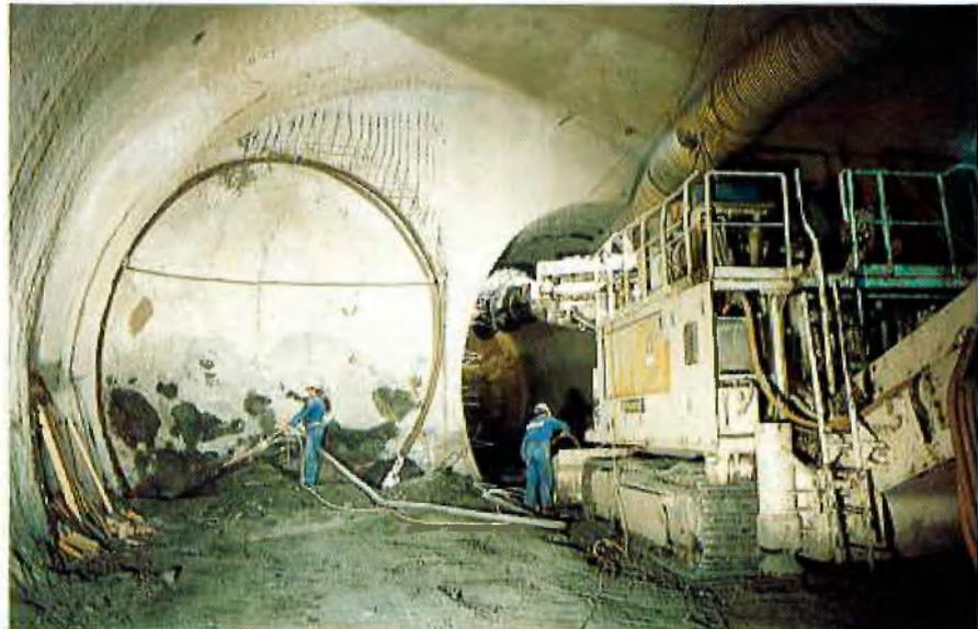
Abb. 12: Setzen des ersten Ausbaubogens in der linken Röhre
