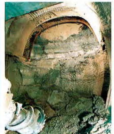
Mit Hilfe der Teilschnittmaschine E 242 erfolgte das Auffahren des Firststollens (Abb. 7) und des erweiterten Querschnittes leistungsgerecht und rasch:
