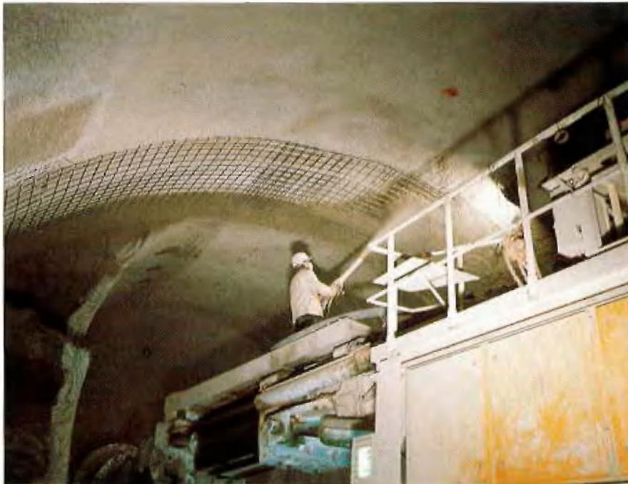
Abb. 8: Einbau der zweiten Lage Baustahlgewebe und Spritzbeton in der aufgeweiteten Strecke
