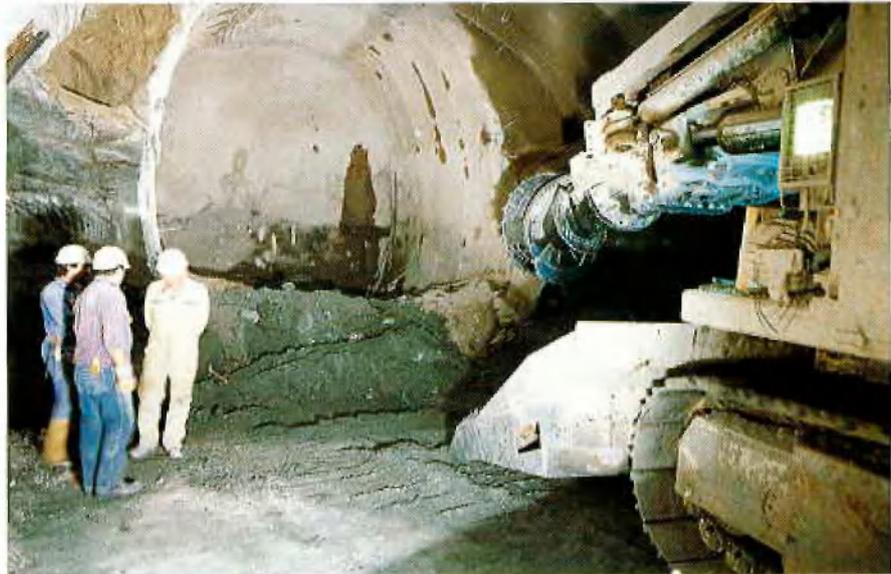
Abb. 4: Firststollen, Restkalotte und Reststrosse mit Teilschnittmaschine
