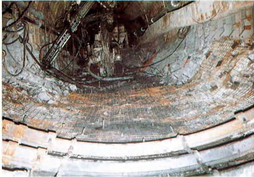
Abb. 3: Sohlenankerung und Sohlensegmente
