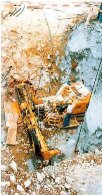
Kernbohrungen für Daueranker
