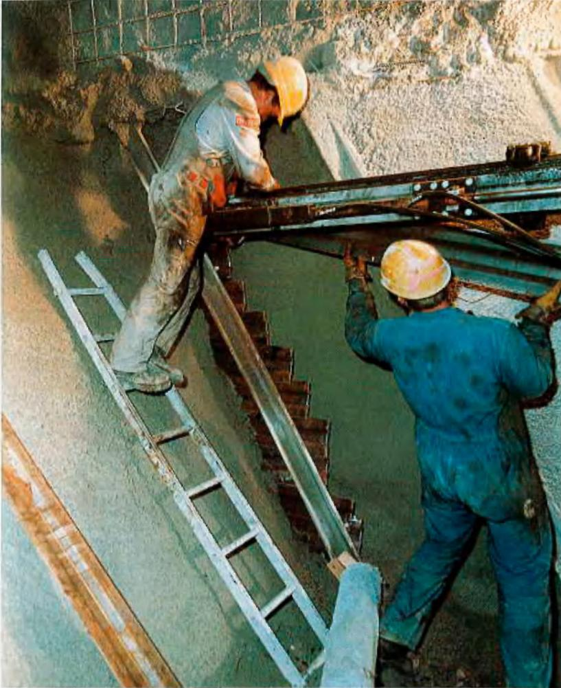
Abb. 7: Vorpfändarbeit mit Dielenschlaggerät
