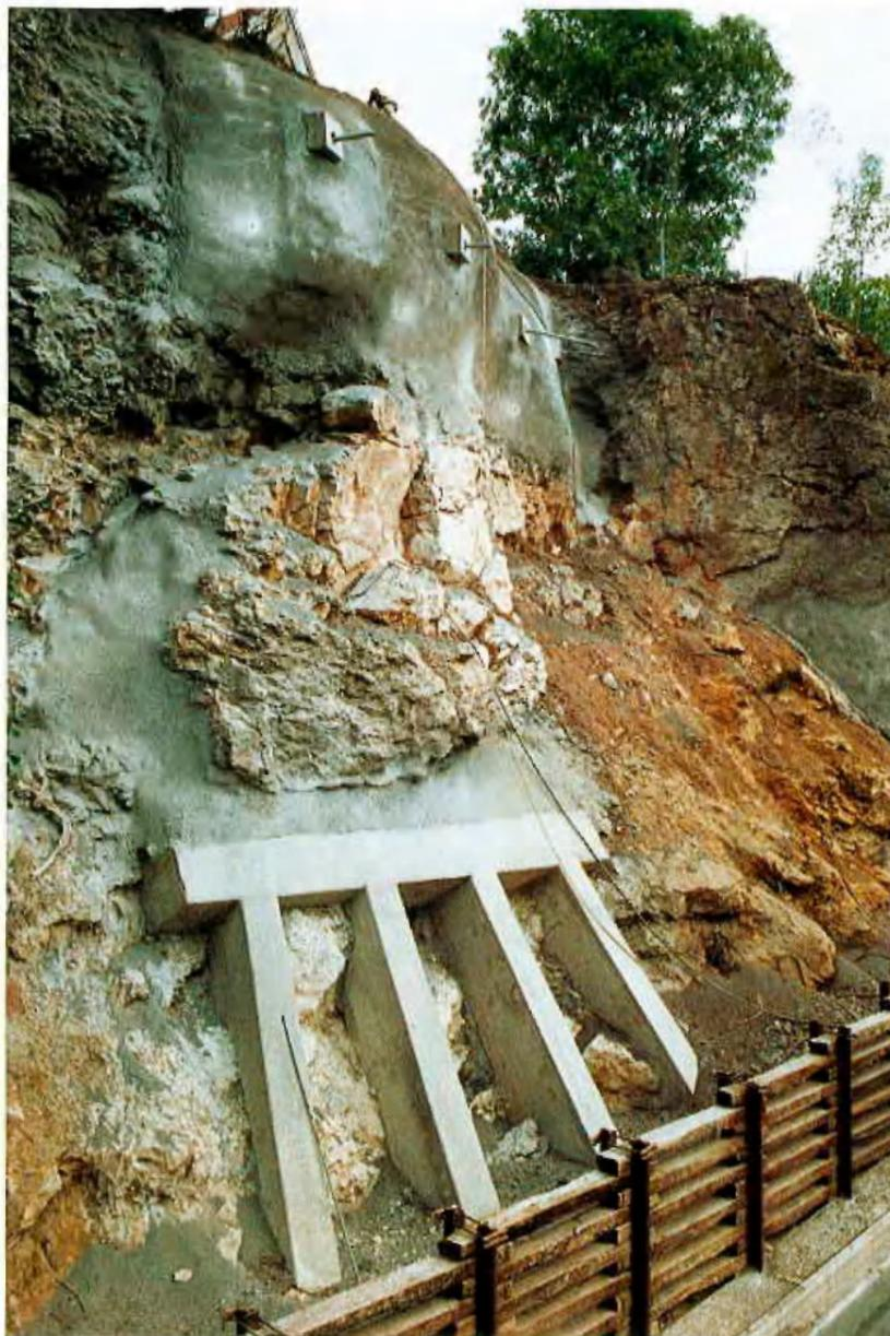
Hangseitige Daueranker und Unterstützungsbauwerk
