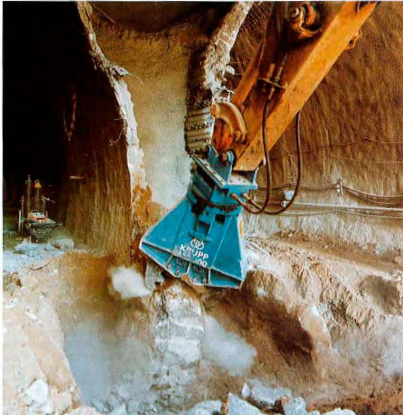
Abb. 9: Einsatz einer hydraulischen Betonschere beim Kernvortrieb
