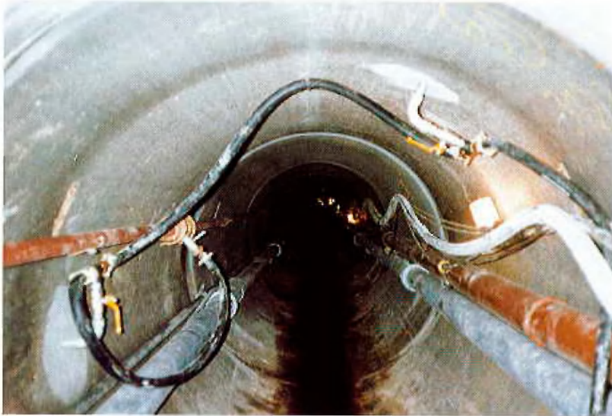
Gepreßter Rohrstrang mit Versorgungsleitungen
