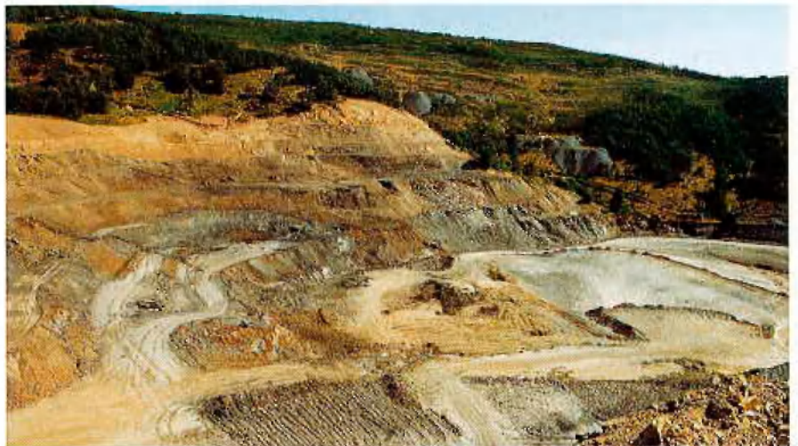
Erdarbeiten am Schachtplatz Tabliza
