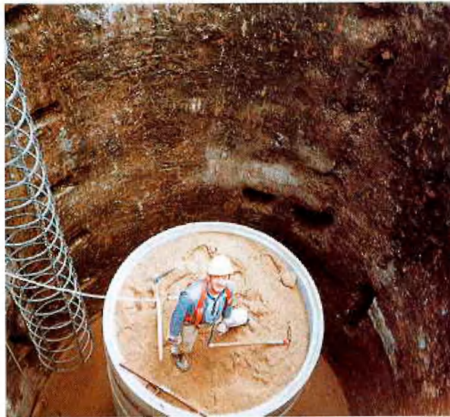
Vorbausäule im Schacht Westphalia
