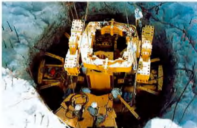
Schachtbohrung am Hoover-Damm
