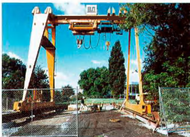
Rohrvortrieb in Uerdingen
