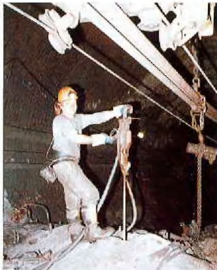
Abb. 4: Abbohren der Streckensohle
