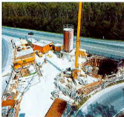
Baustelleneinrichtung am Schacht 1
