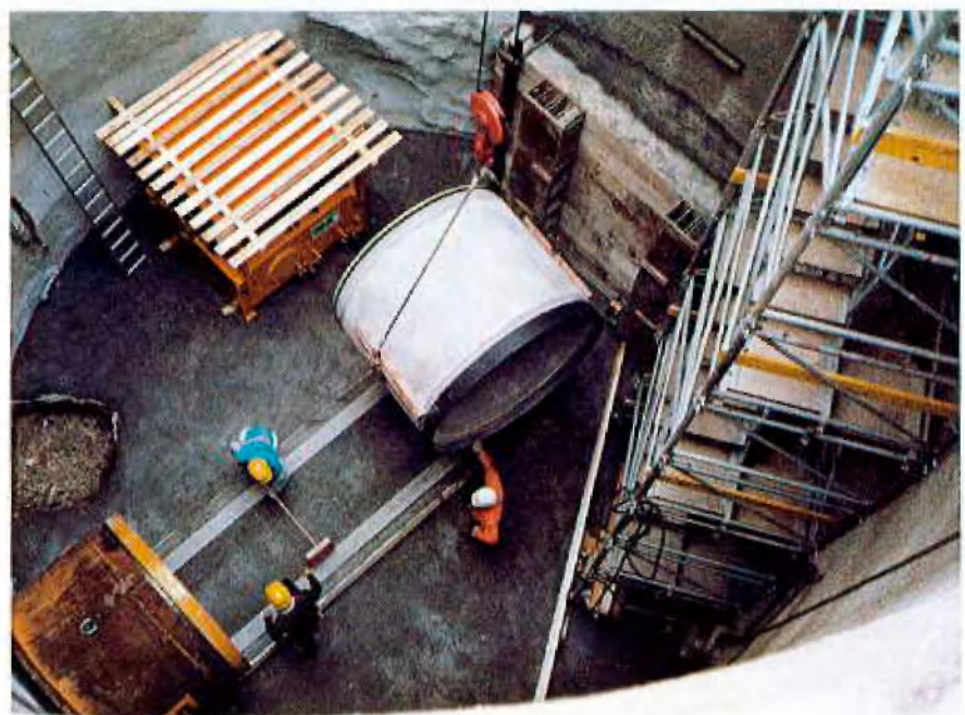
Einrichten der Preßgrube
