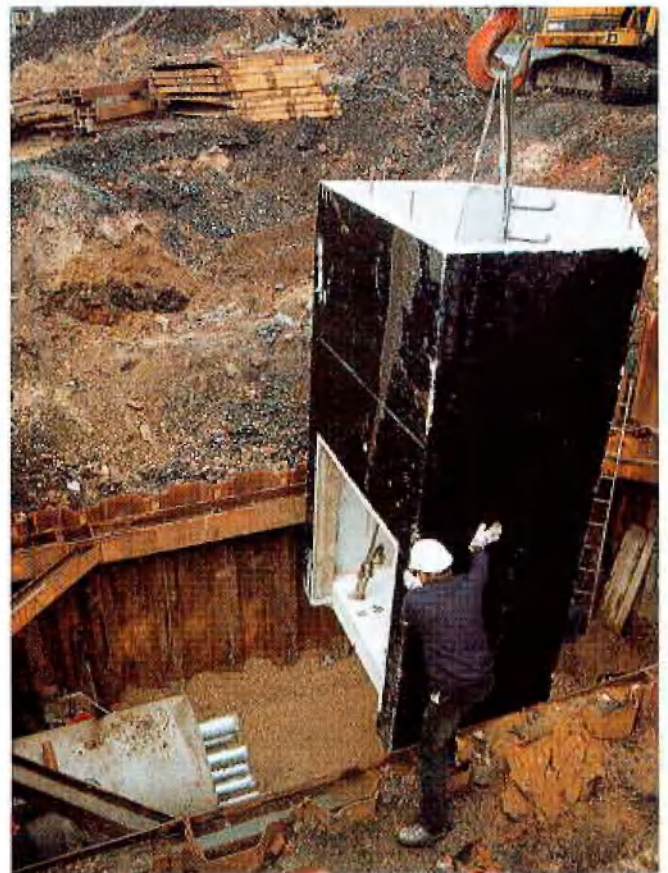
Kanalbau Bergwerk Hugo
