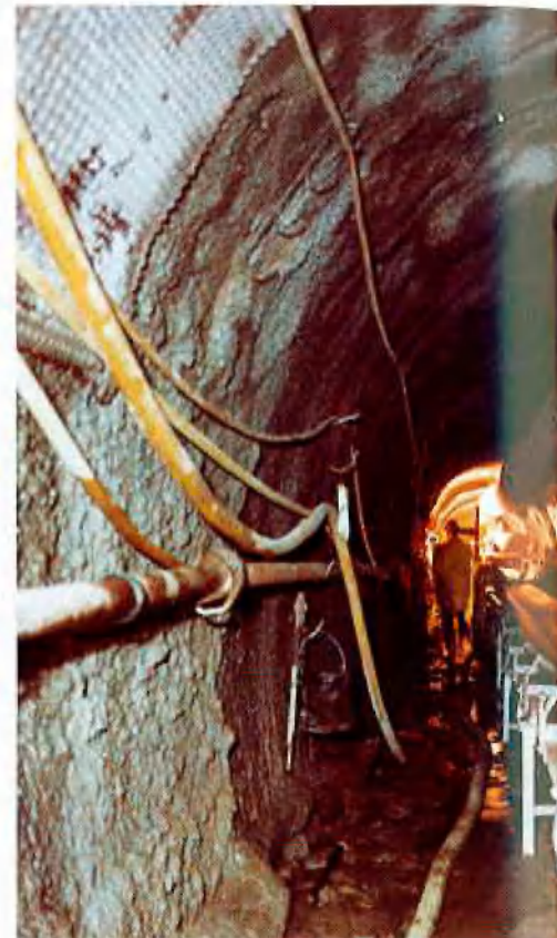
Bandanlage im Stollen
