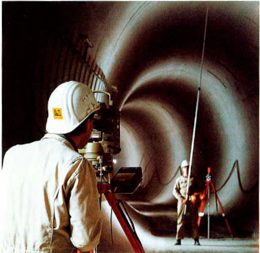
Profilkontrolle einer Gewölbekinnenschale
