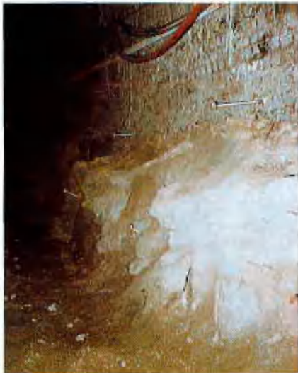
Abb. 8: In den Streckenstoß eingebrachte Anker
