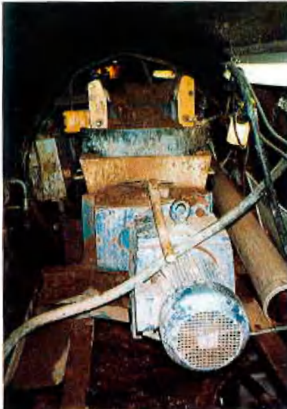
Übergabe-Station mit Brecher
