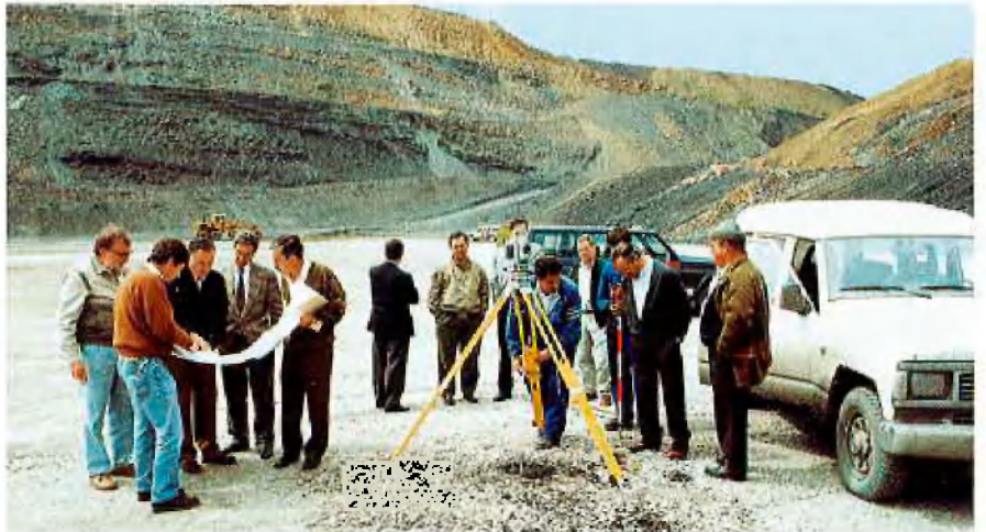
Einmessung des Schachtmittelpunktes am Schacht Tabliza
