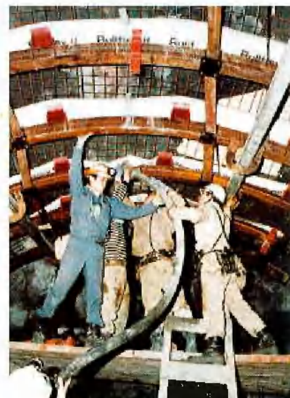
Einbau der Schräuche
