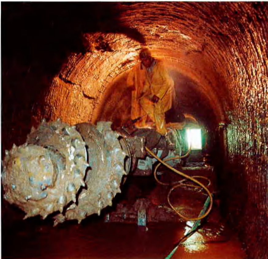
Teilschnittmaschine vor Ort
