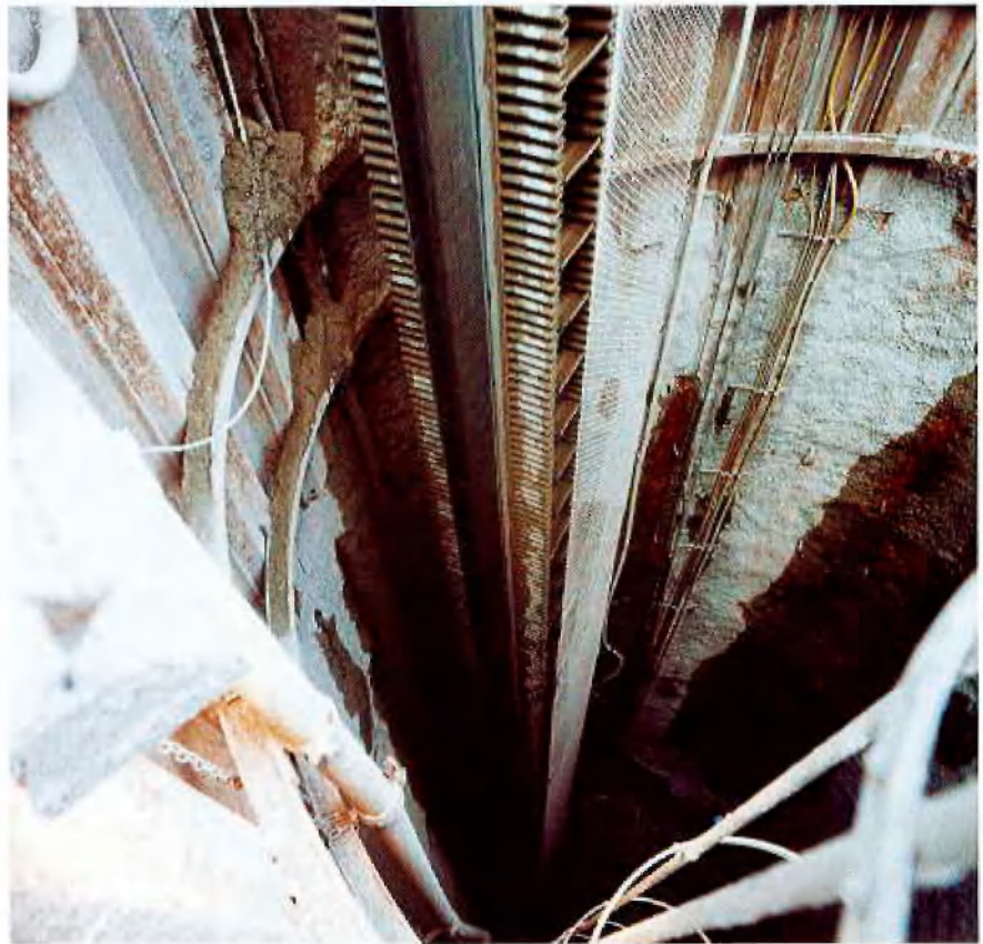
Vertikalförderer im Schacht
