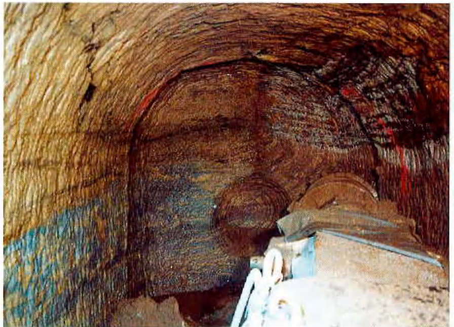
Ortsbrust und Ausbruchslaubung
