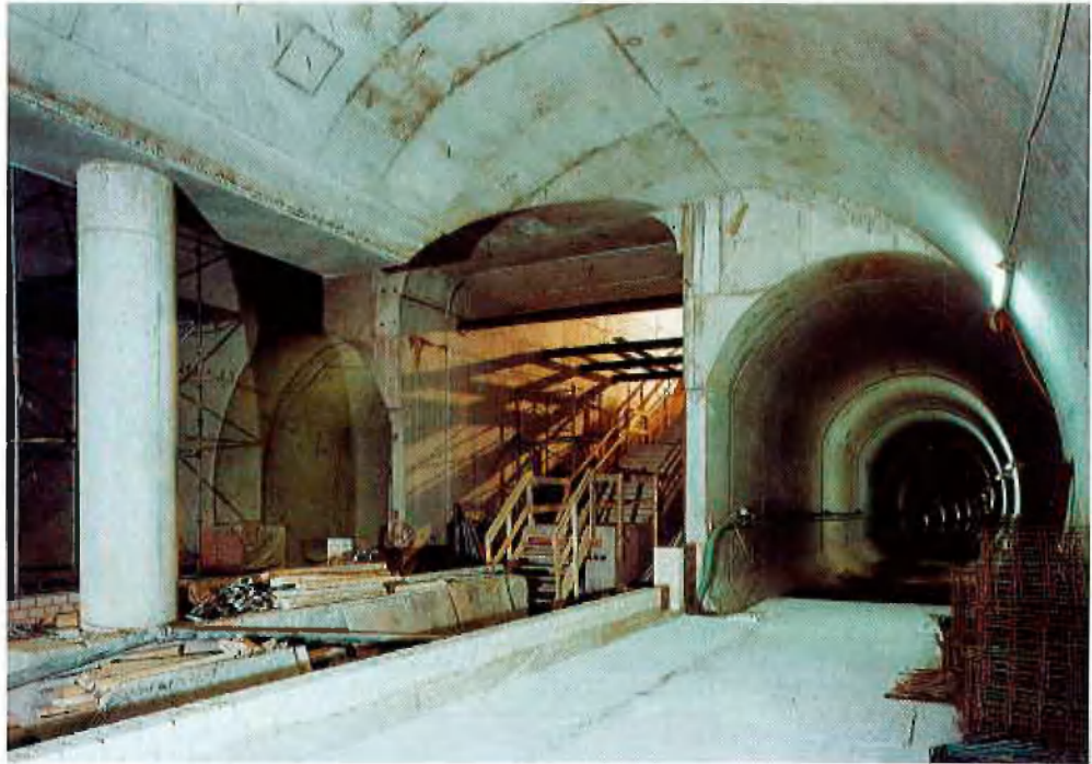
U-Bahn-Baulos K5 in Dortmund
