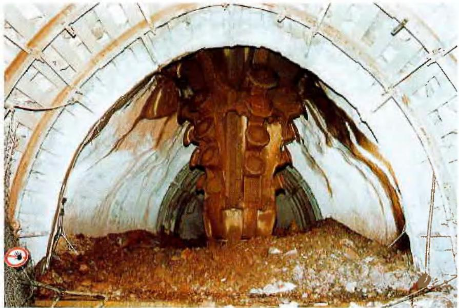
Abb. 3: Durchörterung des Brandberganschlages
