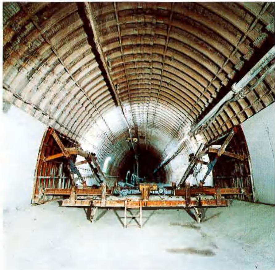
Einbringen des Stoßbetons mit DH-Schalung
