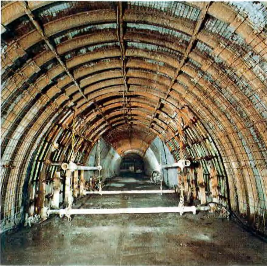
Einbringen von Sohlen- und Stoßbeton in den Verbindungsstrecken
