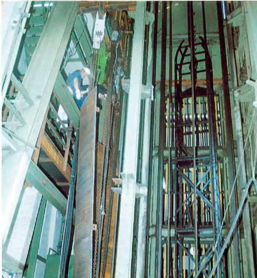
Einhängen der Stahlblechsegmente
