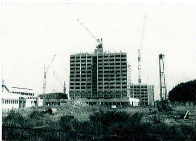
② Baustelle am Romberg-Park
