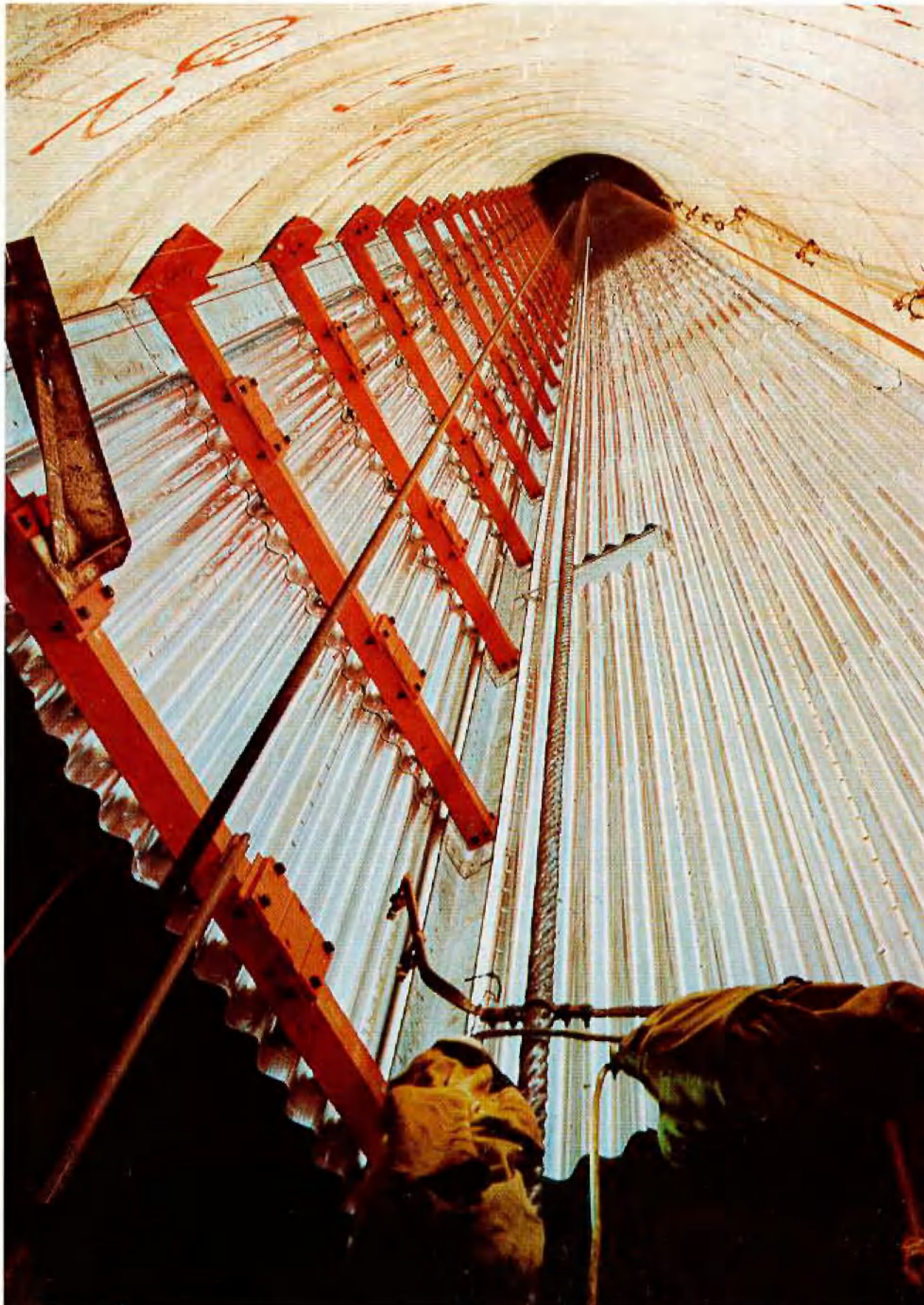
Einstriche und Wetterscheider im SchachtASSE 2
