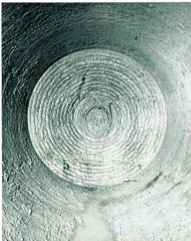
Blick in gebohrte Tunnelröhre
