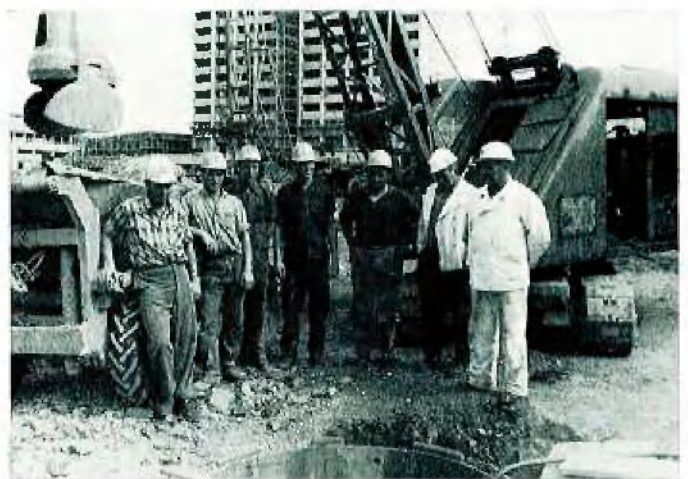
⑥ Belegschaft der Baustelle
