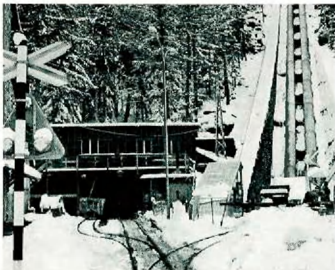
Tunneleingang Schrägschacht Barberine und alte Hangleitung
