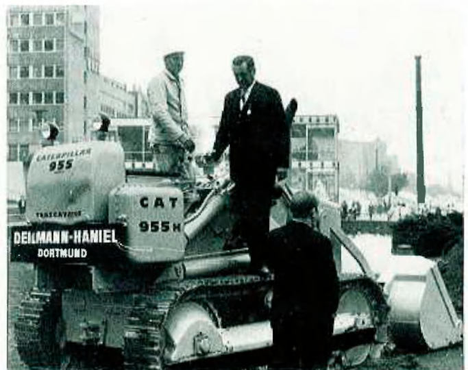
Geschäftsführer Dr. Ingo Späing auf der Baustelle
