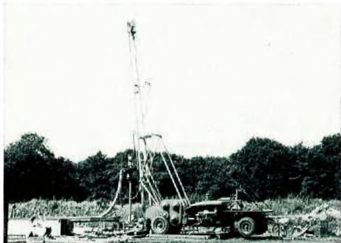
③ Lufthebebohranlage SKL 3
