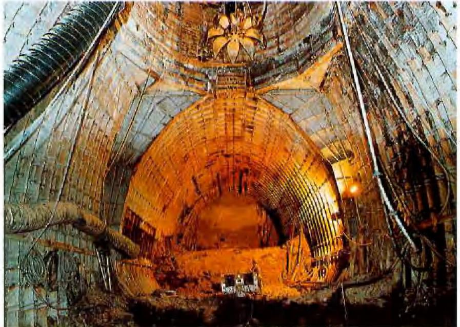
Abb. 5: Scheibe III, Beginn des Ausbruches und Einbringen des Ausbaues Scheibe III Süden
