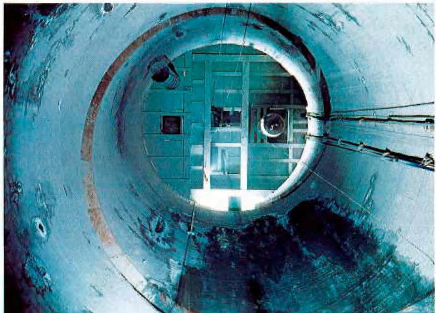
Abb. 2: Riegel und Abdeckbleche über die Schiebeklappe in der Öffnung für die Befahrungsbühne werden später entfernt
