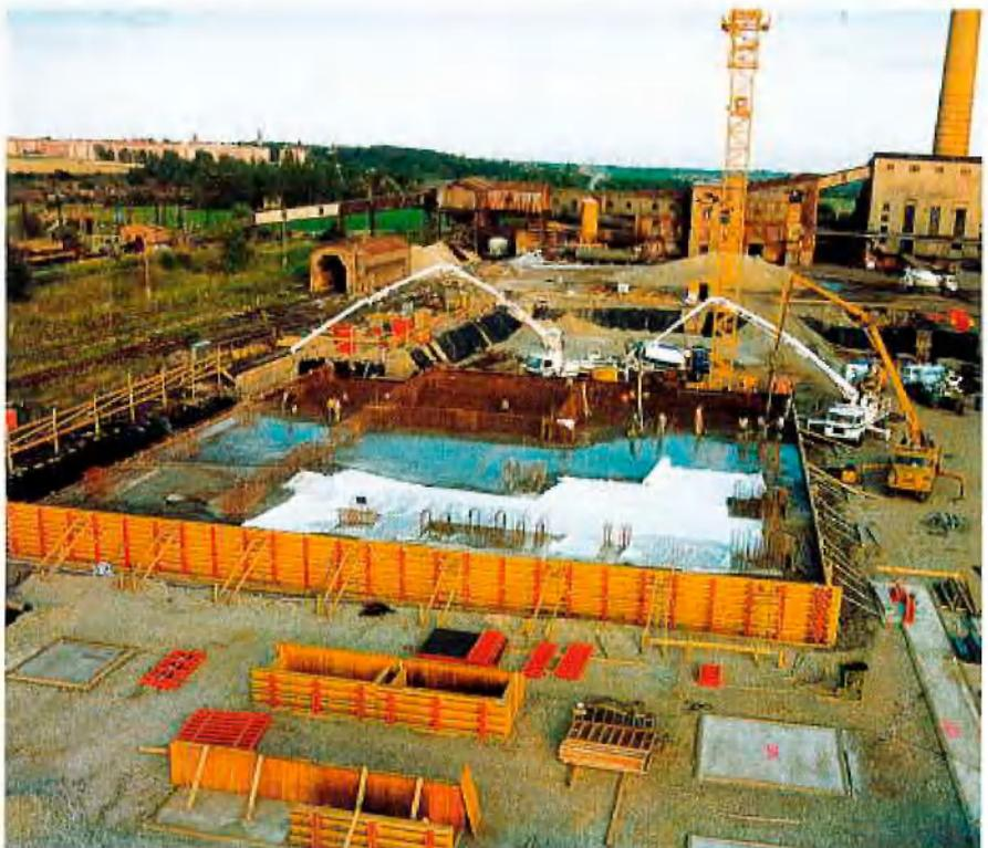
Betonieren der Kesselhaus-Fundamentplatte mit Abdeckung der fertigen Fläche
