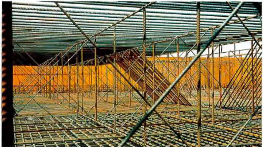
Bewehrung der Fundamentplatte für das Kesselhaus
