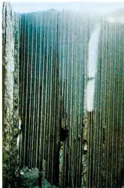
Der Sägeschlitz mit unüblicher Krümmung
