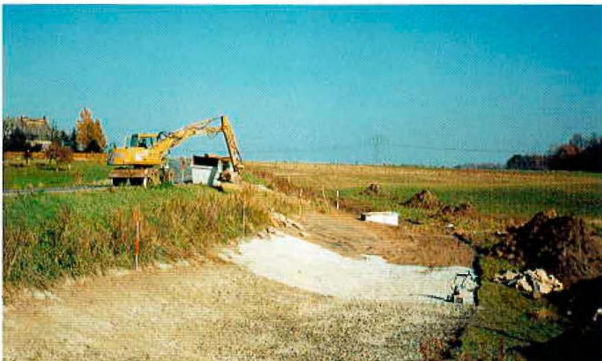
Aufbringen von Tonmehl und Zement auf die vorbereitete Dichtfläche
