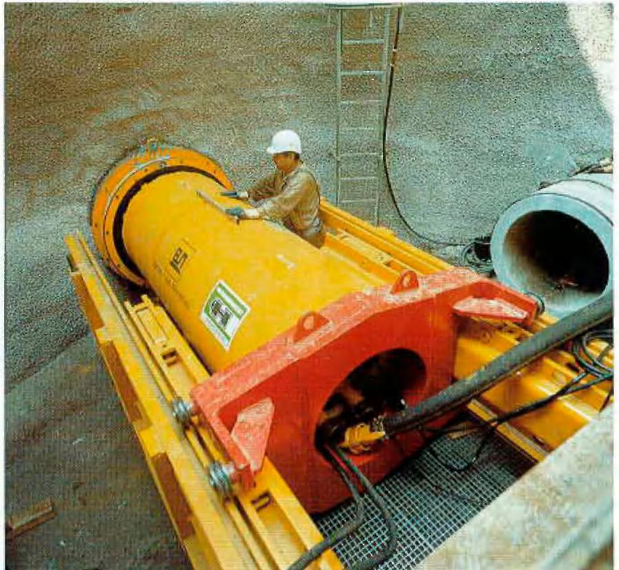
Rohrvortriebsmaschine im Pressschacht
