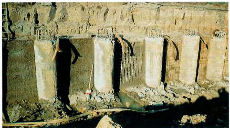
Verlauf der Spritzarbeiten vom Einbau der Matten bis zum Spritzen
