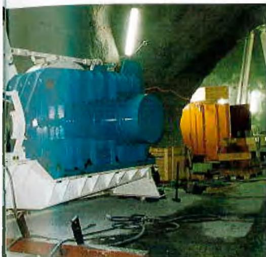
Der für die Hinterfüllung notwendige Mörtel wird in einem besonderen Behälter transportiert, der ebenfalls mit dem Förderwagen zwischen der Kaverne und dem Nachläufer verfahren wird. Wasser, Schienen für den Nachbau des Tunnelgleises und andere Materialien werden sämtlich mit der Schrägschachtförderanlage zwischen dem Nachläufer und der Kaverne umgeschlagen. Für Personenfahrten zwischen dem Nachläufer und der Kaverne ist der Förderwagen mit einem Passagierabteil ausgestattet worden.
