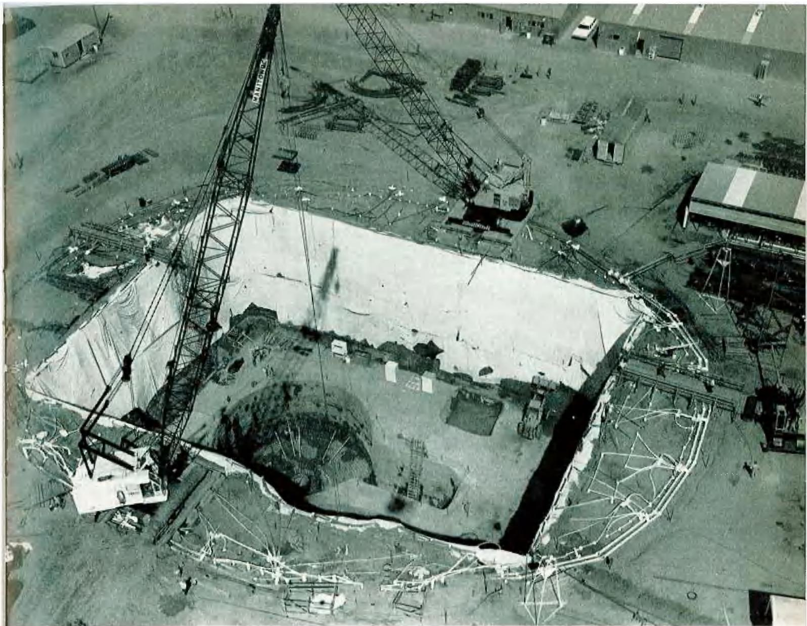
betragen, wurde mit dem Aushub unterhalb des ursprünglichen Grundwasserspiegels begonnen. Während der Aushubarbeiten wurden die Temperaturen in den LN-Löchern und Meßrohren laufend kontrolliert.
