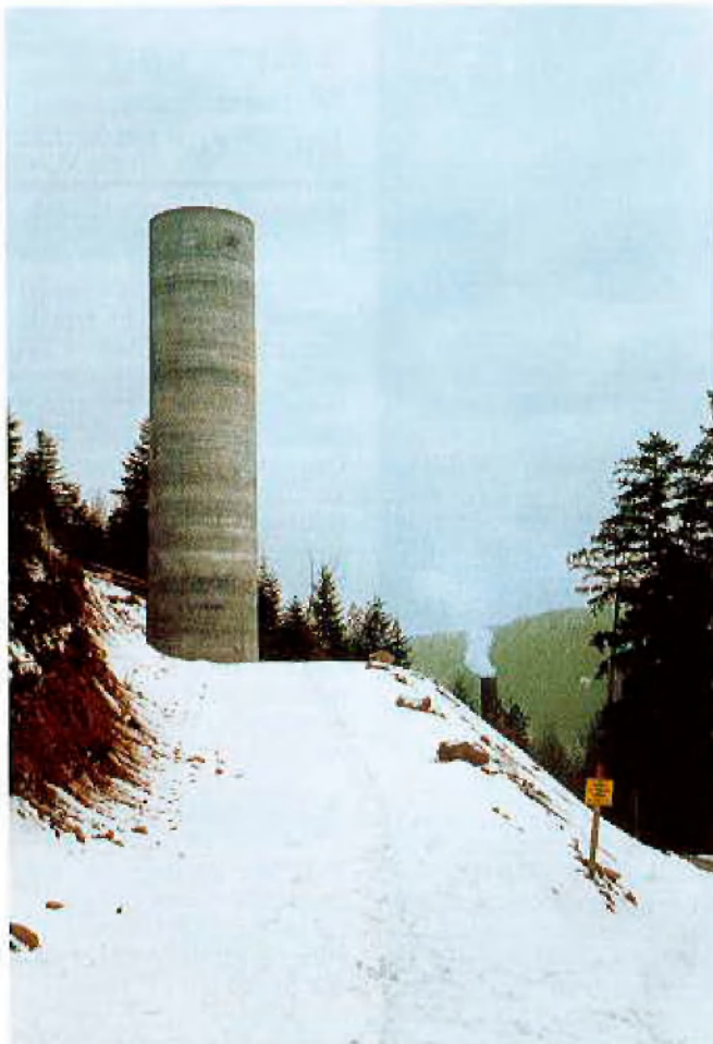
Lüftungsschacht Bad Wildbad
