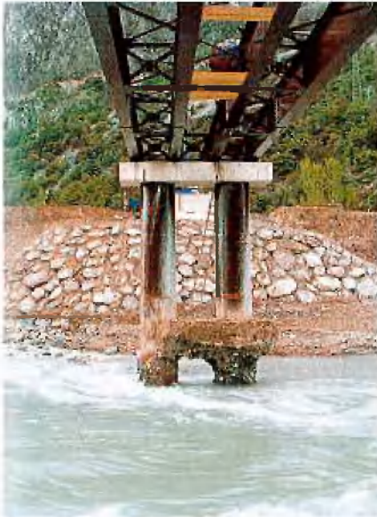
Baustellenzufahrt über den Inn
