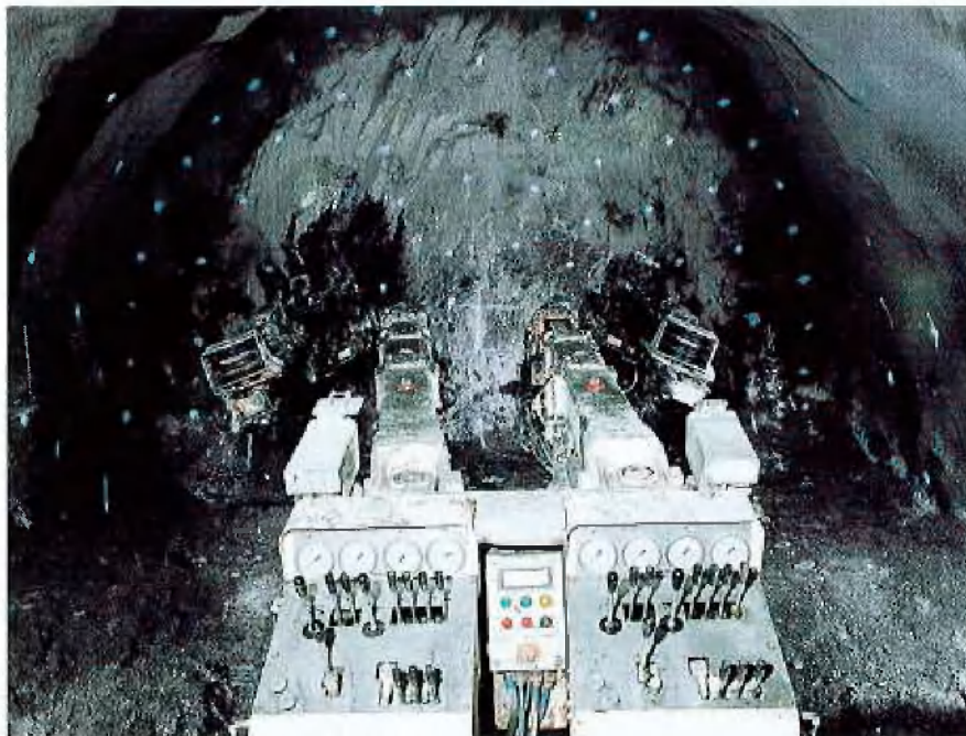
Blick über den Steuerstand nach vor Ort
