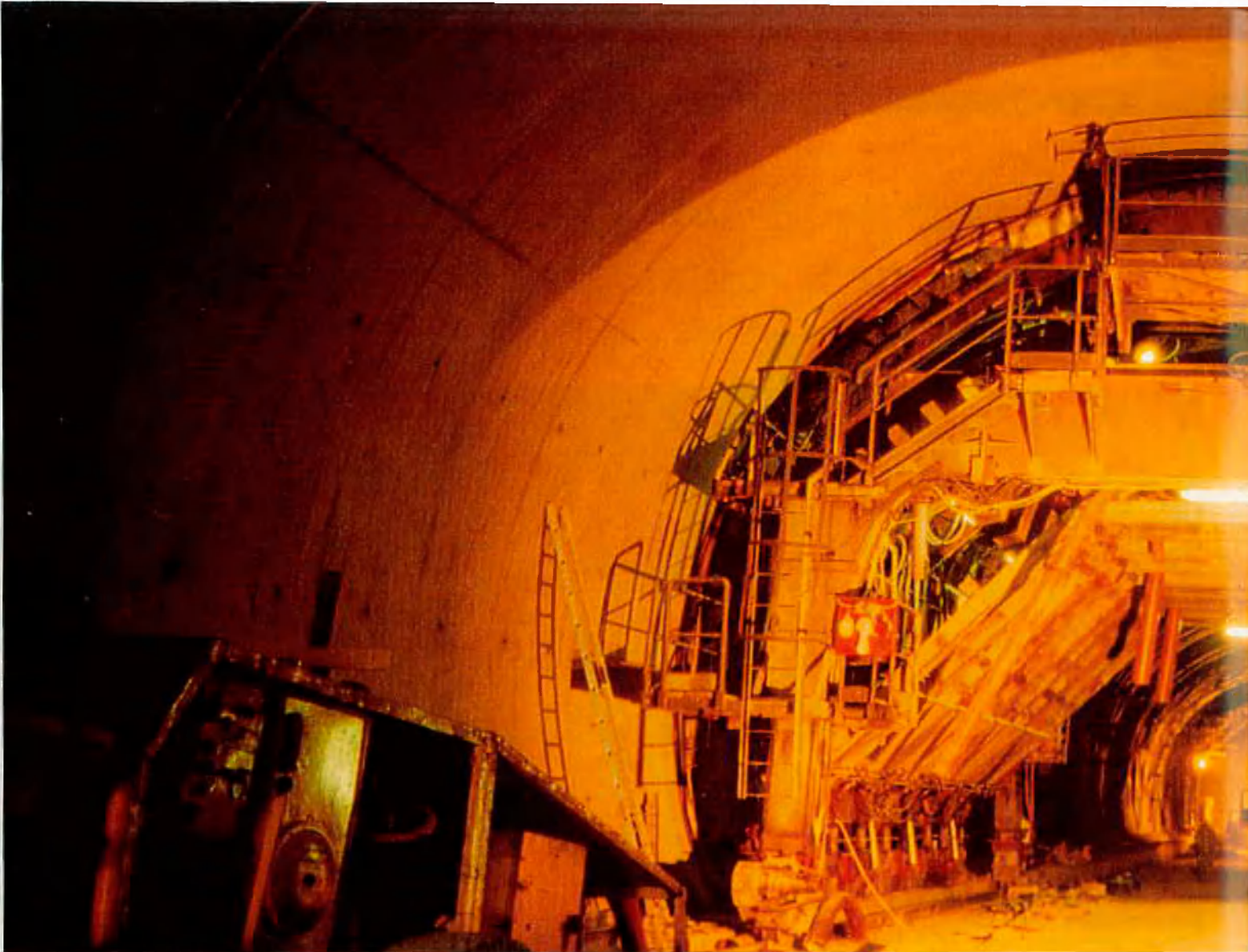
Selbstfahrender Schalwagen
