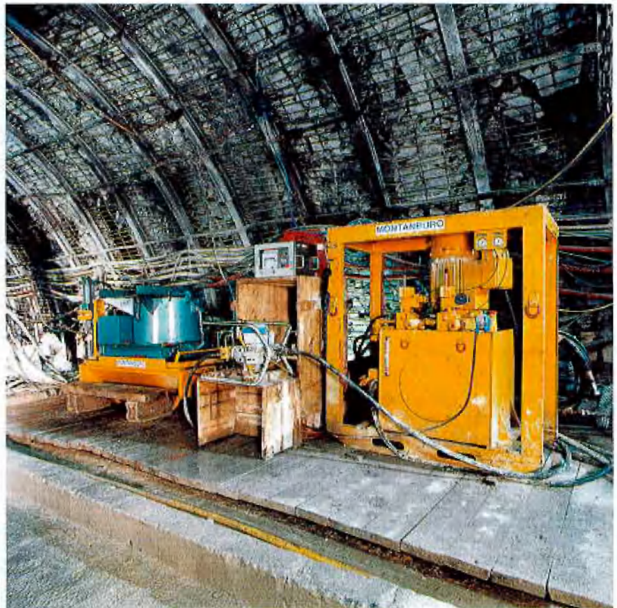
Injektionsanlage mit Registriereinrichtung
