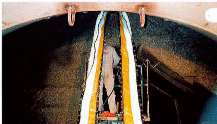
Einbau der O-Ring-Abdichtung
