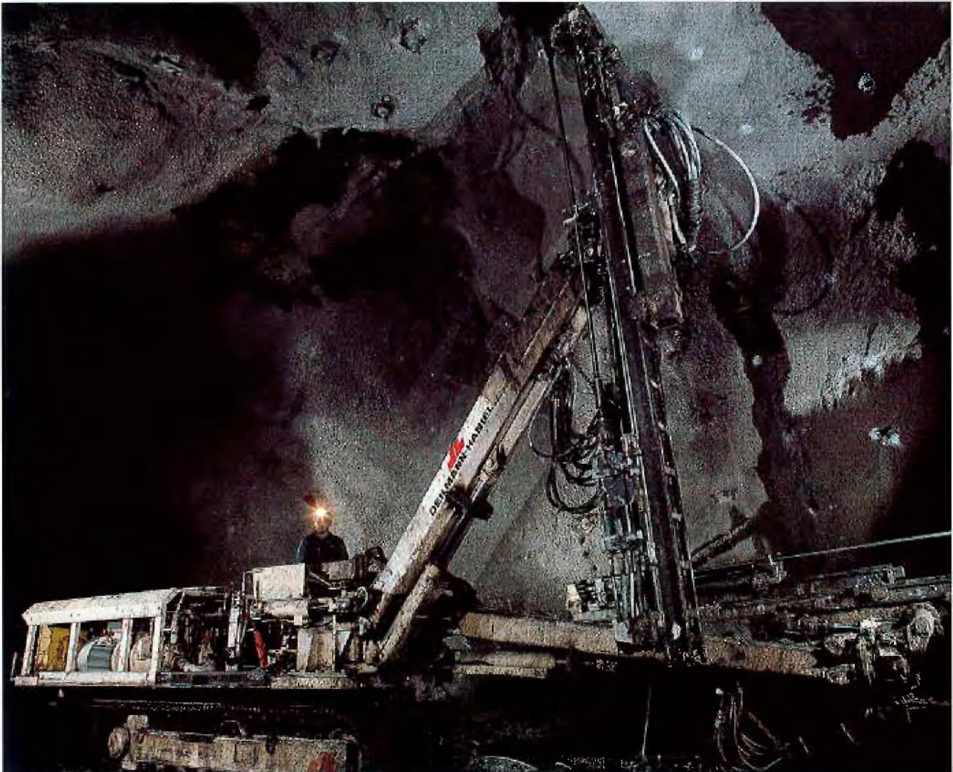
Bohrwagen beim Ankerlochbohren
