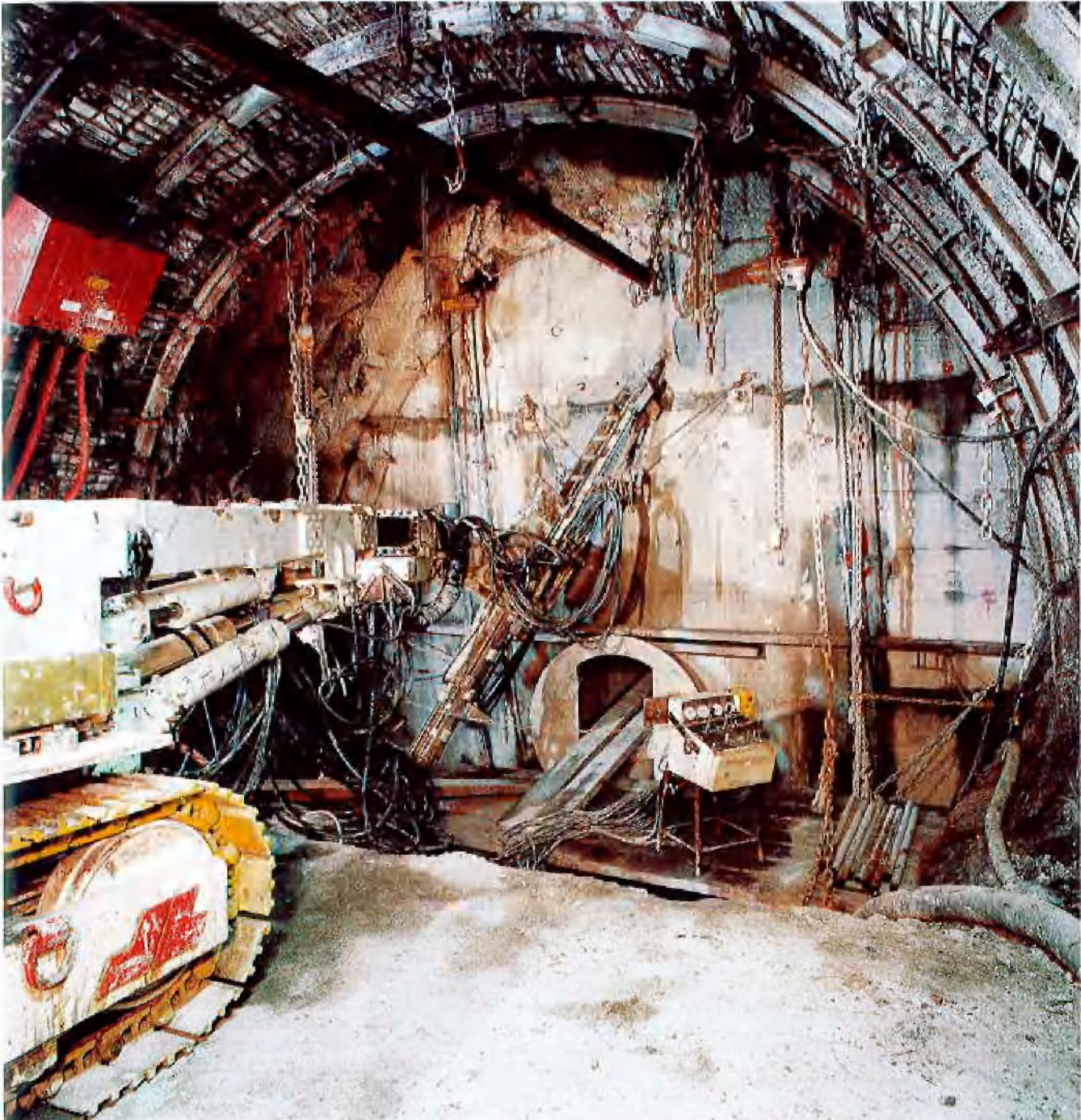
DH- Bohrwagen Typ BTR 1- 305 KV auf der Wasserseite
