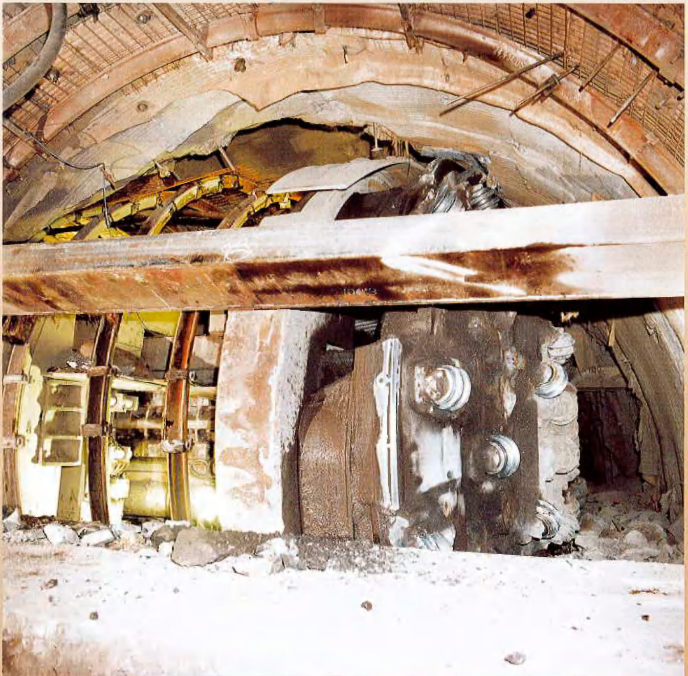
Durchfahren der Basisstrecke
