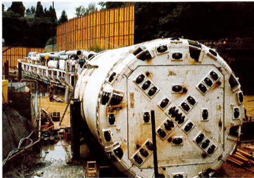
Bohrkopf der Vollschnittmaschine
