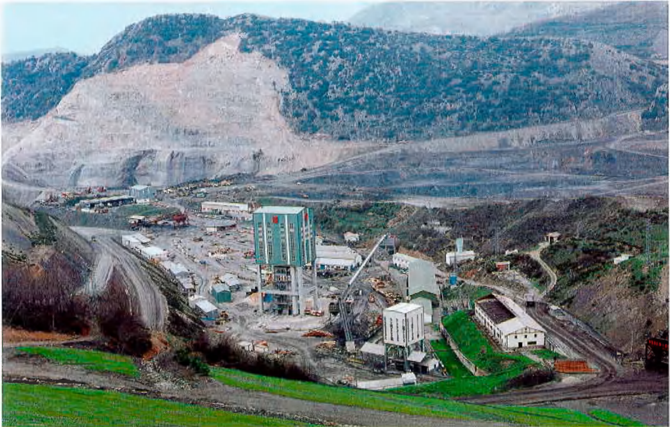
Schacht Santa Lucia
