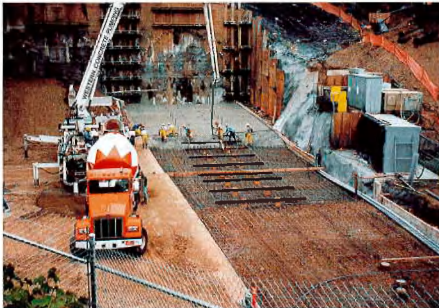
Fundament für die Montage der Vollschnittmaschine
