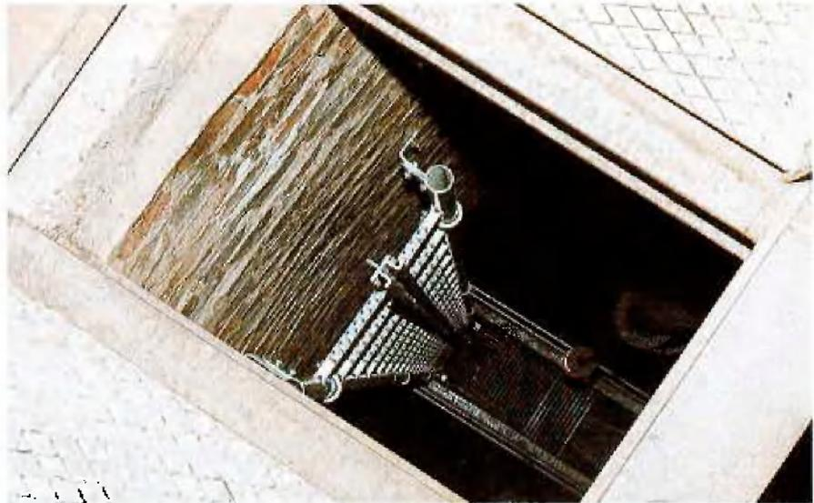
Öffnung für Material- und Gerätetransport, Befahrungseinrichtung mit Ruhebühne
