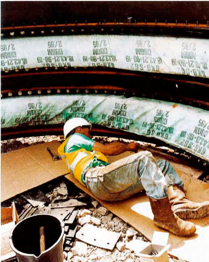
Abb. 3: Einbau der Abdichtungen in den Stahlring auf dem Schachtplatz
