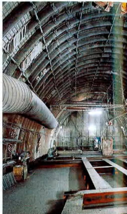
Haspelkammer mit Unterbau für die Teufeinrichtungen
