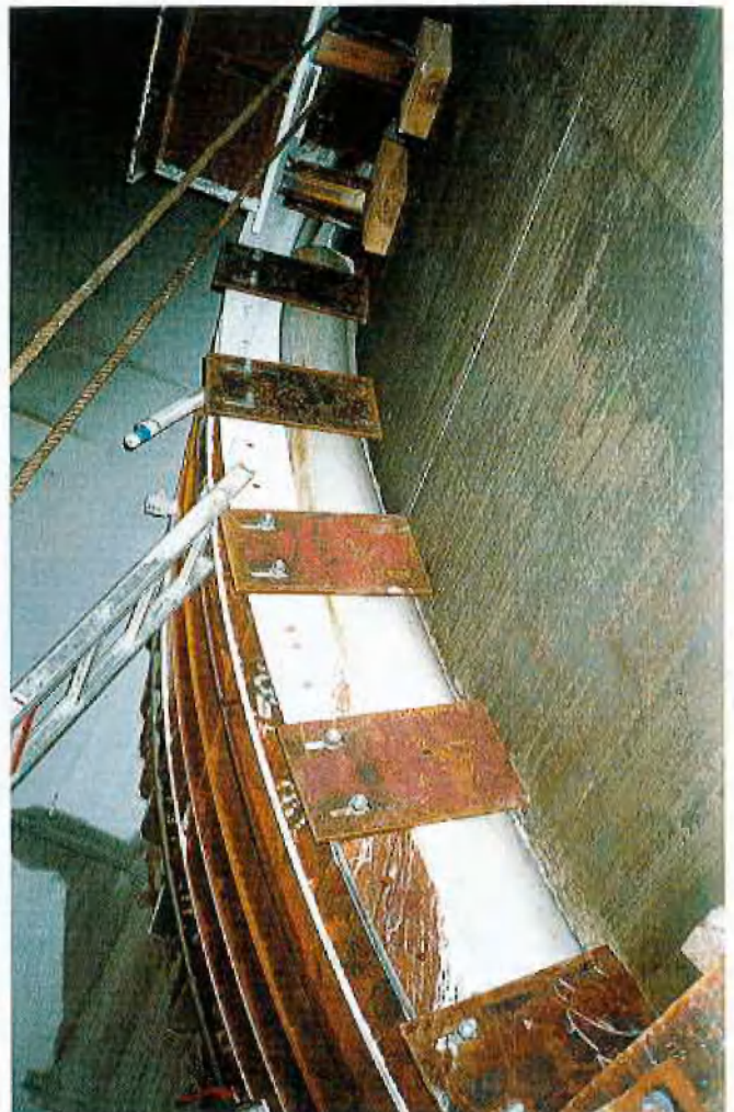
Bullflex-O-Ring-Abdichtung während der Befüllung
