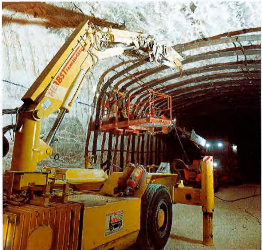
Stellen der Ausbaubögen mit Mobilkran und Hebebühne
