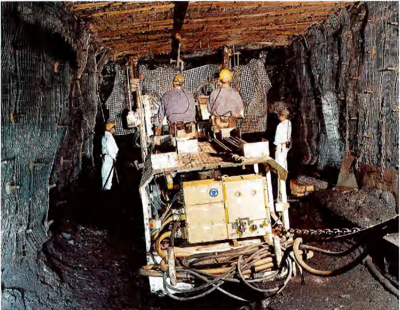
Bohrwagen in der trapezförmigen Ankerstrecke
