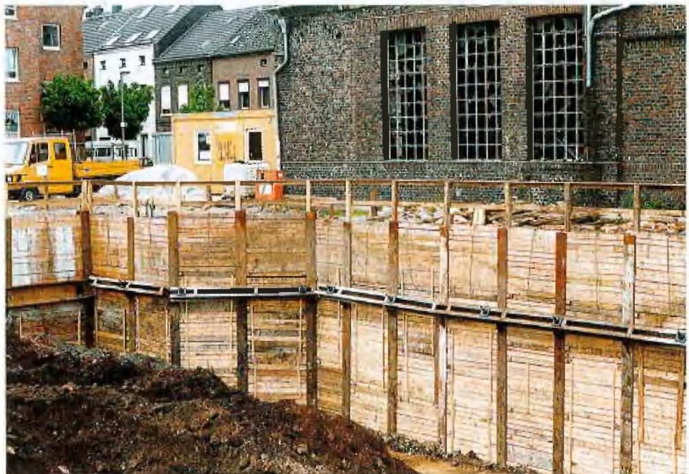
Verbauarbeiten in Düsseldorf
