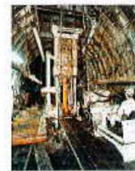
Raise-Bohrmaschine auf dem Bergwerk Ost
