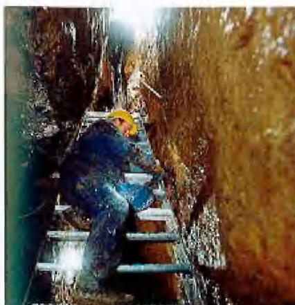
Montage der Treppe untertage
