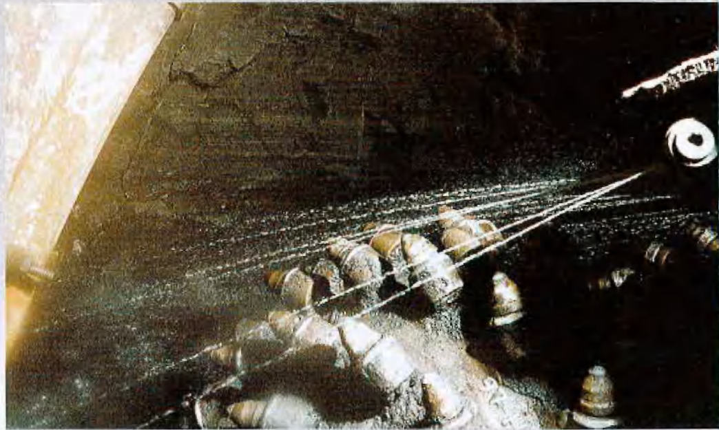
Bedüsung nach dem Zuschalten von Wasser
