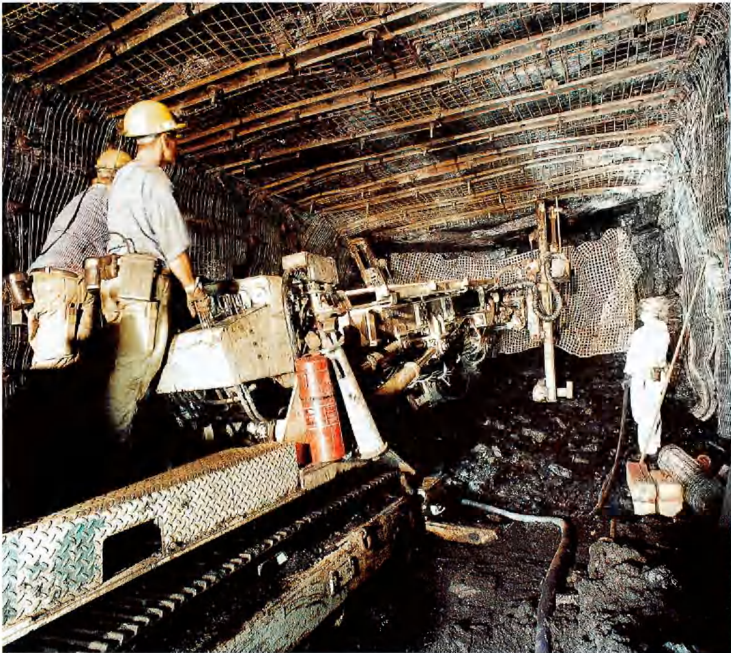
Bohrwagen BTR 2 beim Eindrehen der Anker
