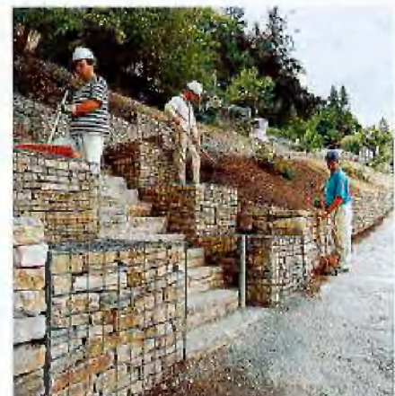
Treppenaufgang mit Trockenmauern
