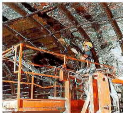
Hinterfüllarbeiten mit Spritzdüse
