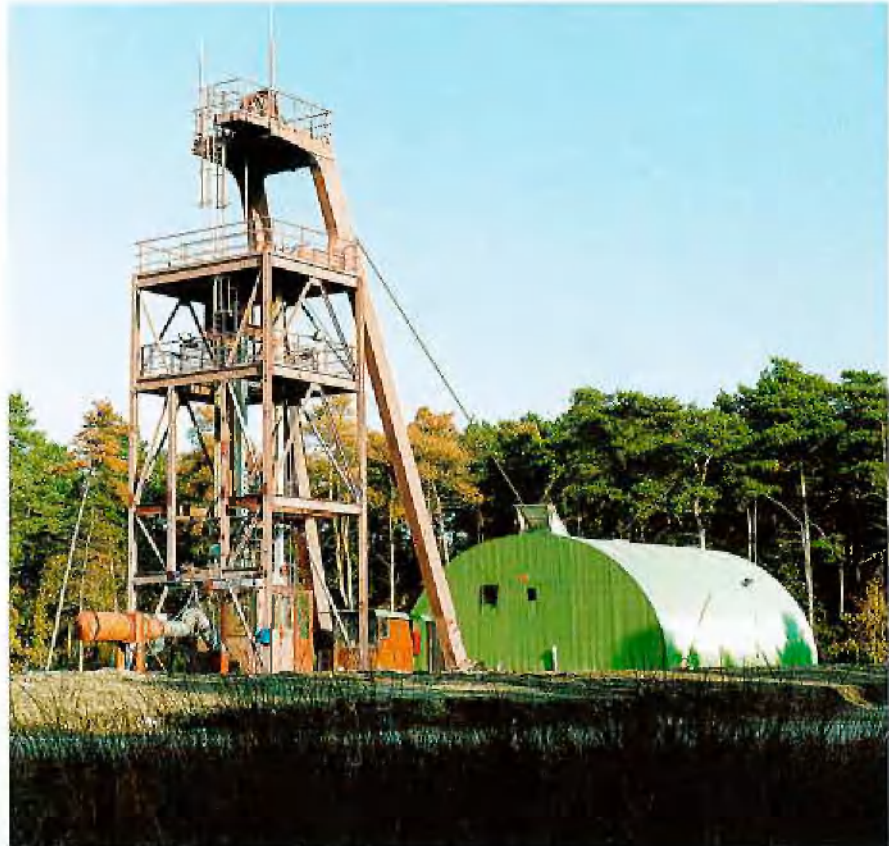
Förderturm mit Maschinenhalle
