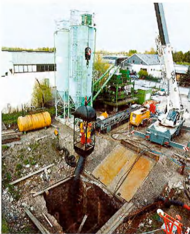
Verfüllung Schacht Jacob in Bochum
