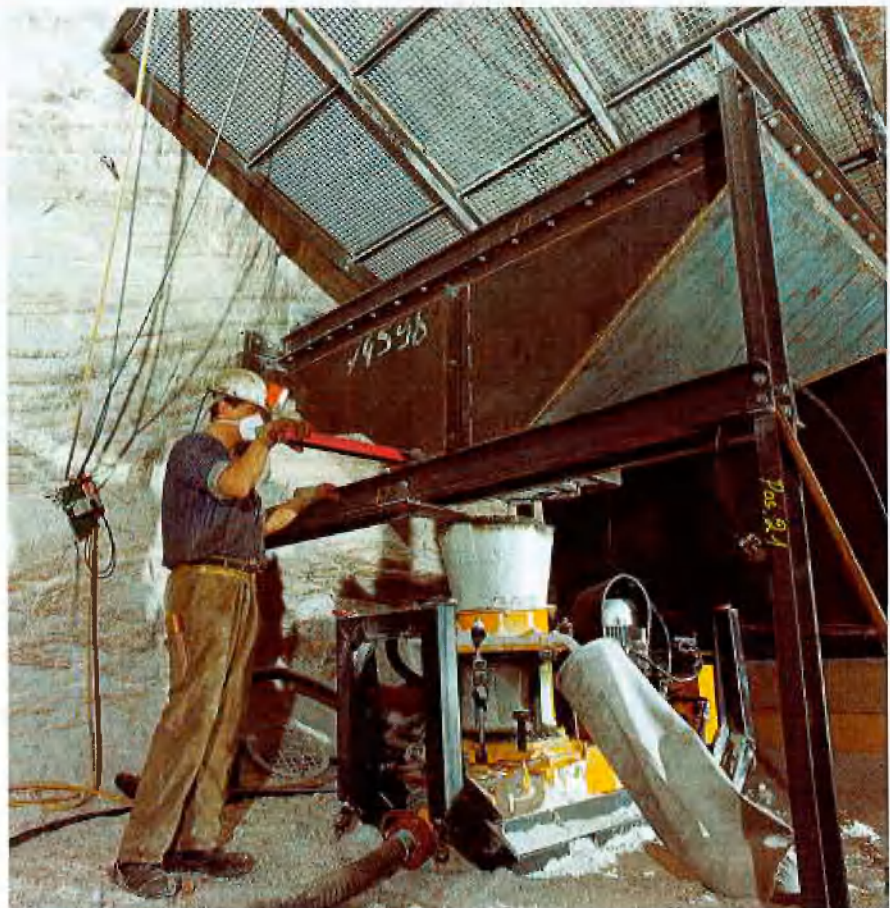
Zwischenbunker mit Spritzmaschine Aliva 265
