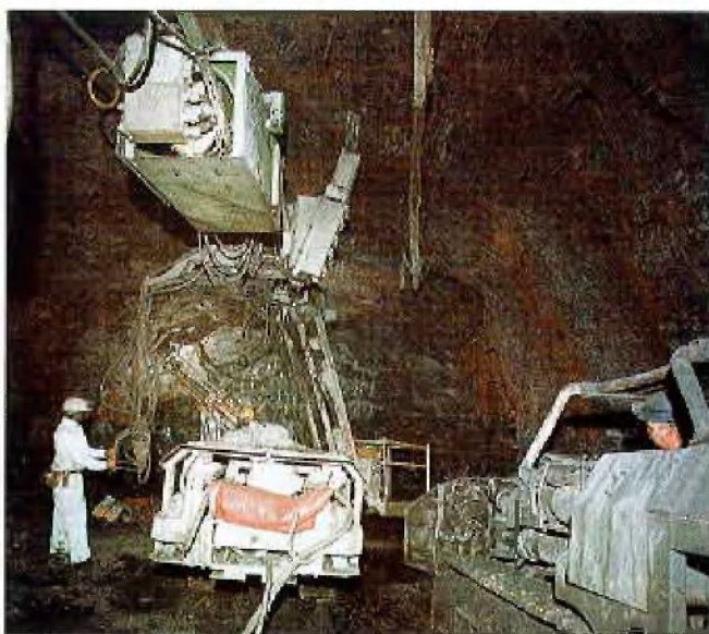
Einbringen von Kombi-Ausbau auf Ewald/Hugo
