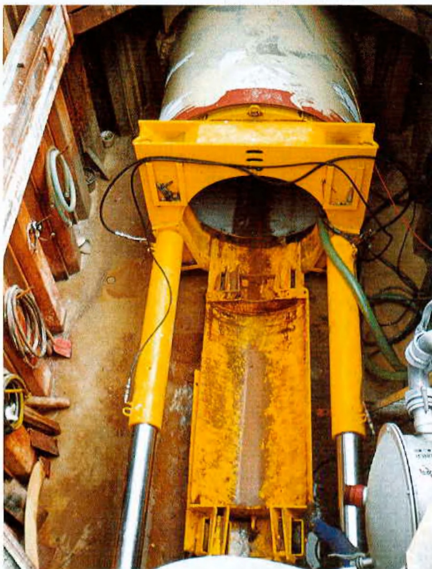
Pressgrube für den Vortrieb des Regenwassersammlers
