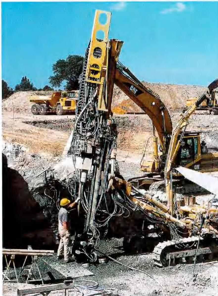
Herstellung der GEWI-Pfähle mit speziellen Pfahlbohrgeräten
