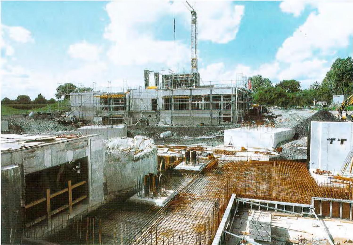
Rohbauarbeiten, im Vordergrund die Flachgründung der Schachthalle mit zwei Fundamenten für das Schachtgerüst, links der im 1. bertaägten Bereich abgebrochene Schacht Lerche
