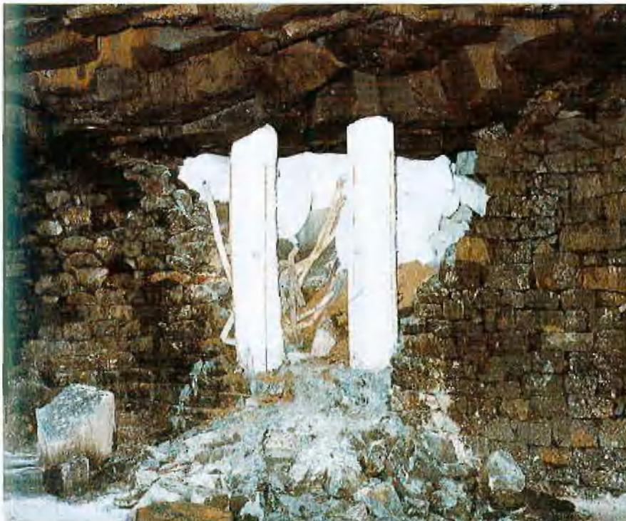
Sicherung des Kammerzugangs mit Bullflex-Pfeilern und Bullflex-Kissen
