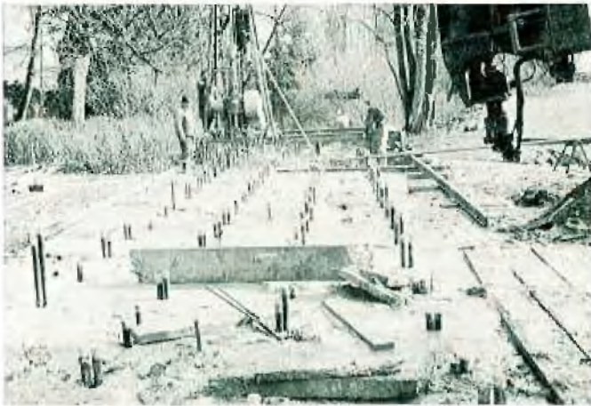
Abb. 2: Bohren der Gefrierlöcher
