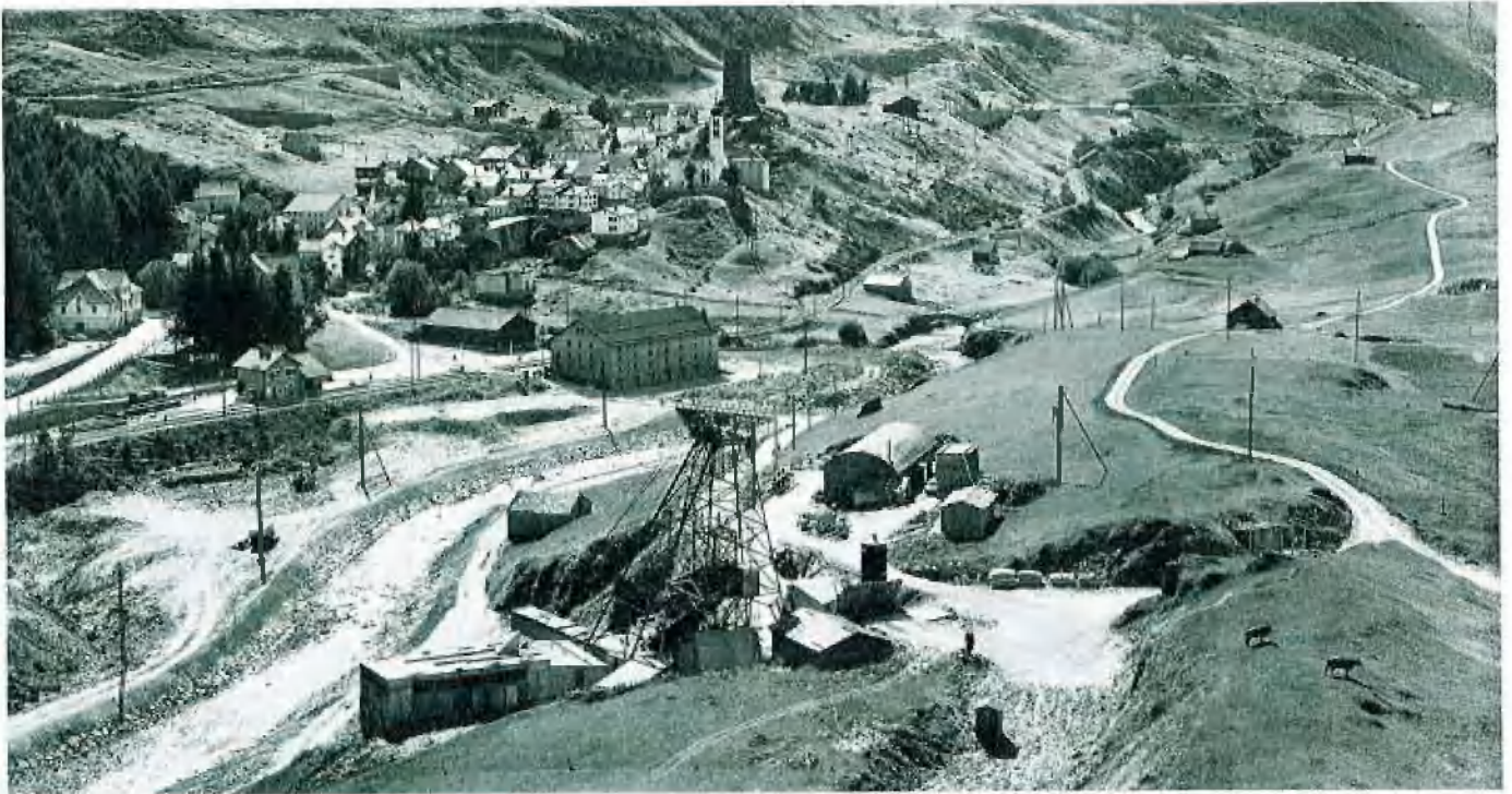
Schachtabteufen am St. Gotthard
