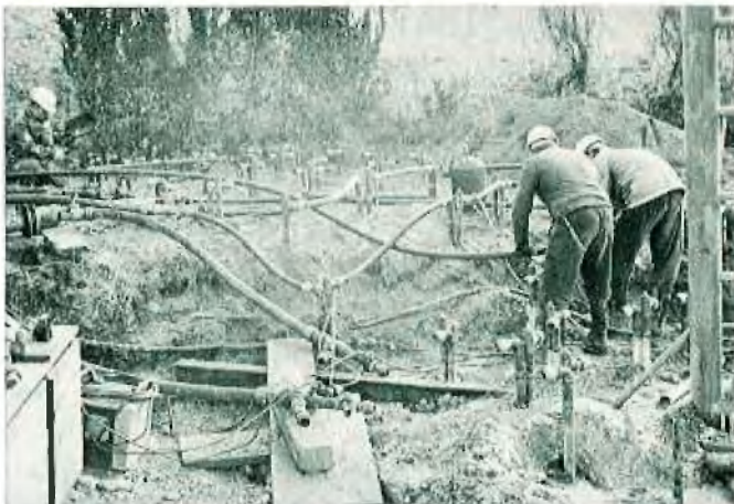
Abb. 3: Anschließen der Gefrierrohre
