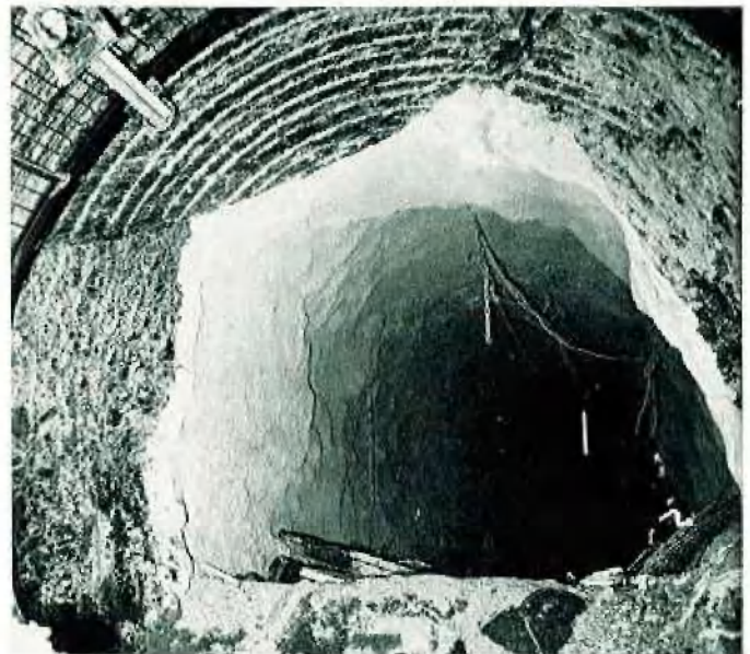
Gebirge im Bereich des Durchschlages
