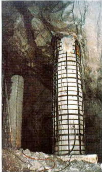
Wechselschalung mit eingehängtem Bullflex-Schlauch
