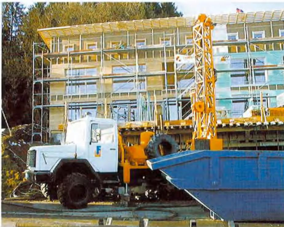
Erdwärmesondenbohrung in Österreich
