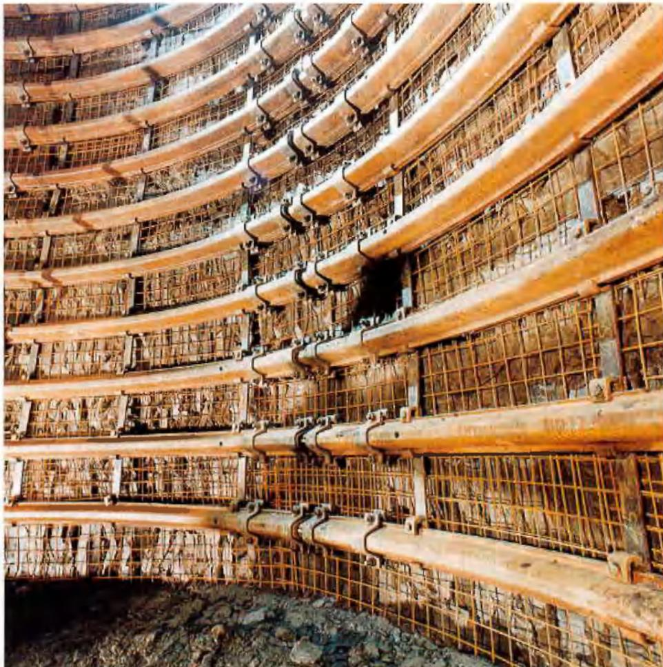
Ringausbau mit Konvergenzmessstellen
